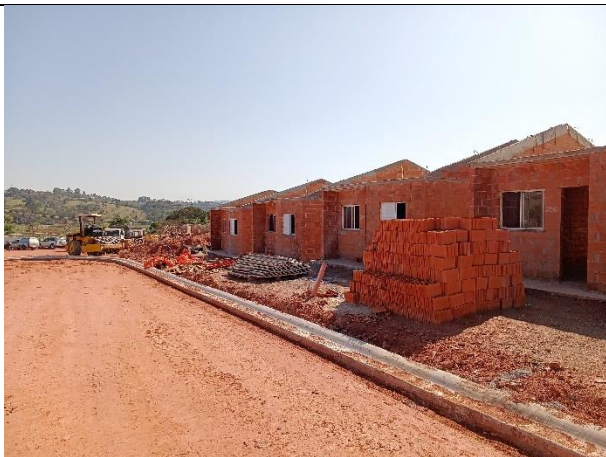
Casas em execução
