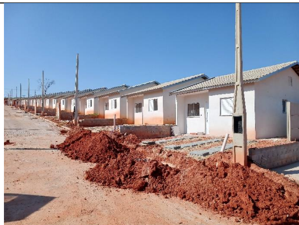
Postes e Pavimentação
