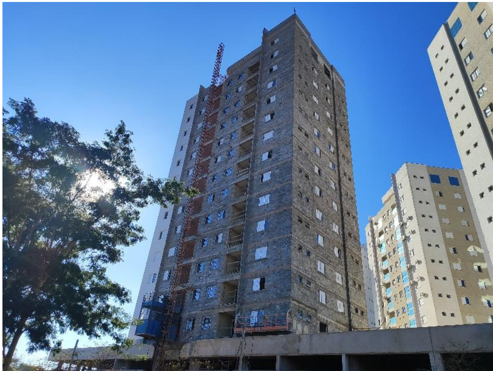
Vista Fachada Torre 03 – Foto dia 29/mai/24
