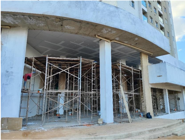
Forro de Gesso – Lojas
