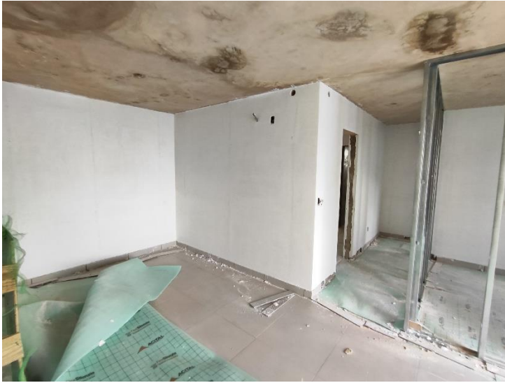
Estrutura Parede Drywall – 13º pav
