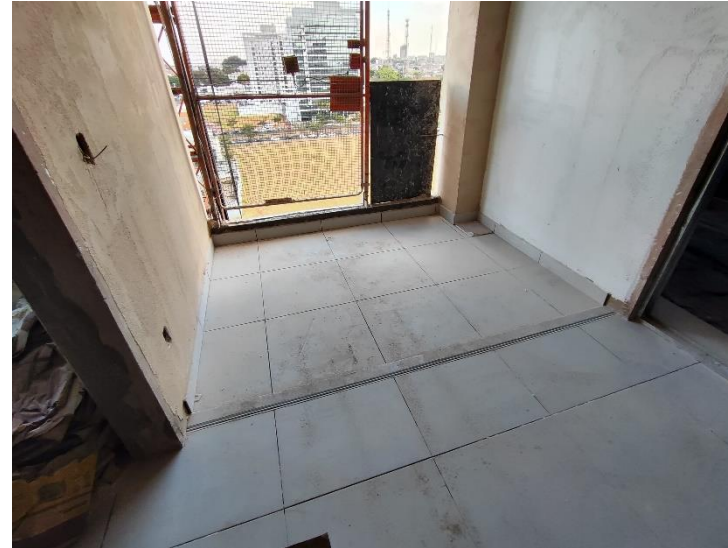
Piso Cerâmico – 12º pav
