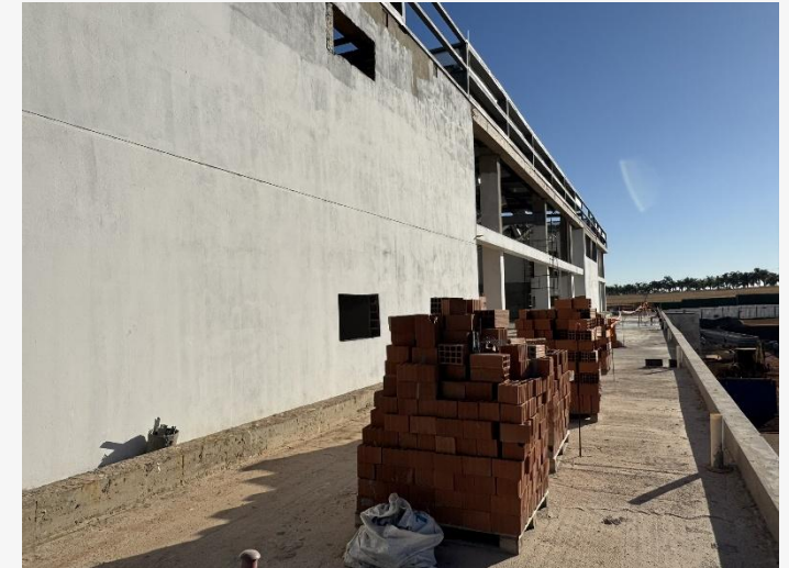
Aplicação de Fundo Selador Externo – 1º Pav.
