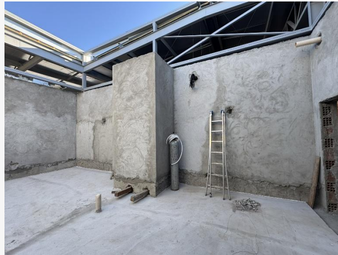
Reboco Interno – 2º Pav.
