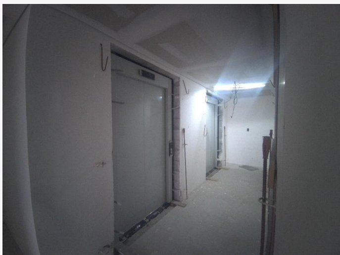
Montagem de Elevadores – 20º Pav.
