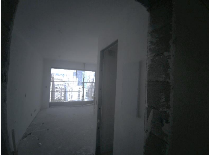
Pintura Interna – 15º Pav.
