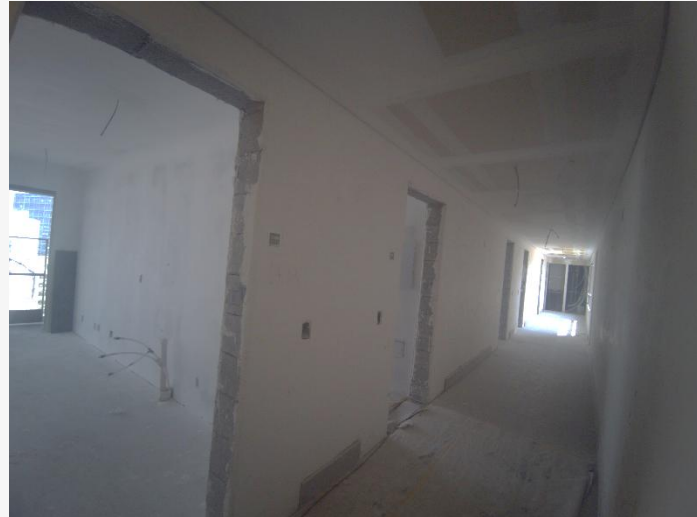
Forro de Gesso – 14º Pav.
