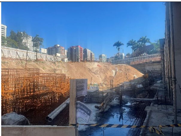
Escavação a ser executada
