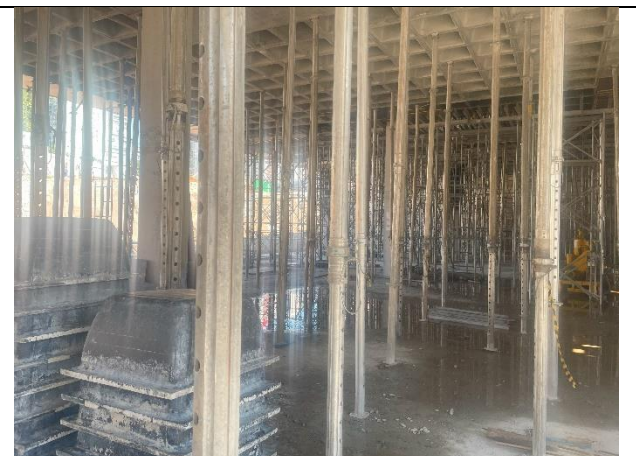
Piso de concreto
