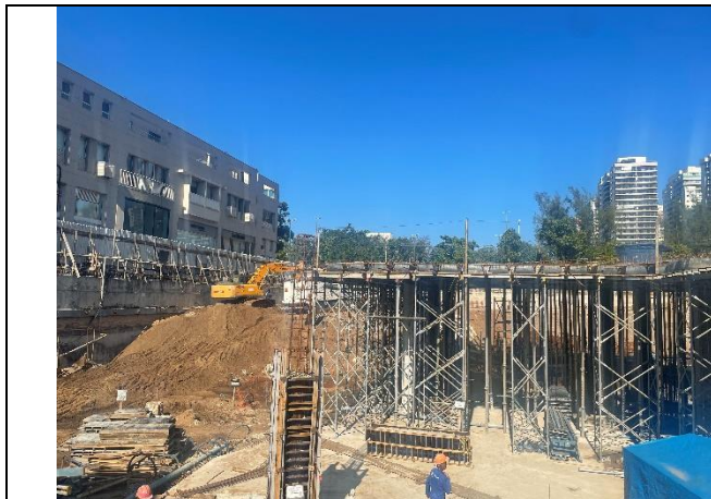
Vista da Obra
