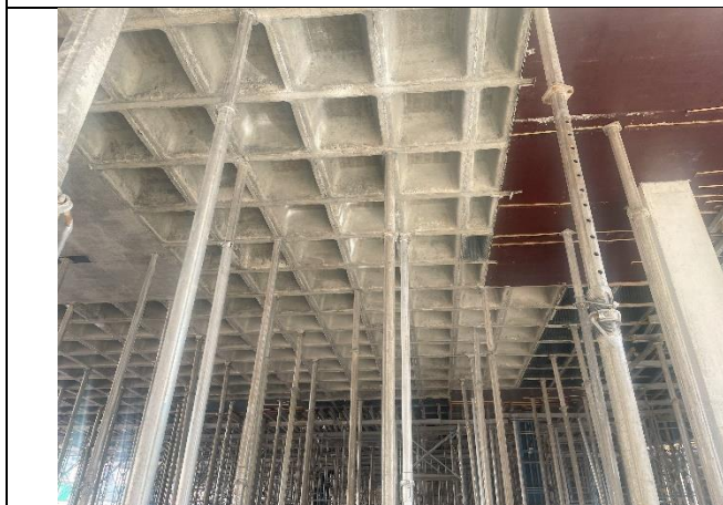
Laje nervurada
