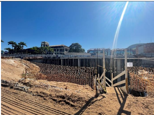
Vista da Estrutura
