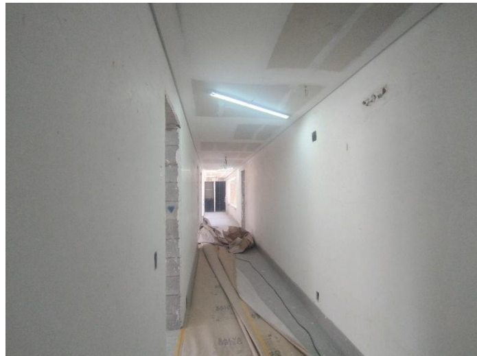
Forro de Gesso – 5º Pav
