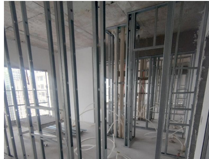
Estrutura Drywall – 23º Pav
