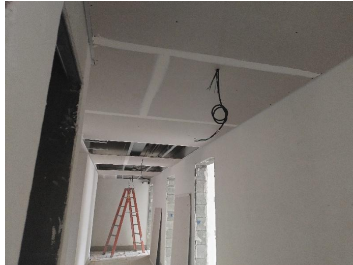
Forro de Gesso – 11º Pav
