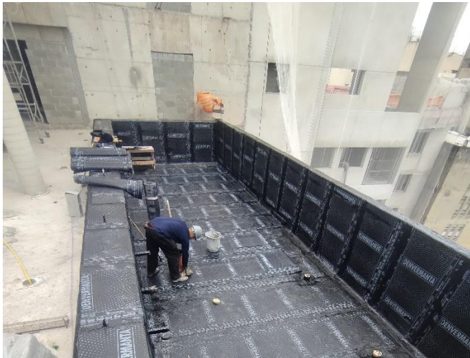
Impermeabilização da Piscina – 25º Pav
