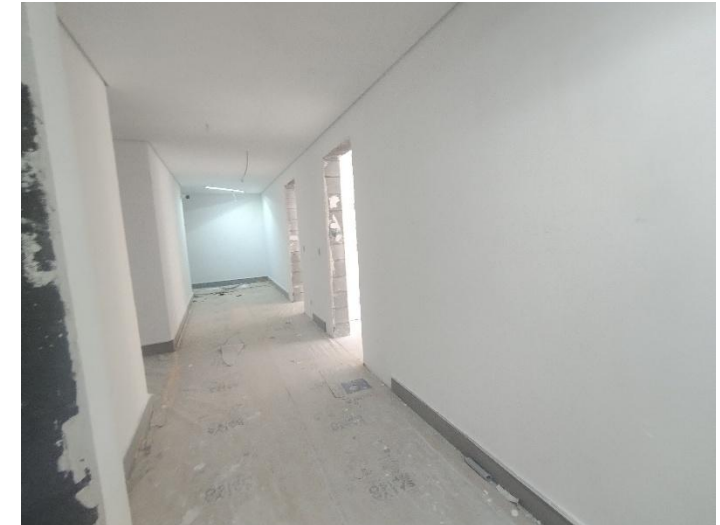
Pintura Interna – 3º Pav
