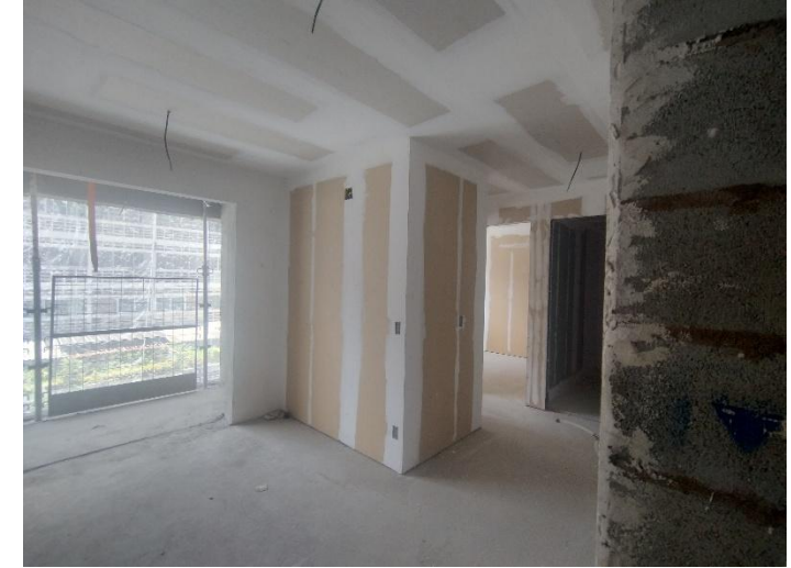
Alvenaria em Drywall – 8º Pav
