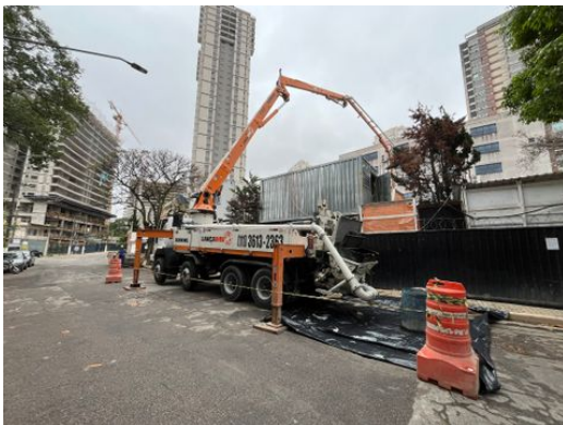
Bomba de concreto para concretagem de parte da laje do Térreo
