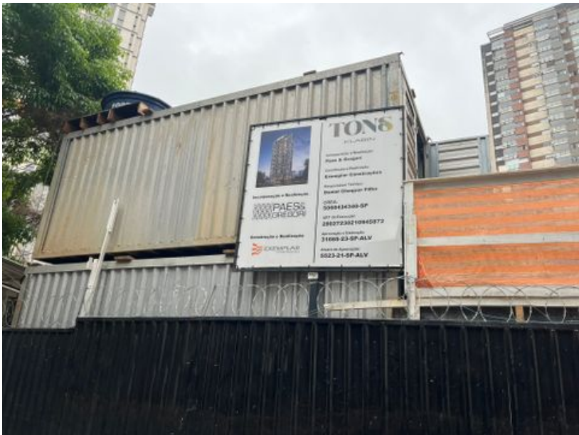
Placa da Construtora
