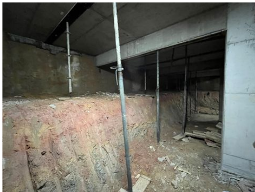
Trecho de terra a ser retirada no 3.º subsolo
