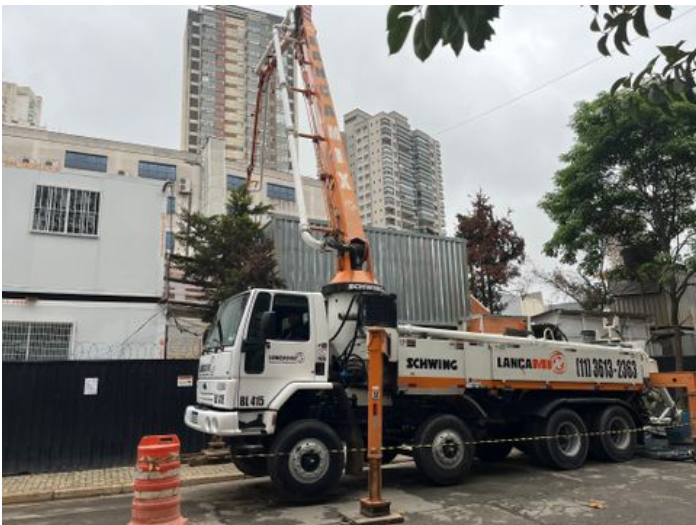
Bomba de concreto
