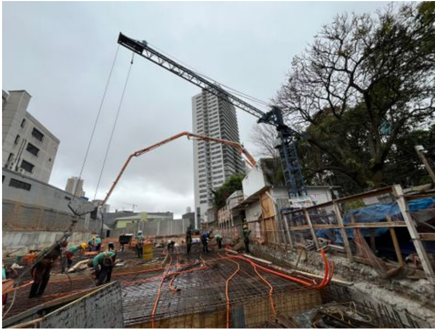
Passagem de funcionários sob raio da mini grua
