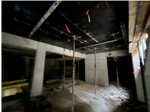
Escoramentos no 2.º subsolo
