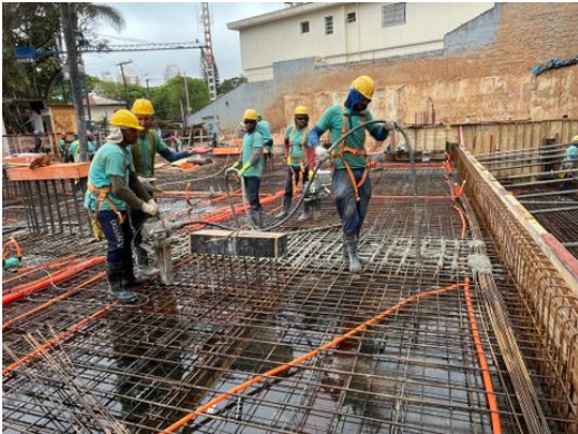
Detalhe da concretagem de viga da laje do Térreo
