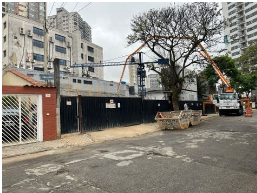
Frente da obra
