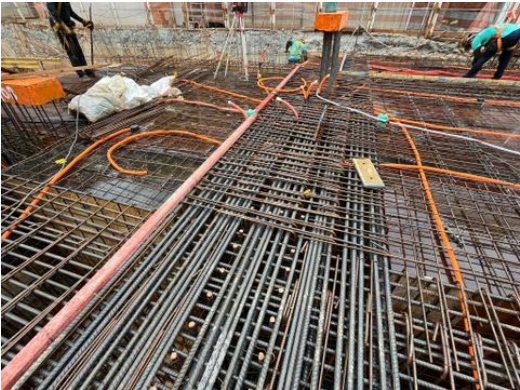
Detalhe do aço na estrutura da laje do Térreo
