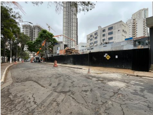
Frente da obra
