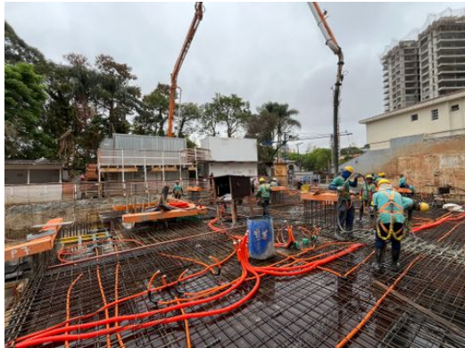
Concretagem de trecho da laje do Térreo
