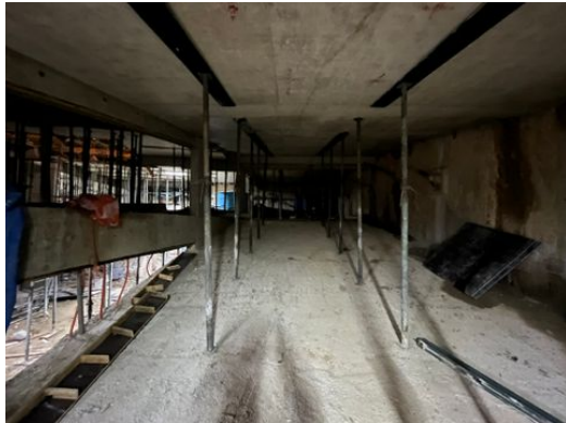
Rampa de acesso ao 2.º subsolo
