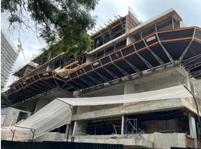
Bandeja primária parcialmente instalada
