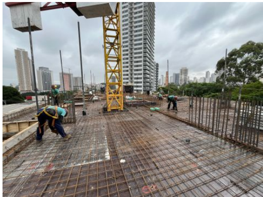
Execução da armação da laje piso do 5.º andar
