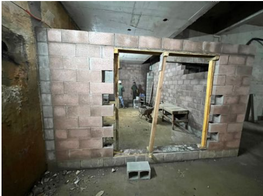
Alvenaria parcialmente executada no 1.º subsolo
