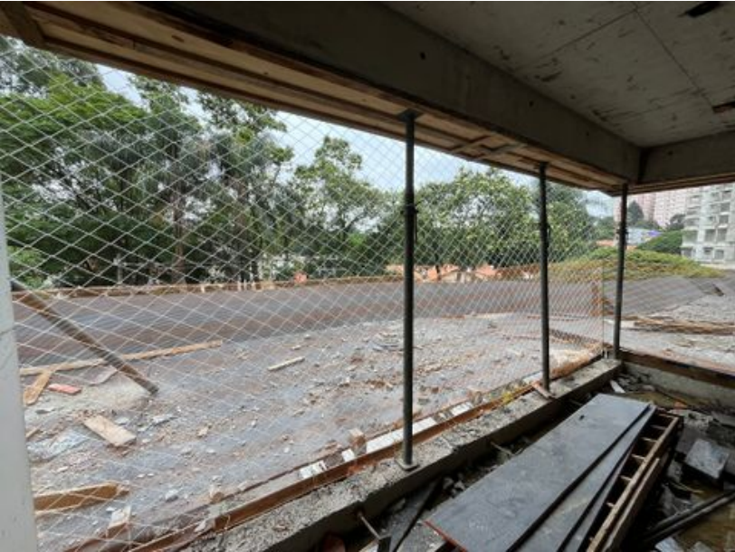
Tela proteção periferia
