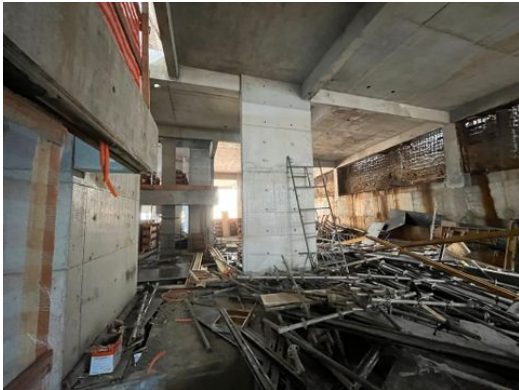
Vista geral da estrutura do Térreo
