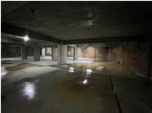
Piso concreto no 3.º subsolo
