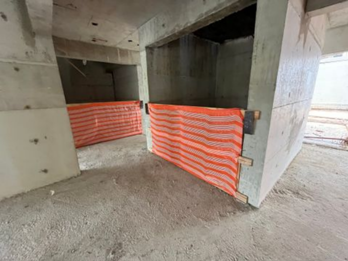
Proteção vãos elevadores
