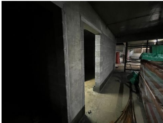
Alvenaria executada no 2.º subsolo
