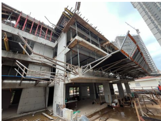
Vista da estrutura
