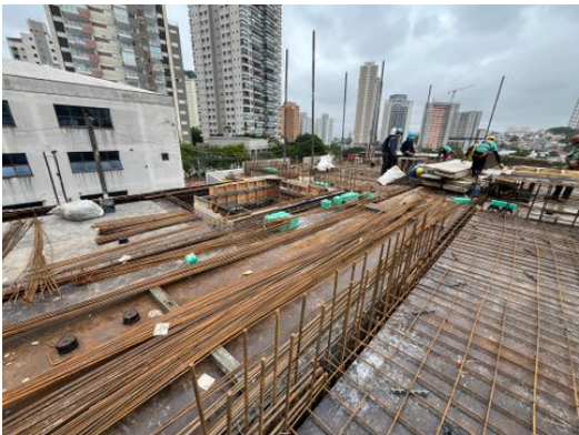
Armação da laje piso do 5.º andar
