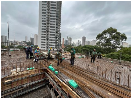
Laje piso do 5.º andar
