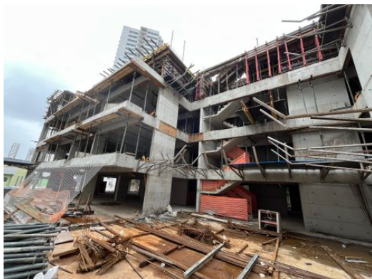
Vista da estrutura
