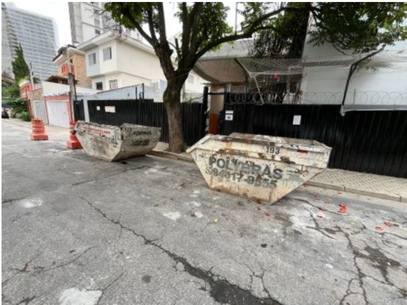
Caçambas na frente da obra
