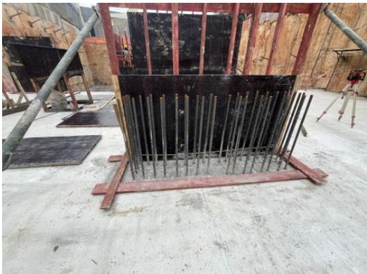
Arranques para execução de pilar da estrutura do Térreo
