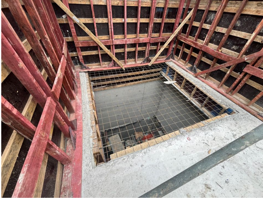
Poço elevador protegido
