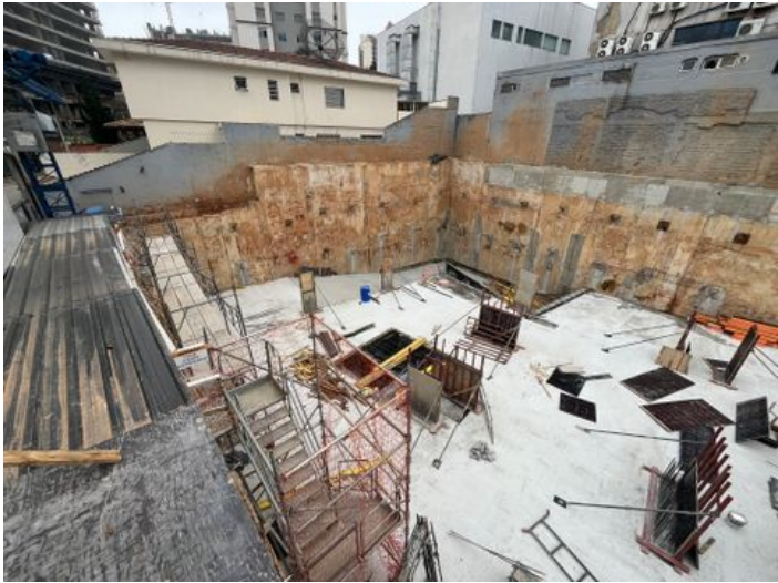
Geral da Obra
