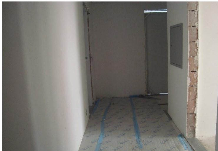
Pintura Interna – 13º Pav
