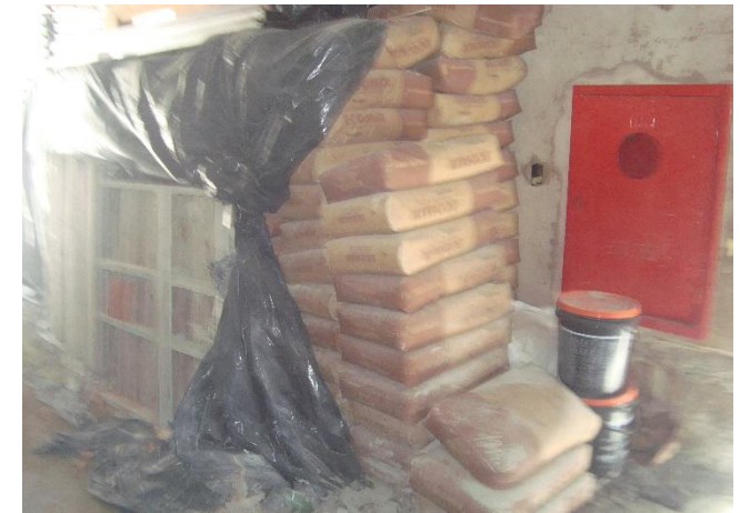
Estoque de Obra (Ensacados)
