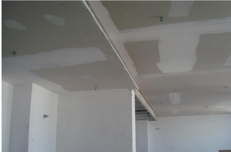
Forro de Gesso – 20º Pav
