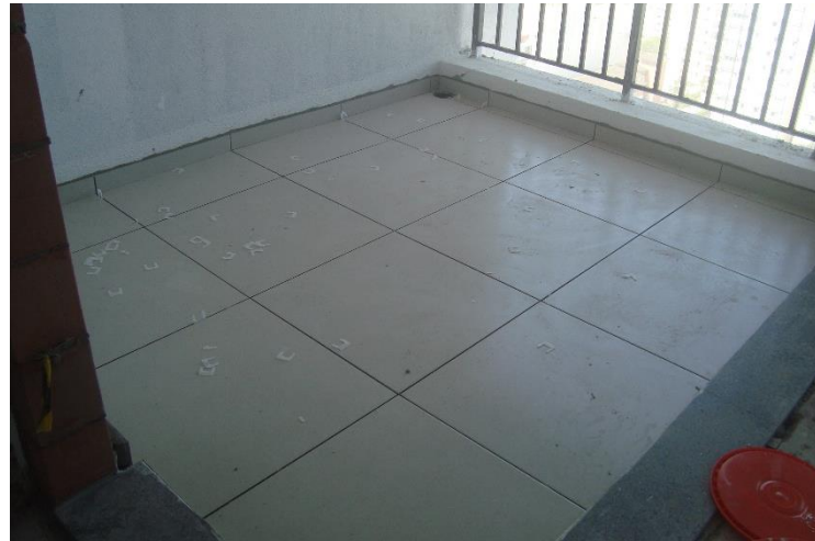
Piso Cerâmico – 18º Pav
