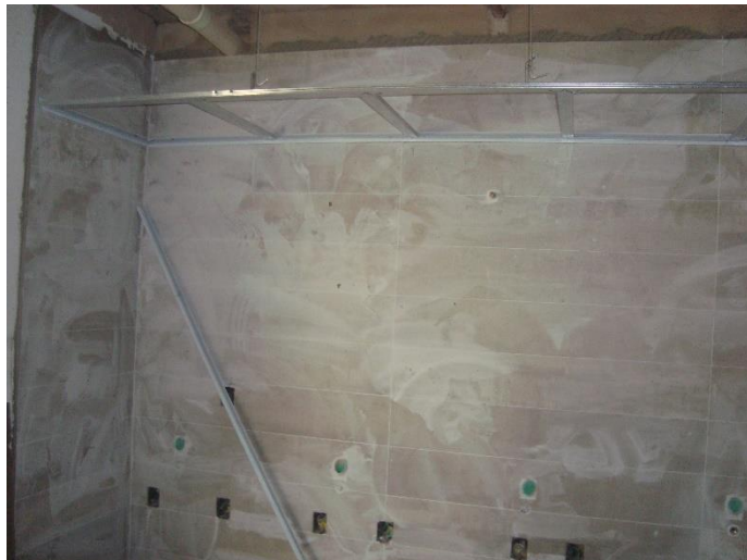
14 Revestimento Cerâmico – 1º Pav
