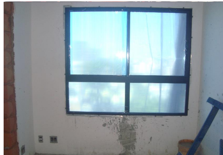
Esquadria de Alumínio – 9º Pav
