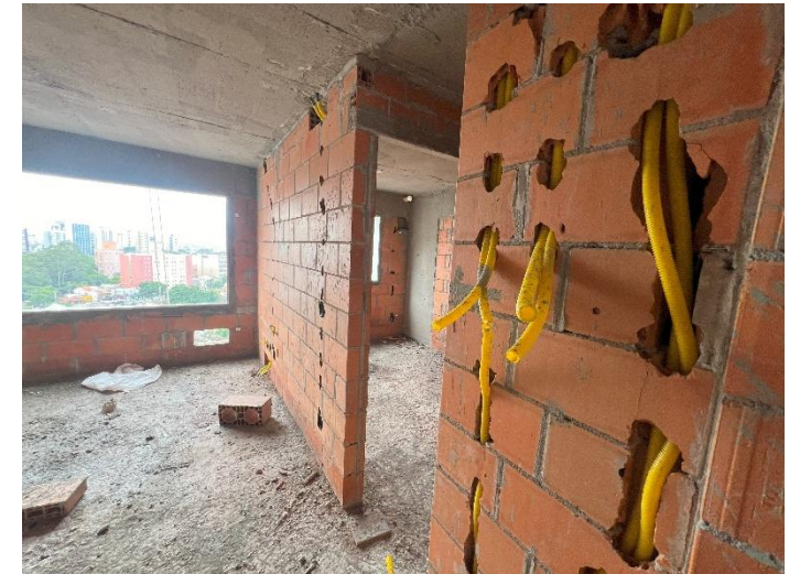
Embutidos em Alvenaria – 16º Pav
