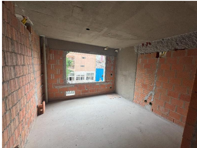
Alvenaria/ Vedação – 3º Pav
