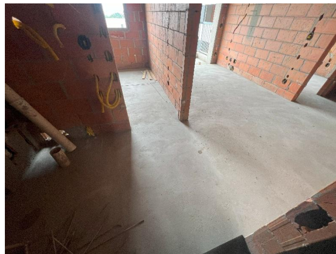
Contrapiso – 14º Pav
