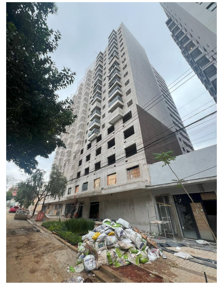
Textura Fachada Lateral
