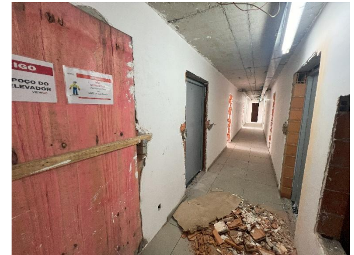
Proteção de Vãos do Elevador
