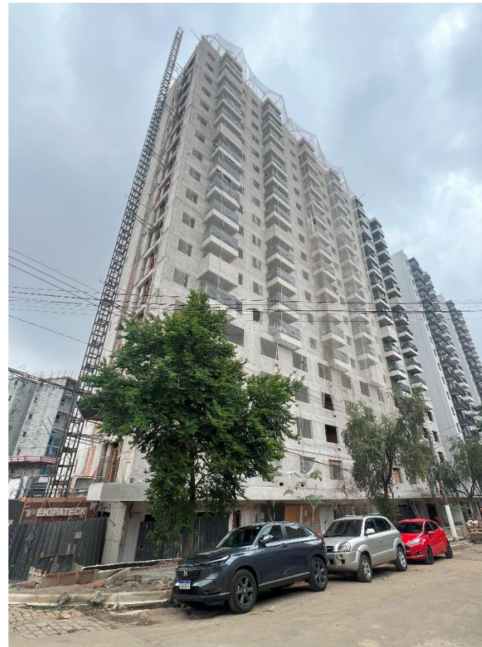
Vista Fachada Posterior
