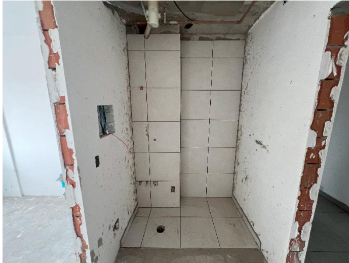
Revestimento Cerâmico – 7º Pav
