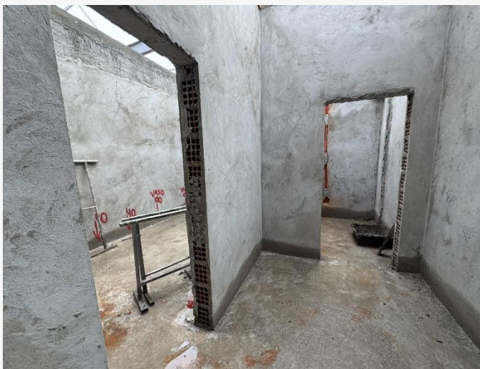
Reboco Interno – 2º Pav.
