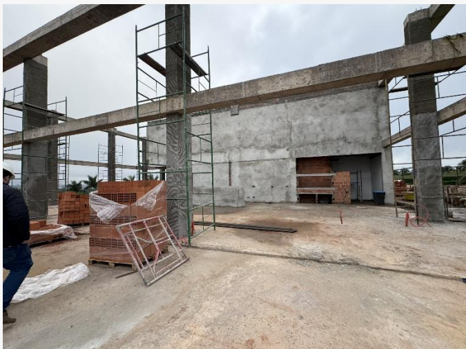
Reboco Externo – 1º Pav.
