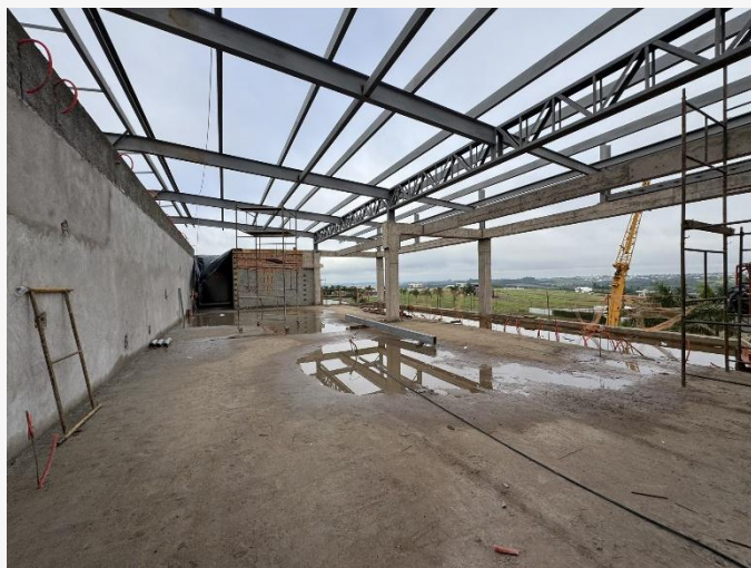
Estrutura Metálica para Cobertura – 2º Pav.
