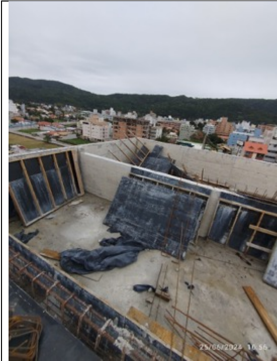
Foto 38 – Estrutura da piscina concretada
