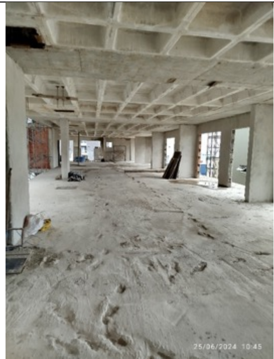
Foto 28 – Estrutura desformada
