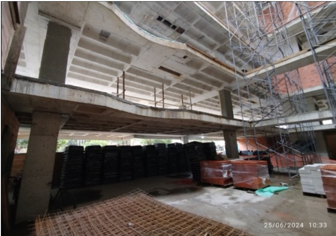
Foto 12 – Armazenamento de material no canteiro
