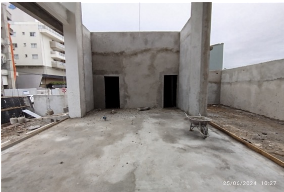
Foto 2 – Execução de reboco interno
