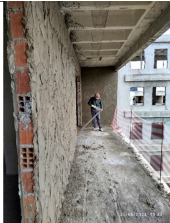
Foto 25 – Execução de reboco externo
