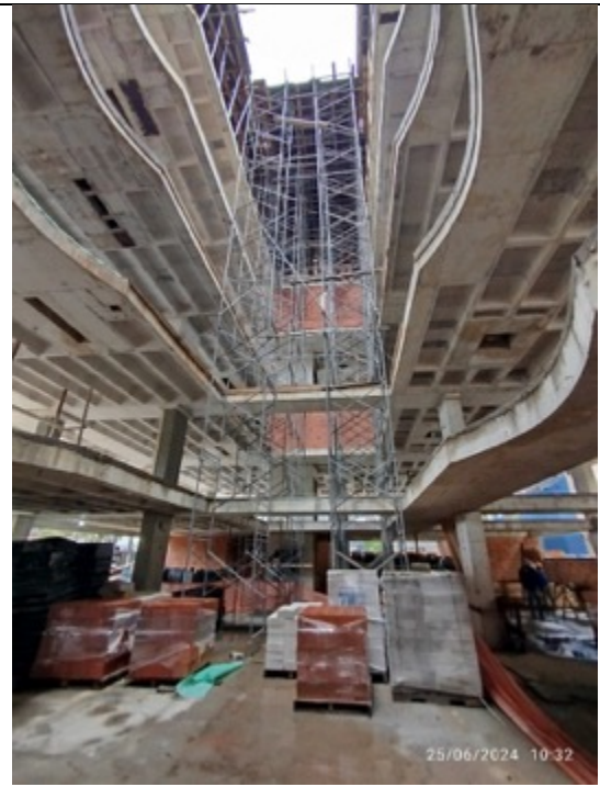
Foto 10 – Vista da estrutura
