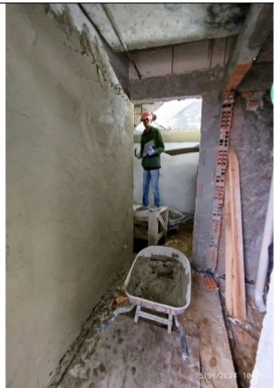
Foto 6 – Execução de reboco interno
