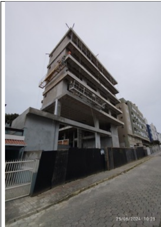
Foto 3 – Vista da fachada frontal e lateral esquerda
