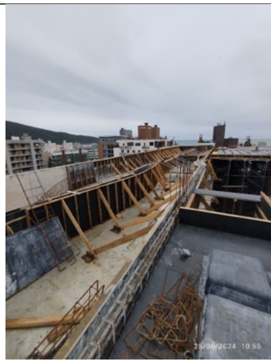
Foto 37 – Execução de formas
