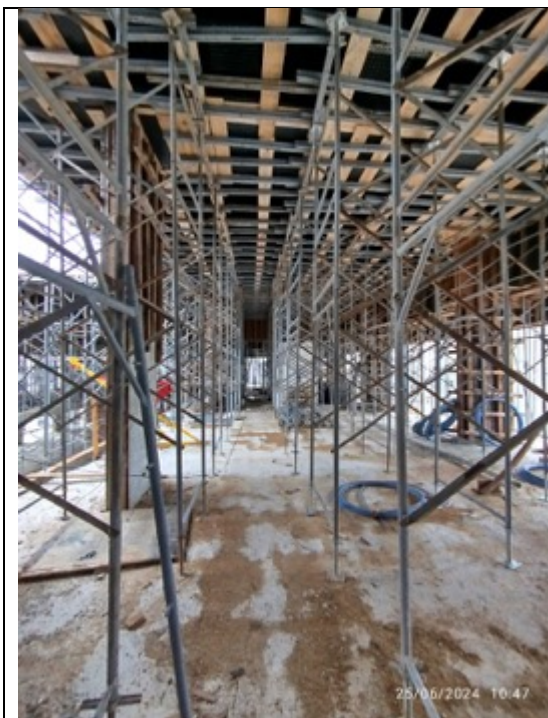
Foto 31 – Escoramento metálico
