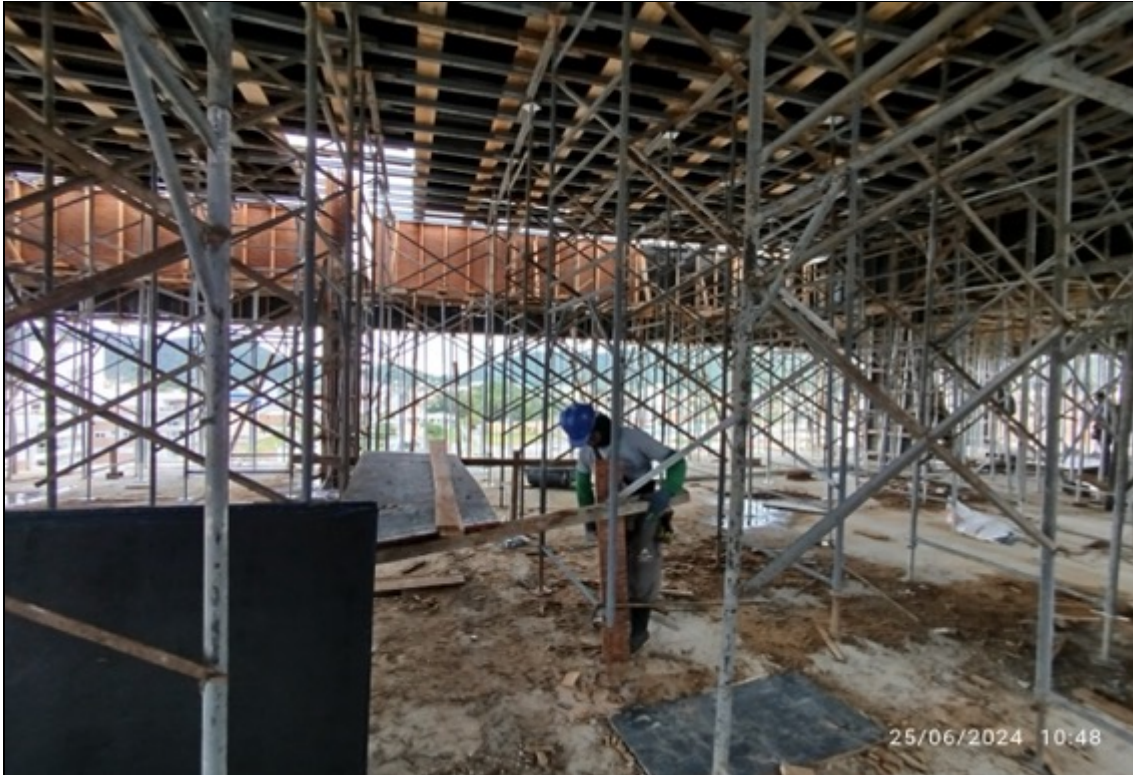
Foto 33 – Execução de travamento de escoramento
