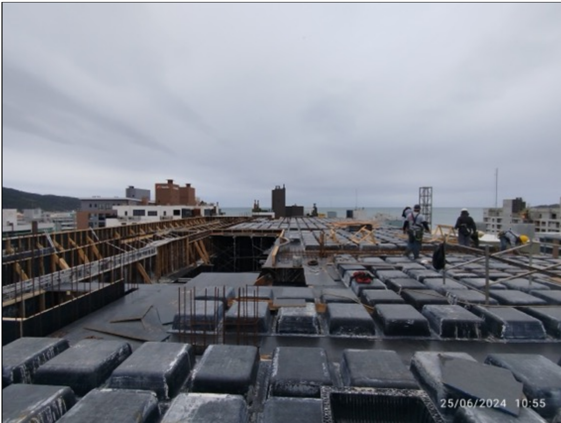
Foto 35 – Execução de formas
