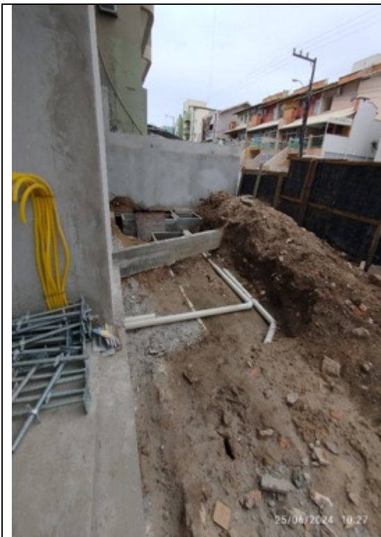
Foto 5 – Enterrados – Esgoto e drenagem
