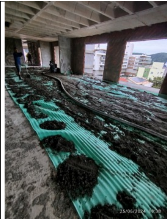
Foto 24 – Execução de contrapiso
