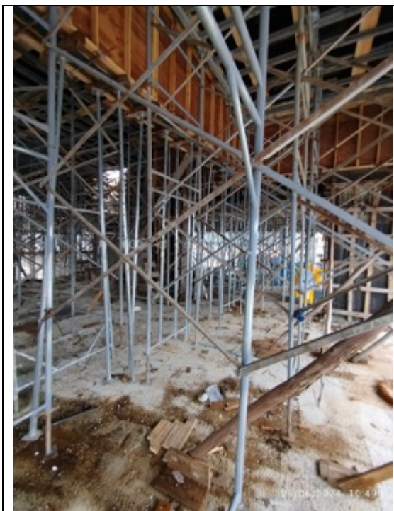
Foto 36 – Escoramento metálico
