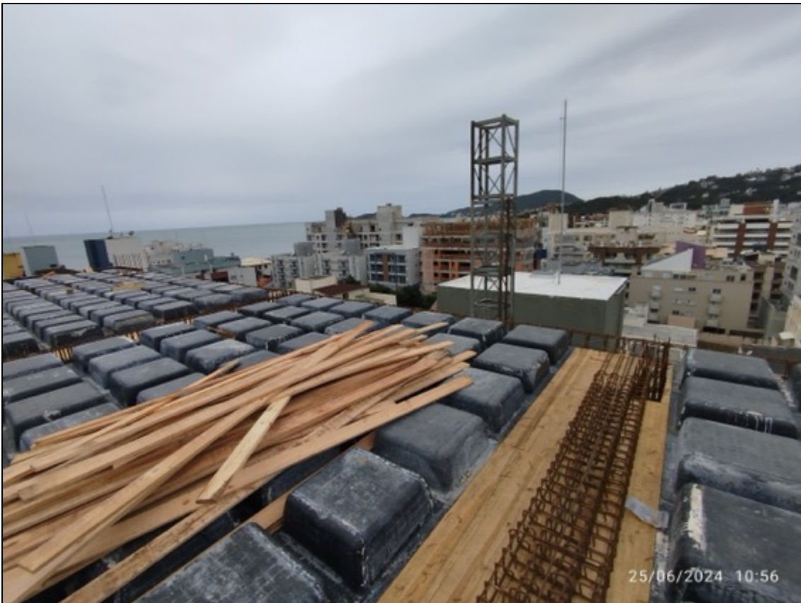
Foto 40 – Execução de armação e formas
