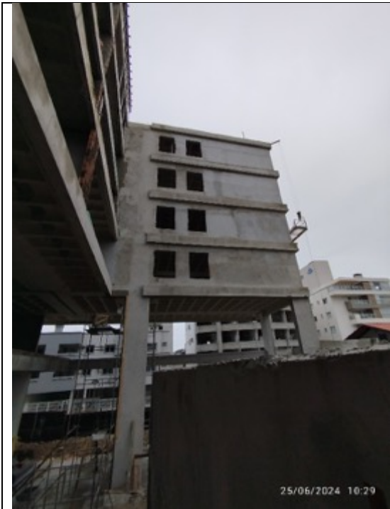
Foto 9 – Execução de reboco externo
