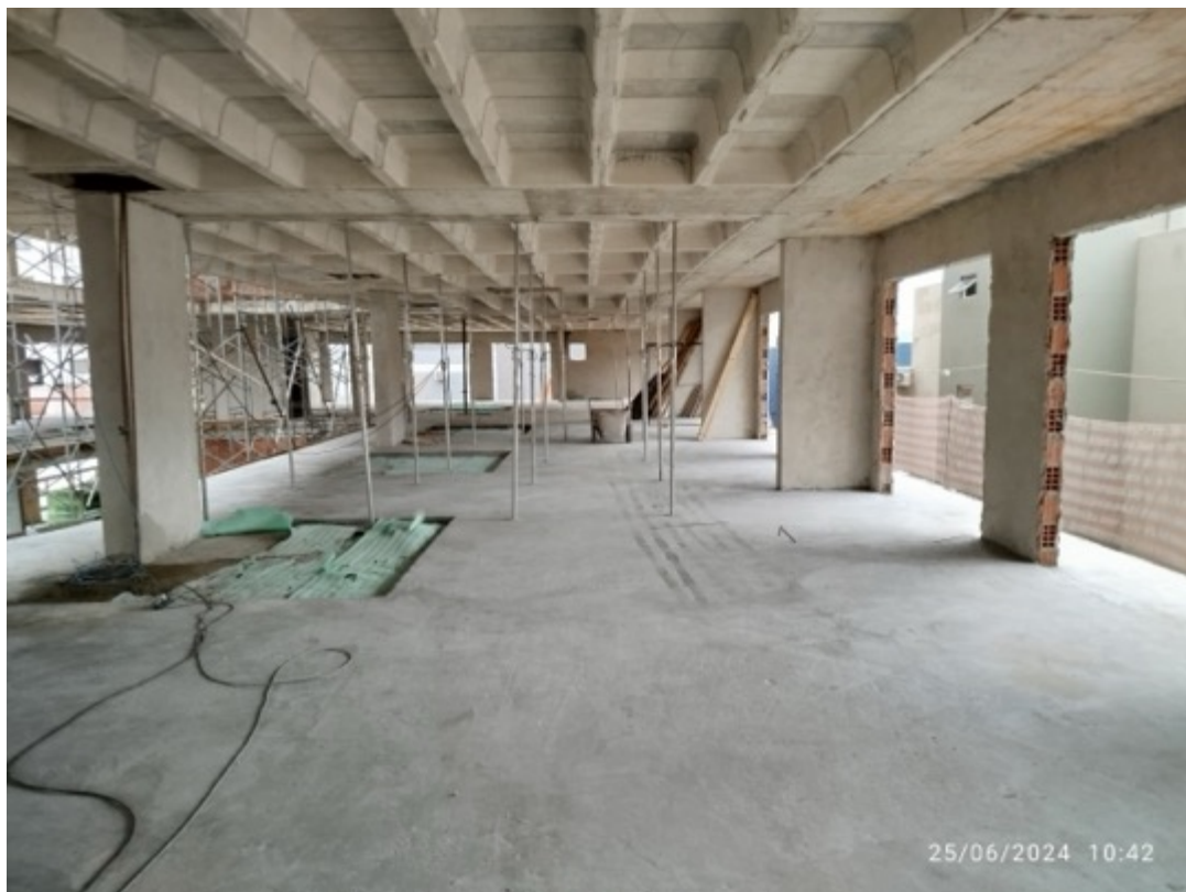
Foto 23 – Execução de contra piso e reboco interno
