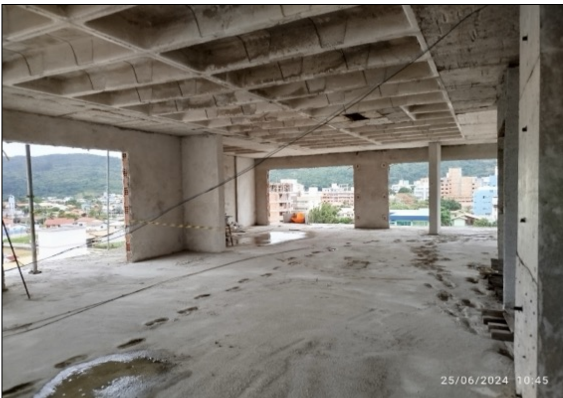
Foto 29 – Estrutura desformada
