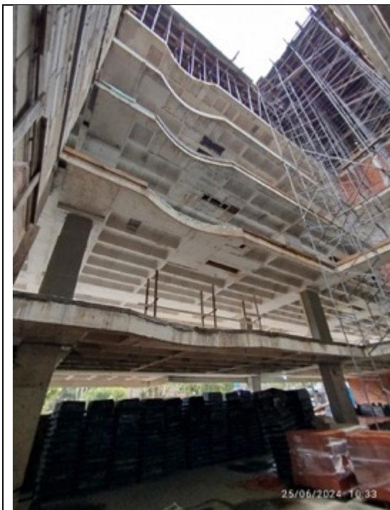
Foto 15 – Vista da estrutura interna
