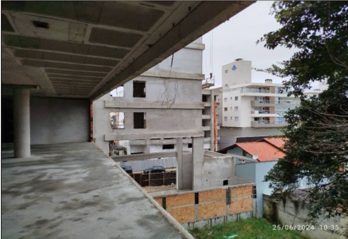
Foto 14 – Contra piso – vista da fachada
