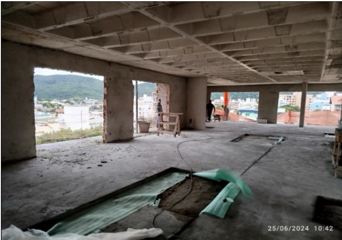
Foto 22 – Execução de contrapiso
