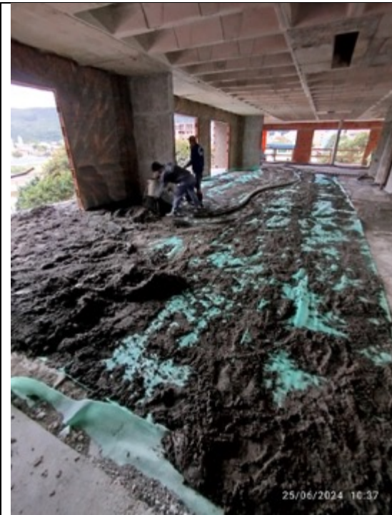
Foto 19 – Execução de contrapiso
