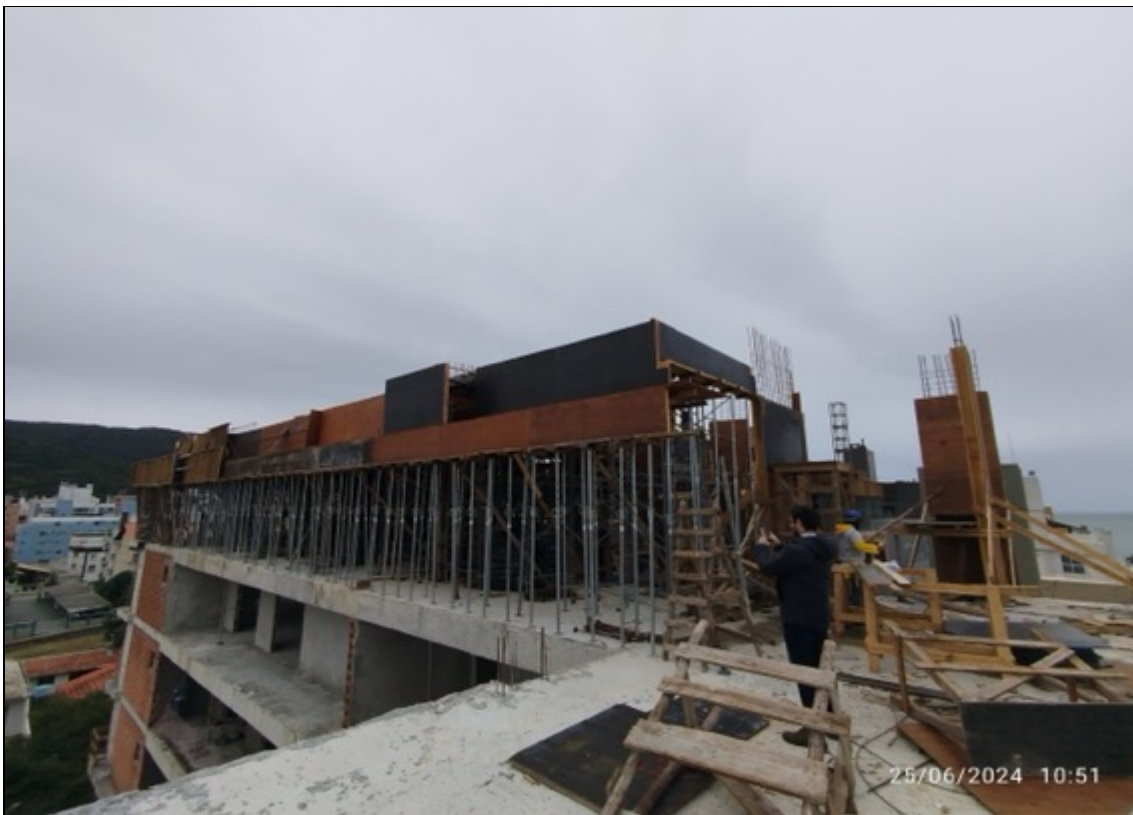
Foto 34 – Execução de escoramento e fechamento de formas
