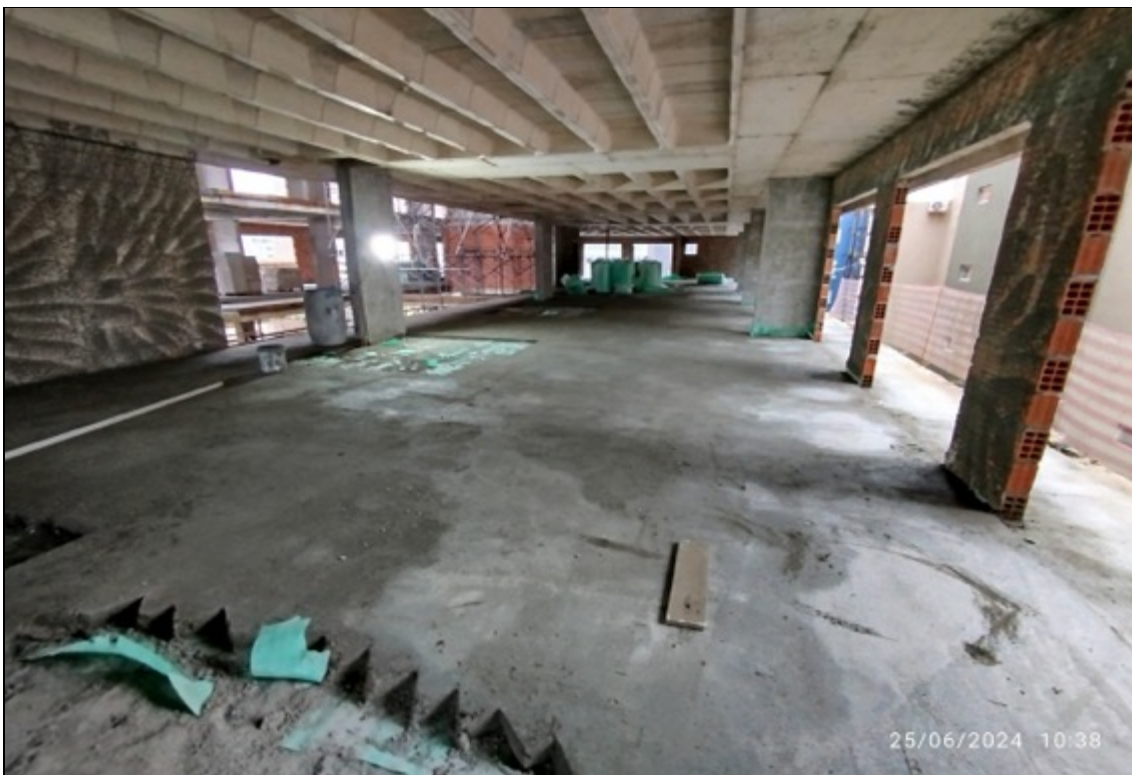
Foto 21 – Execução de contrapiso
