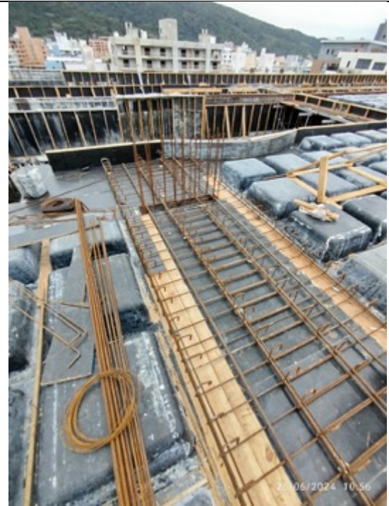
Foto 39 – Execução de armação
