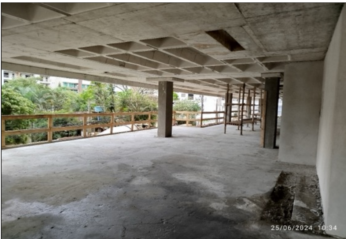
Foto 13 – Contra piso executado
