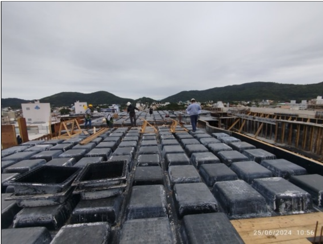
Foto 41 – Execução de formas
