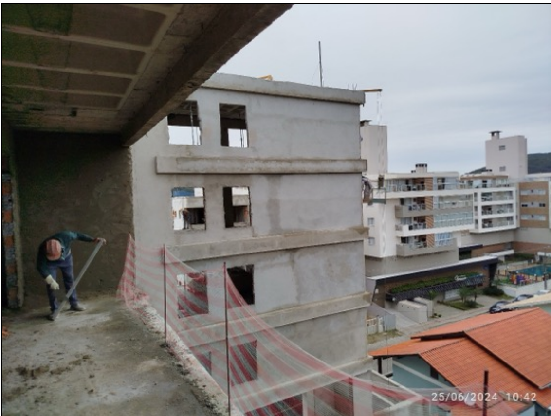
Foto 26 – Execução de reboco externo
