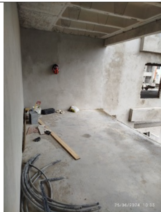
Foto 16 – Reboco e contra piso
