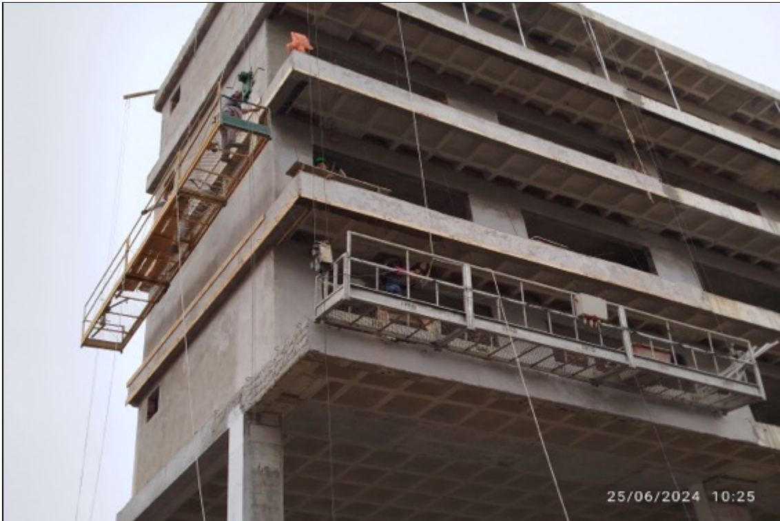
Foto 1 – Execução de reboco externo
