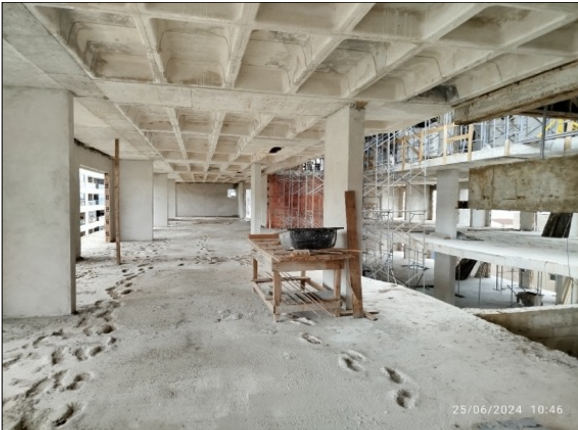
Foto 30 – Estrutura desformada
