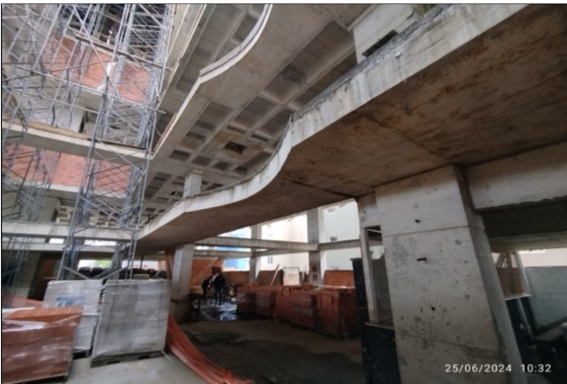
Foto 11 – Armazenamento de material no canteiro
