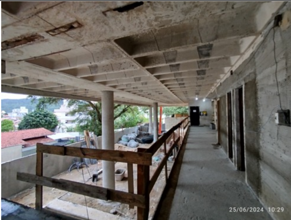
Foto 8 – Corredor de acesso ao escritório da engenharia
