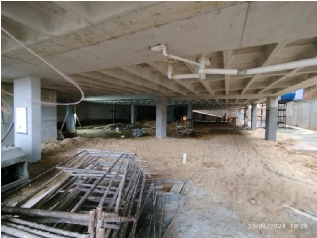
Foto 7 – Vista da garagem
