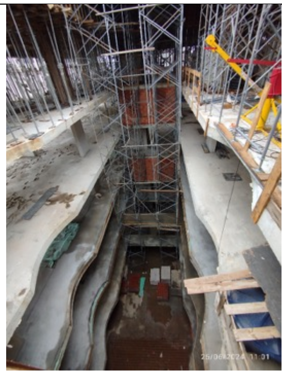
Foto 43 – Vista do vão interno na estrutura
