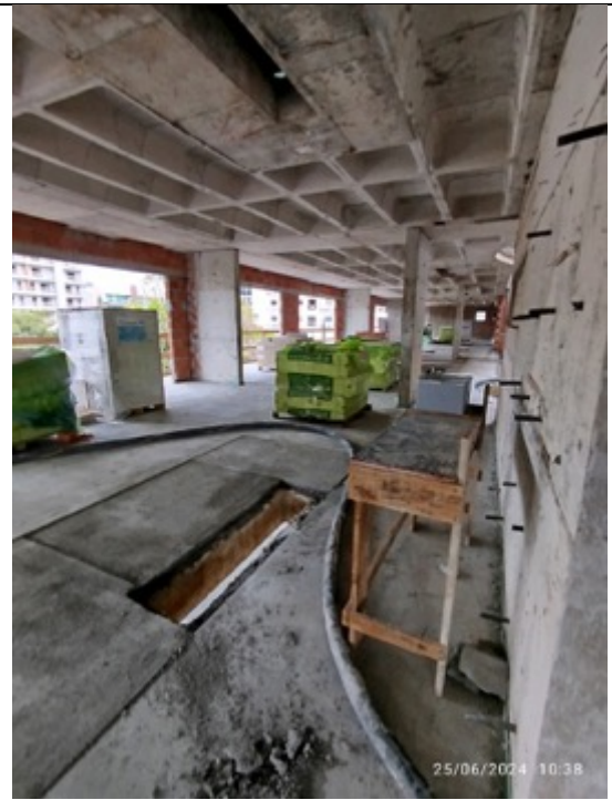
Foto 20 – Execução de contrapiso
