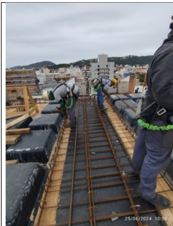
Foto 42 – Execução de armação
