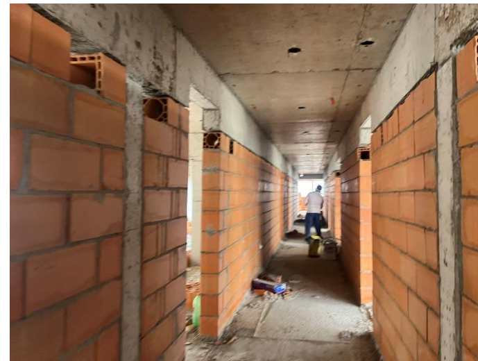
Alvenaria/ Vedação – 5º Pav
