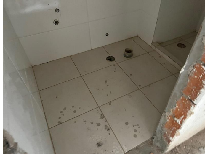
Piso Cerâmico – 2º Pav
