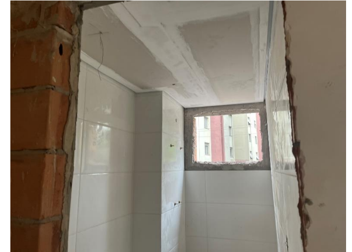
Forro de Gesso – 1º Pav
