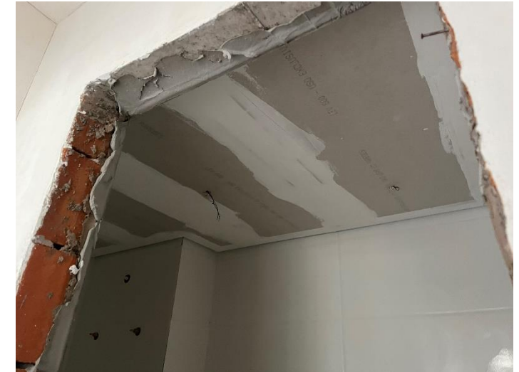
Forro de Gesso – 4º Pav
