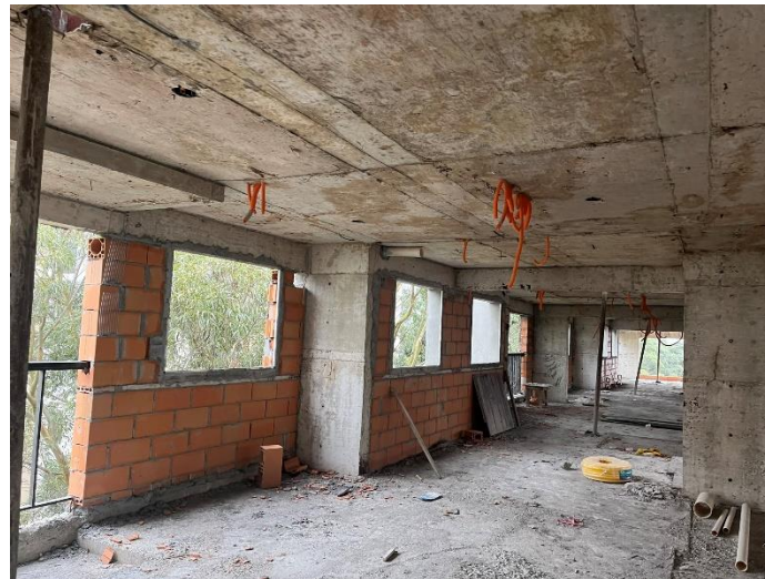
Alvenaria/ Fechamento – 8º Pav
