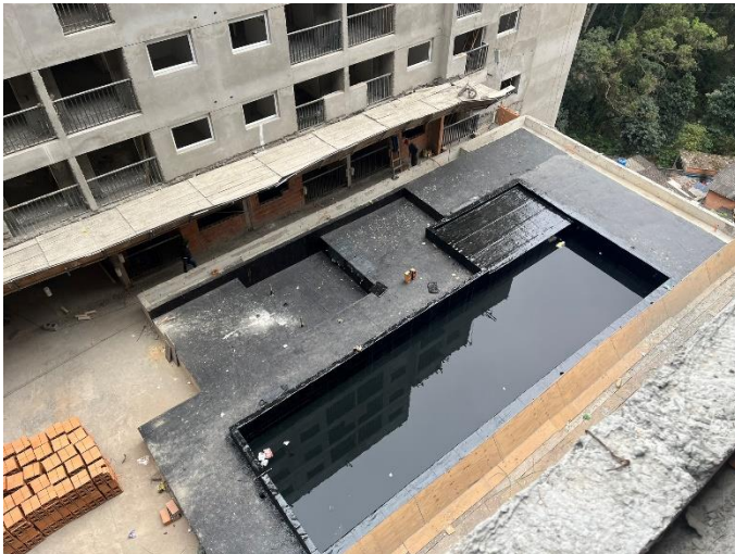
Impermeabilização Piscina – Térreo
