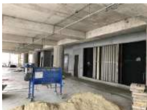
VISTA INTERNA DO IMÓVEL
