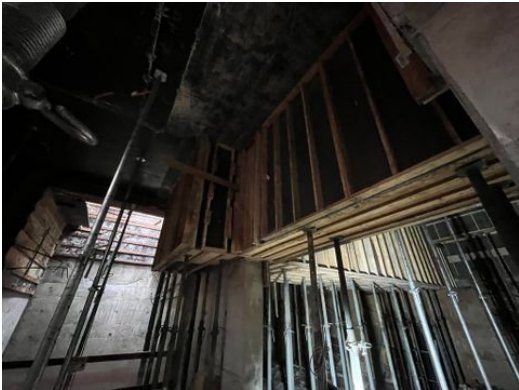
Escoramento de viga no 1.º subsolo
