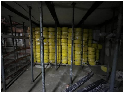
Tubulação elétrica - alvenaria
