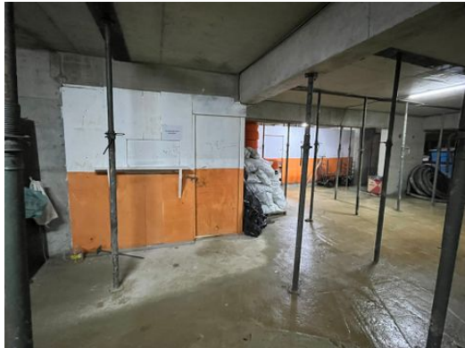
Almoxarifado construído no 2.º subsolo
