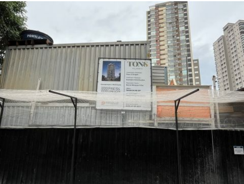
Placa da Construtora
