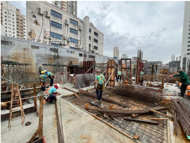
Trecho de laje do mezanino e preparo da estrutura para concretagem da laje piso do 1.º andar
