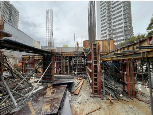
Vista geral da laje do Térreo
