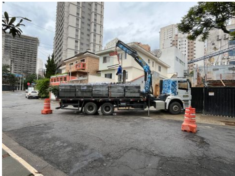
Blocos de concreto sendo descarregados na obra
