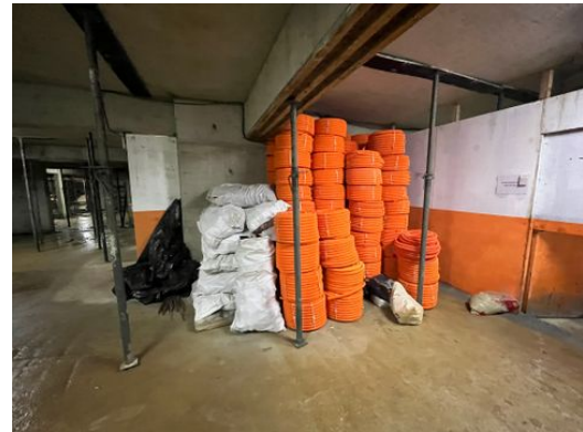
Tubulação elétrica - estrutura
