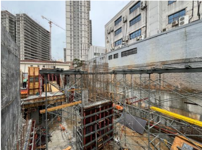
Estrutura do Térreo para 1.º andar
