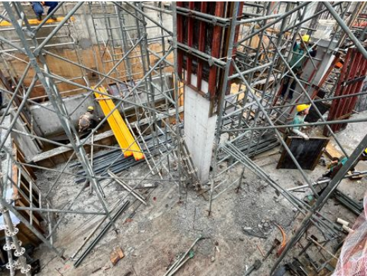
Pilar parcialmente concretado no Térreo, referente laje 1.º andar.
