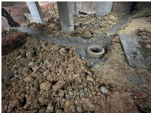
Drenagem em execução no piso do 3.º subsolo
