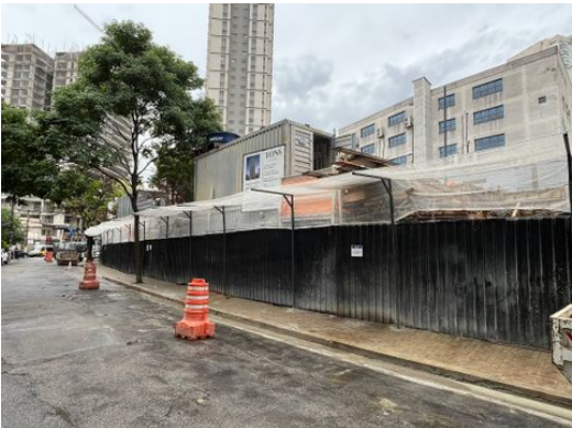
Detalhe das instalações provisórias da obra
