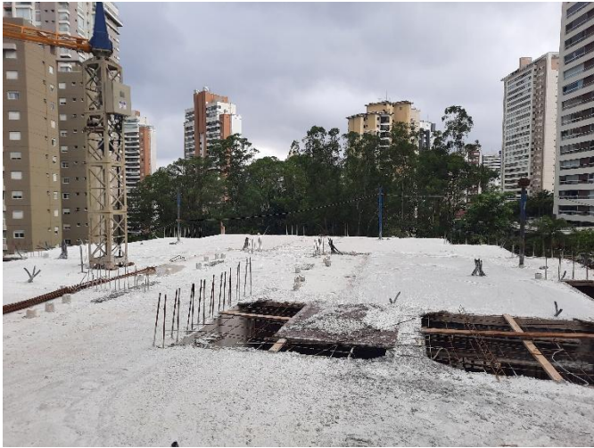
Concretagem de Laje – 10º Pav T Safira
