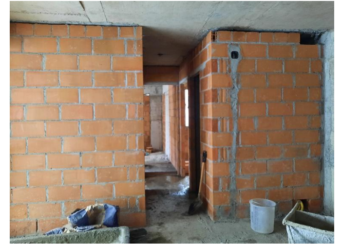
Alvenaria/ Vedação – 7º Pav
