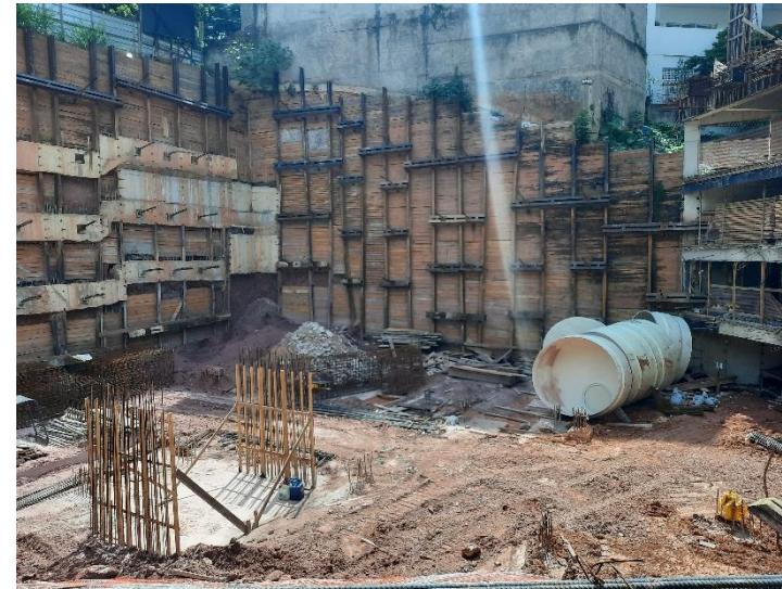
Cortina de Contenção
