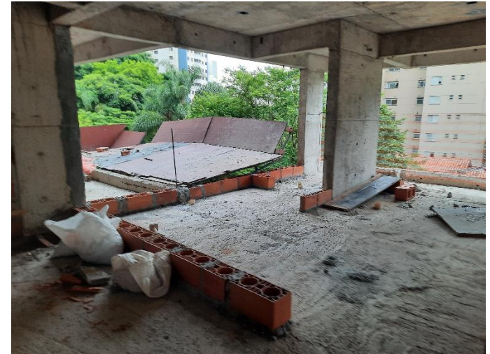
Marcação de Alvenaria – Térreo
