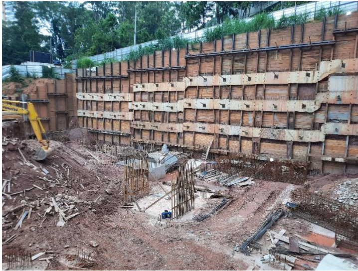
Blocos de Fundação – T Onix
