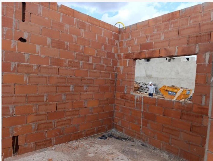
Alvenaria/ Vedação – Bloco 3
