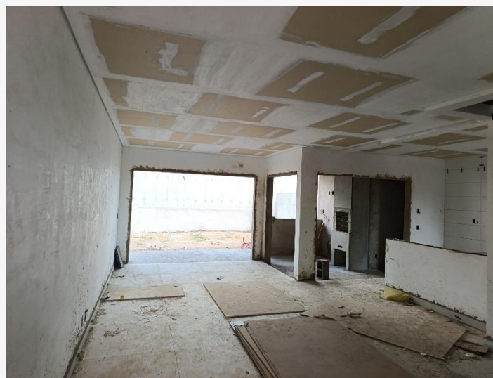
Forro de Gesso – Bloco 1
