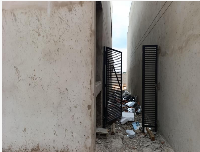
Portão Metálico – Bloco 5
