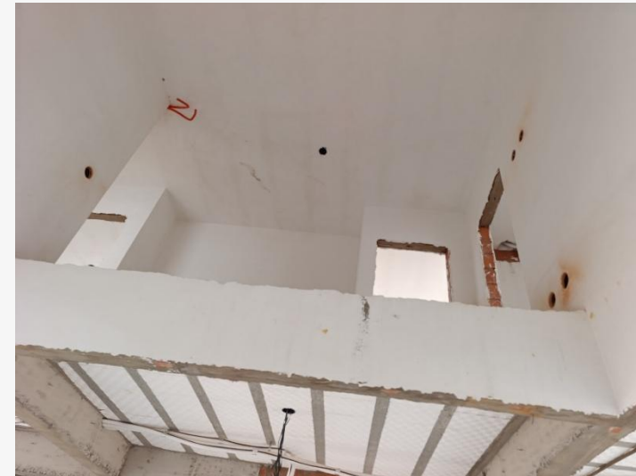
Revestimento Interno – Bloco 5
