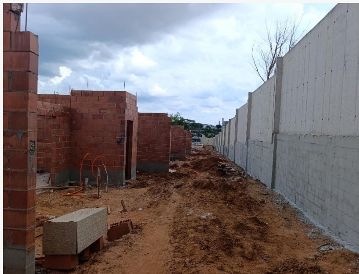
Muro de Fechamento – Bloco 3
