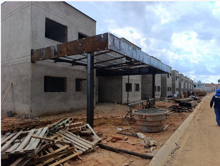
Estrutura para Cobertura – Bloco 5
