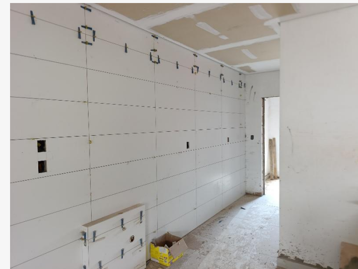
Revestimento Cerâmico – Bloco 1
