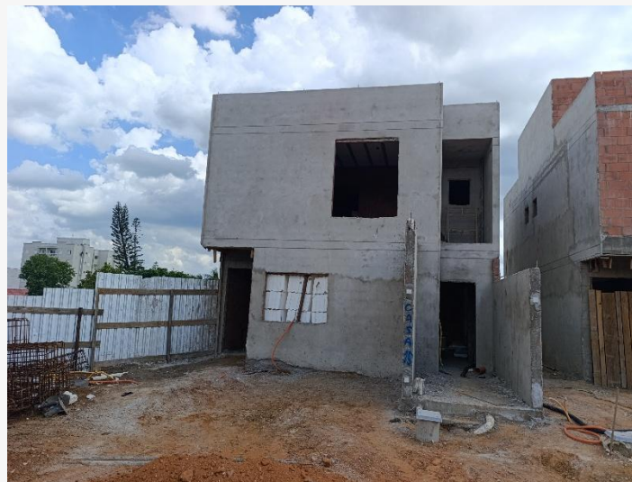
Reboco Externo – Bloco 2
