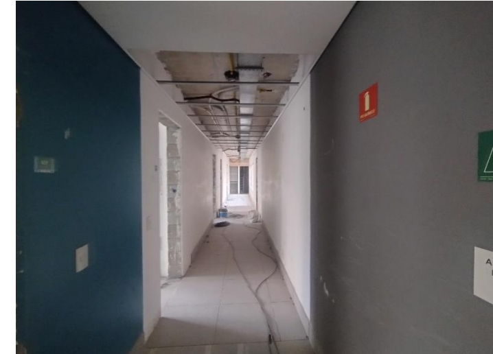
Pintura Interna – 4º Pav
