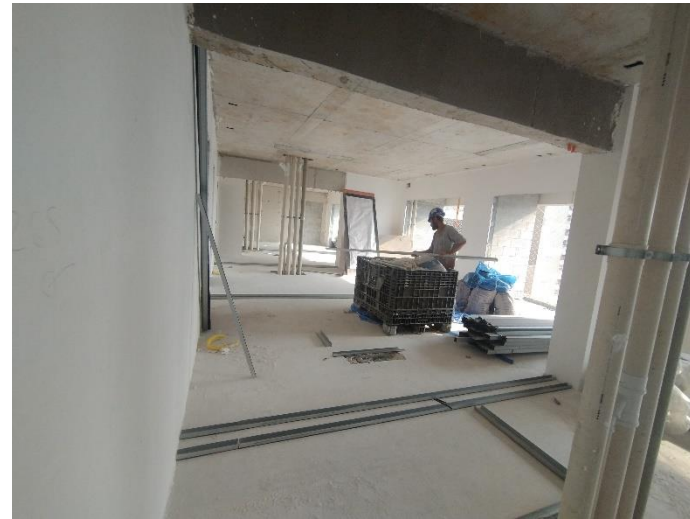
Prumada Hidráulica – 19º Pav
