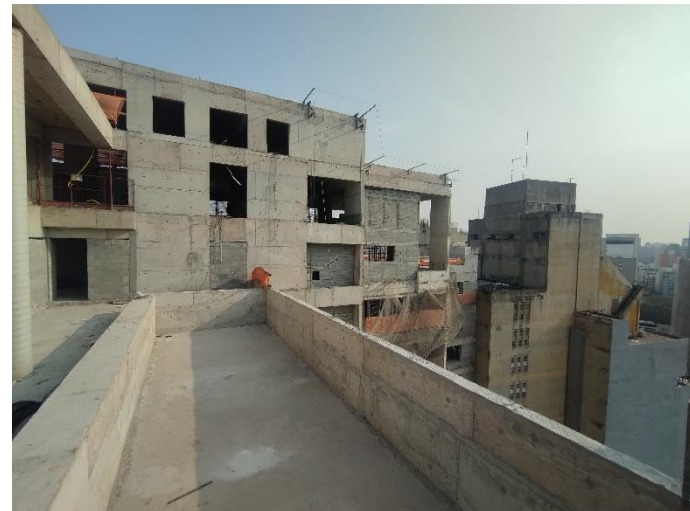
Vista Geral – 25º Pav
