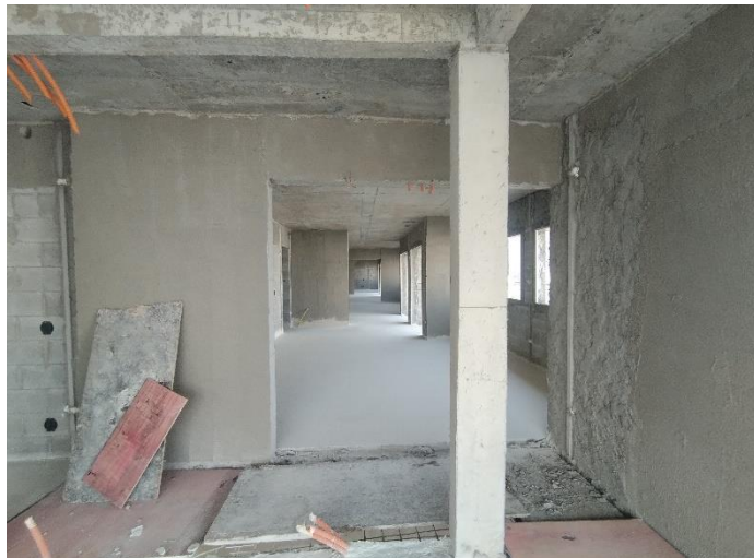
Contrapiso – 21º Pav
