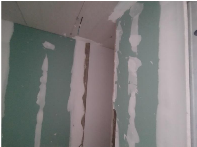
Alvenaria em Gesso – 2º Pav
