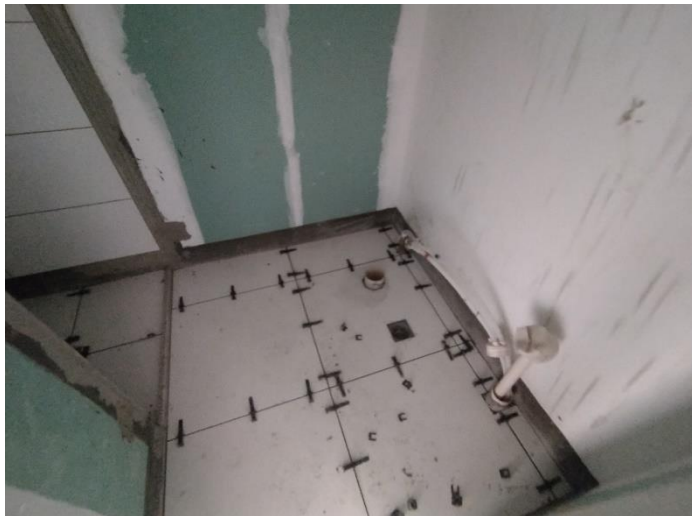
Piso Cerâmico – 5º Pav
