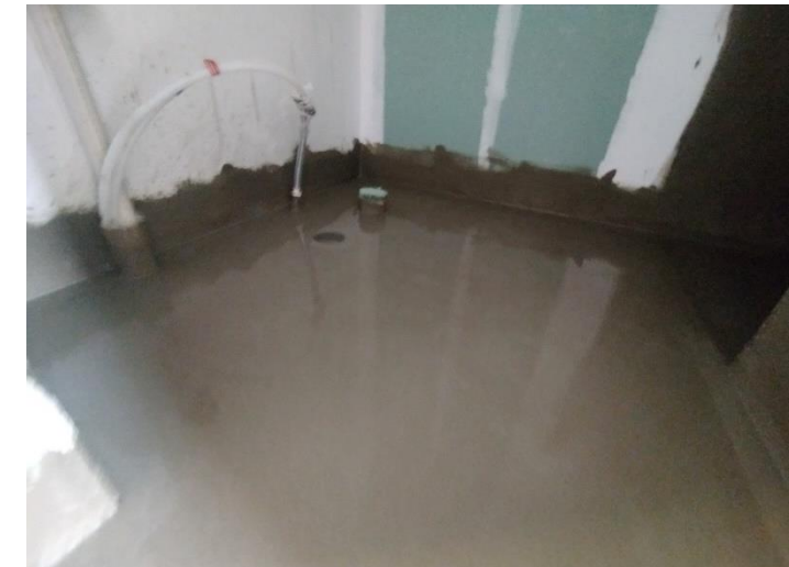
Impermeabilização – 7º Pav
