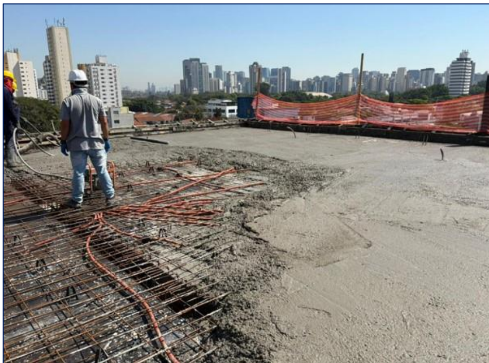
Foto 7 – Concretagem barrilete
