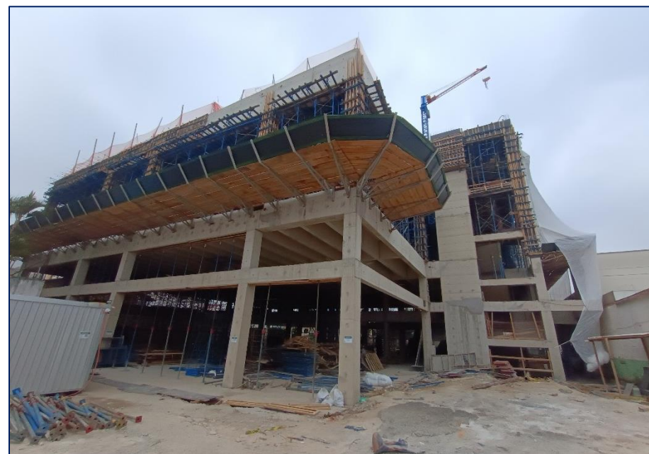
Foto 2 - Concretagem 2º pavimento
