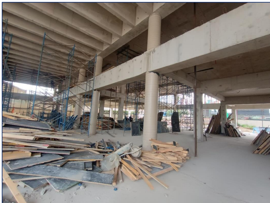
Foto 3 – Retirada de forma e escoramento - térreo
