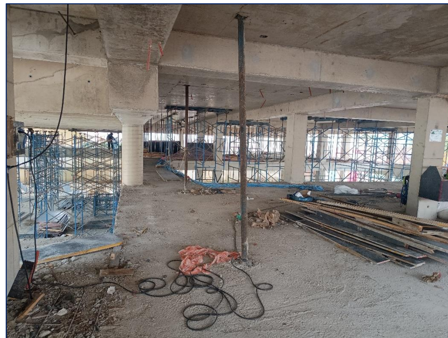
Foto 4 – Escoramento 2º pav
