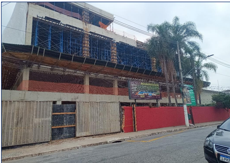
Foto 1 - Visão Frente Obra
