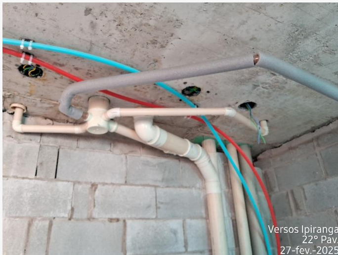
Aranha de Esgoto – 22° Pav
