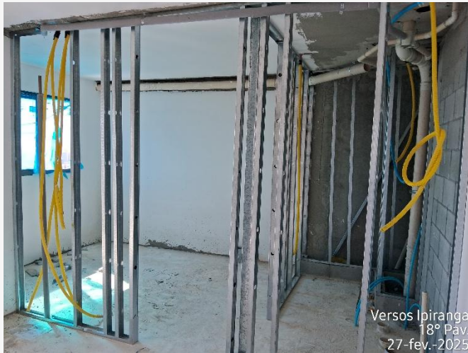
Estrutura Drywall – 18° Pav
