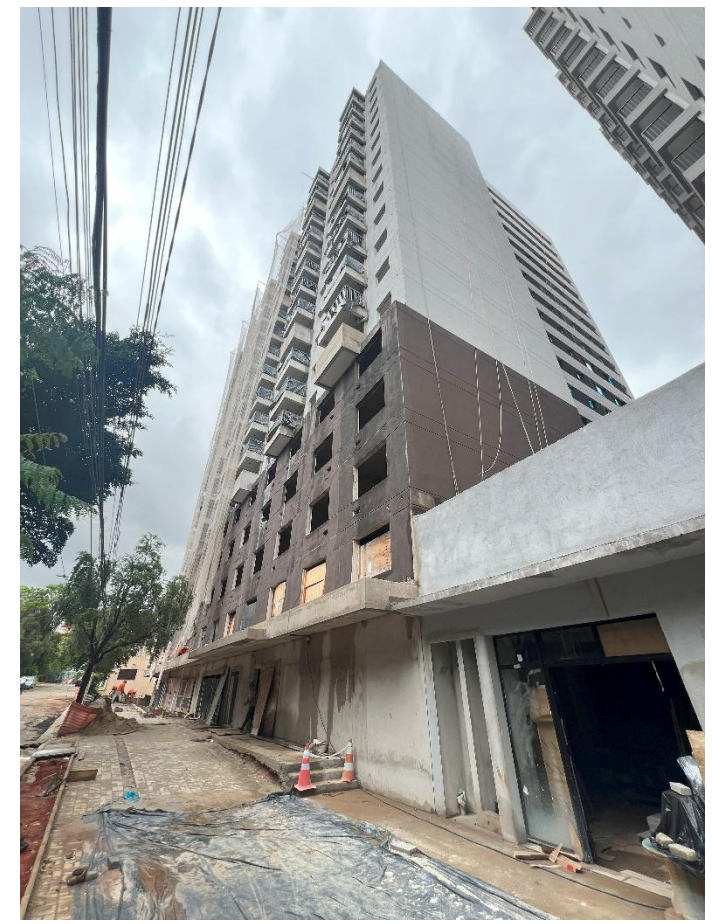
Vista Fachada Lateral
