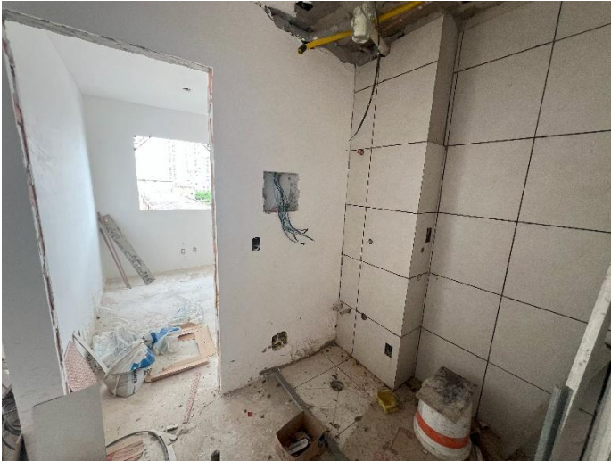
Revestimento Cerâmico – 9º Pav
