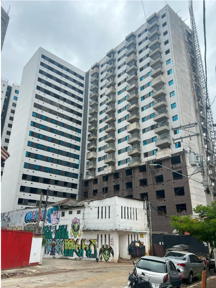
Vista Fachada Frontal
