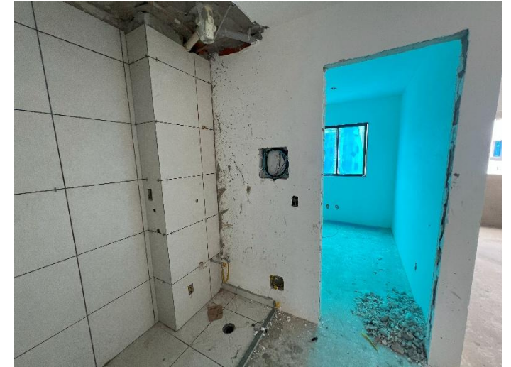
Revestimento Cerâmico – 7º Pav
