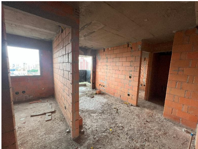
Alvenaria/ Vedação – 15º Pav
