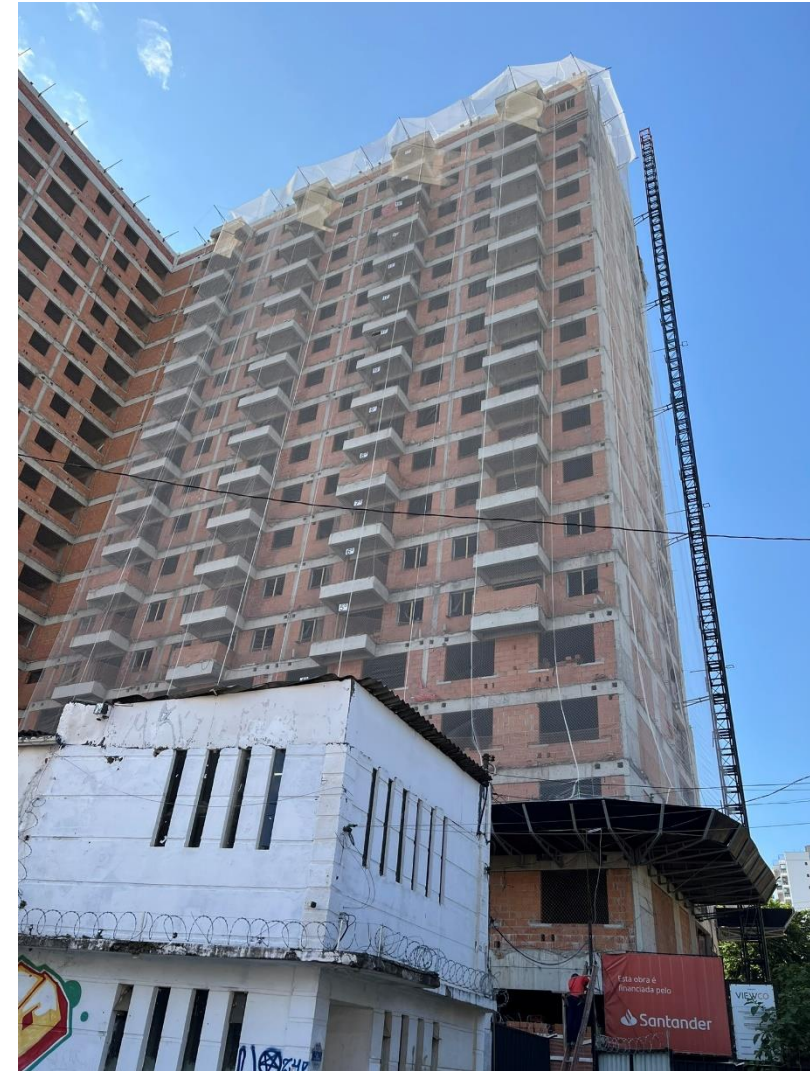
Vista da Fachada Lateral
