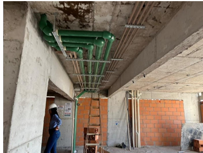
Distribuição Hidráulica – 16º Pav
