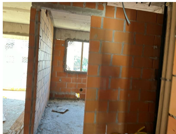
Alvenaria/ Vedação – 6º Pav
