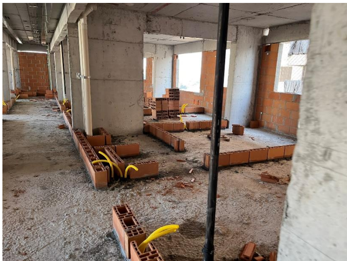
Marcação de Alvenaria – 12º Pav
