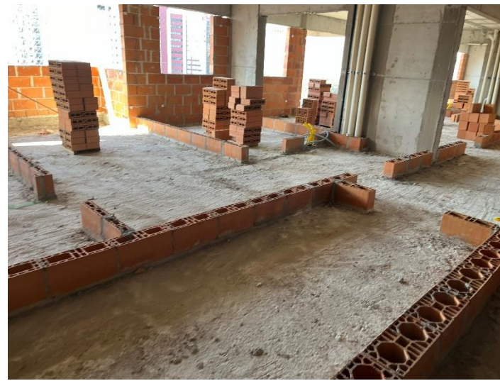
Marcação de Alvenaria – 11º Pav
