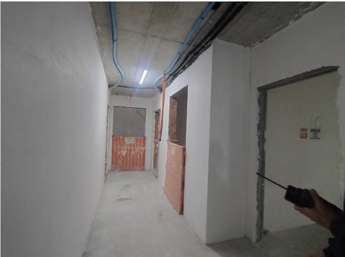
Pintura Interna – 10º Pav.
