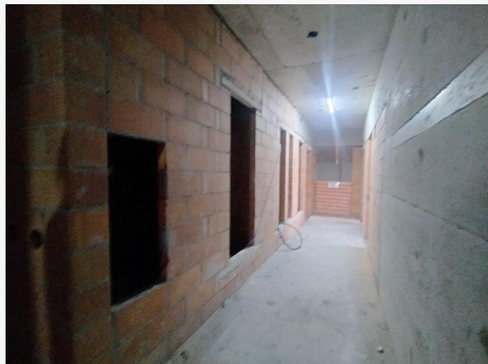
Alvenaria Vedação – 24° Pav.
