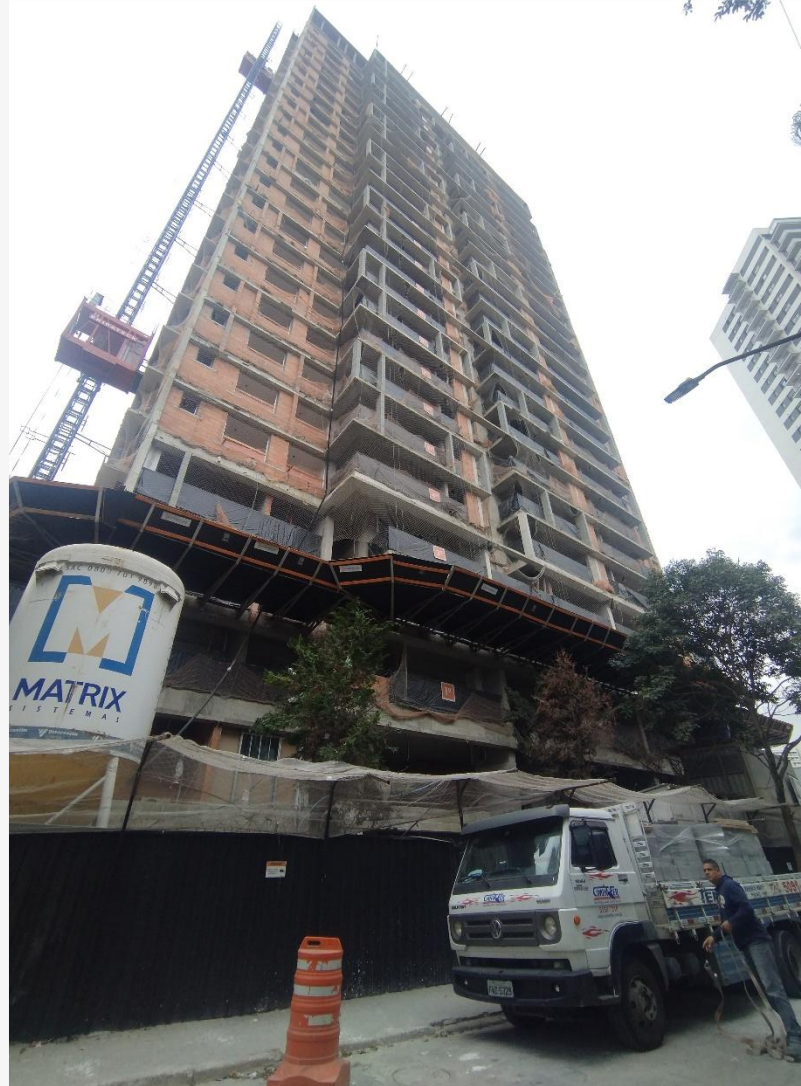
Vista da Fachada Frontal
