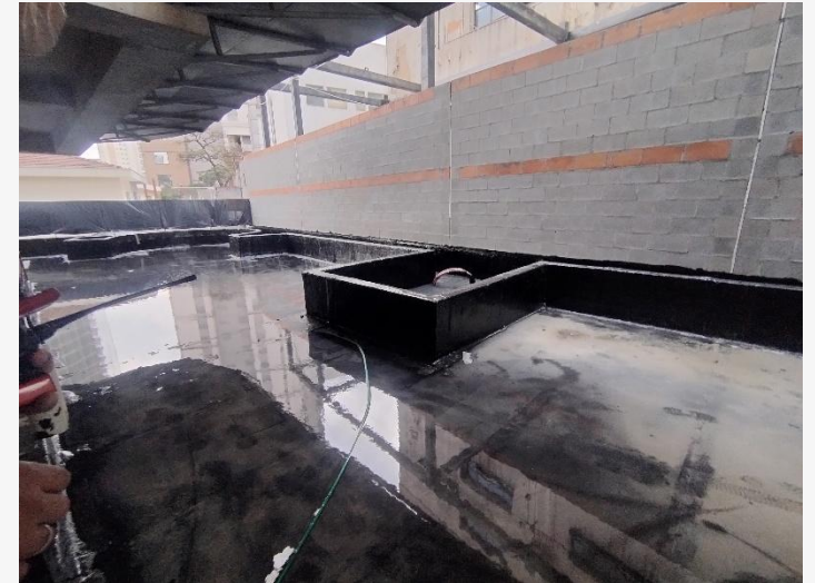
Impermeabilização – 01º Pav.
