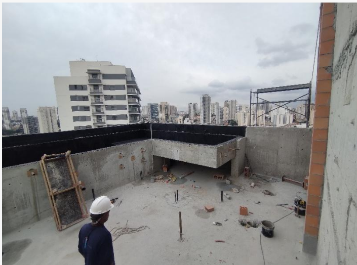
Impermeabilização – 25° Pav.
