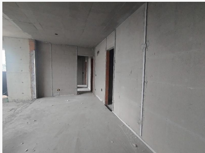
Chapisco Rolado – 17° Pav.
