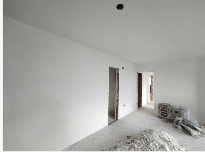
Pintura Interna – 14º Pav.
