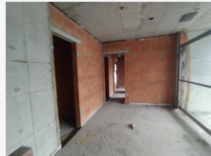
Alvenaria Vedação – 23° Pav.
