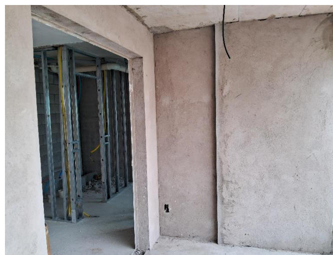
Reboco Interno – 8° Pav
