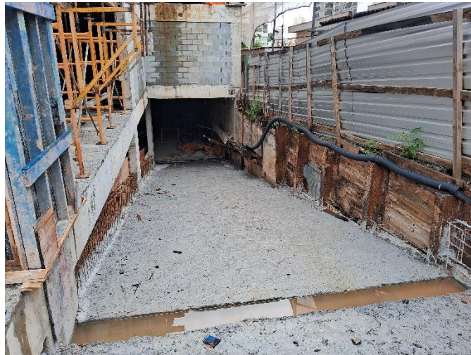
Rampa de Acesso de Veículos – 1º SS
