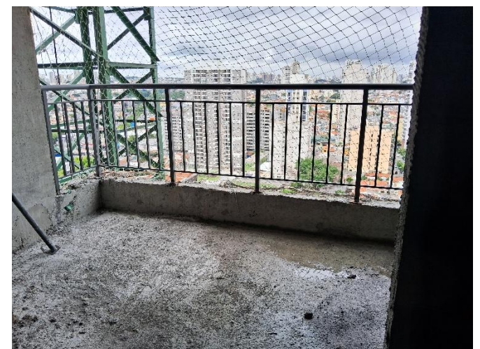
Gradil – 21º Pav
