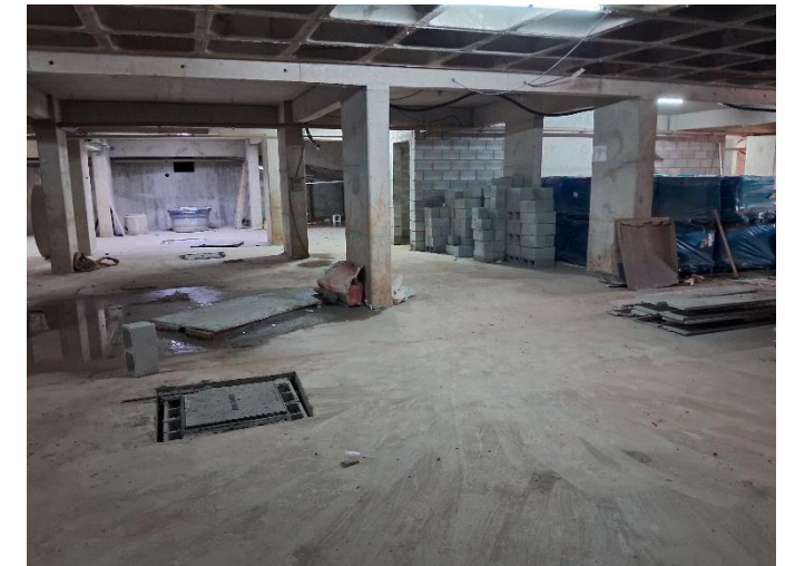
Estoque de Material (Blocos de Concreto)
