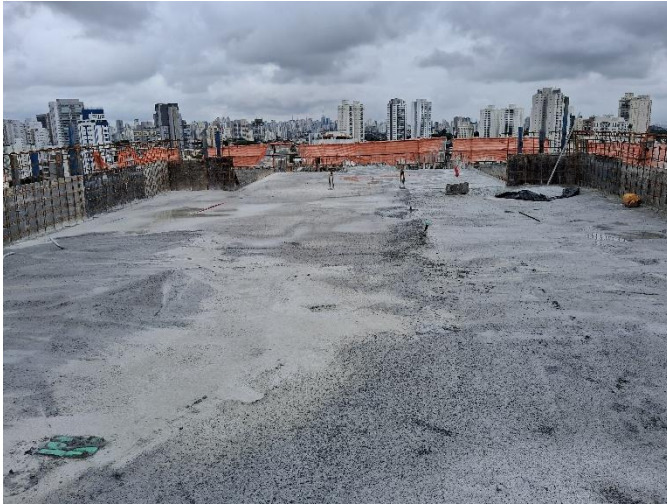
Laje Concretada – Caixa D' Água
