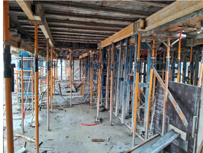
Escoramento – 26º Pav
