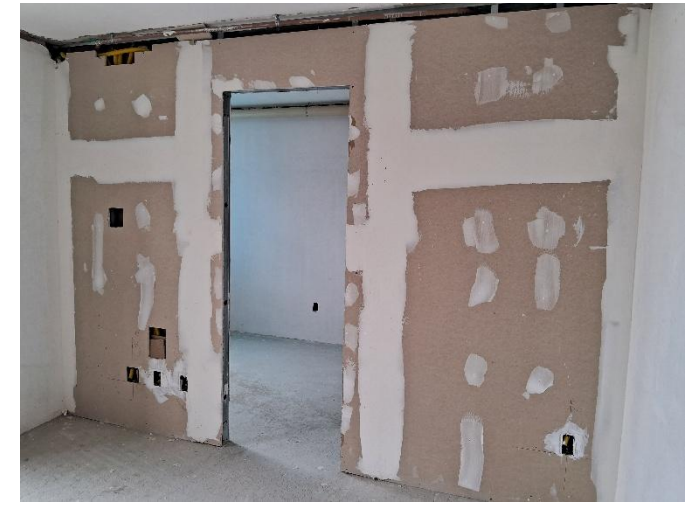
Alvenaria Drywall – 14° Pav
