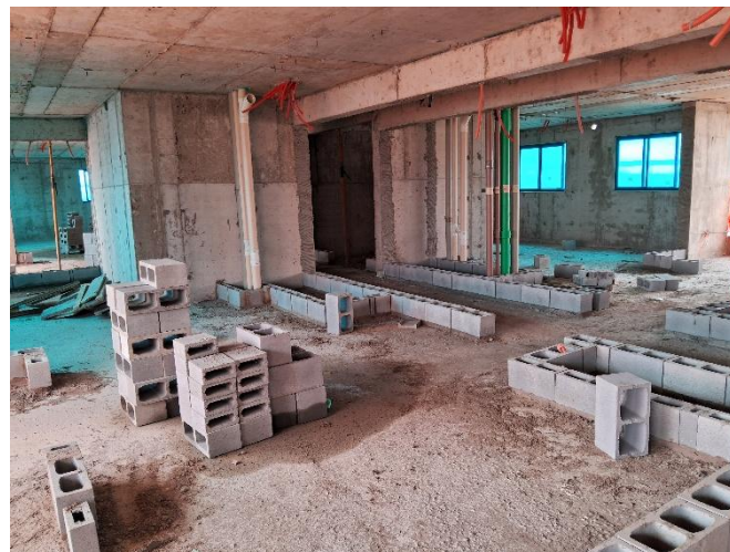
Marcação de Alvenaria – 23º Pav
