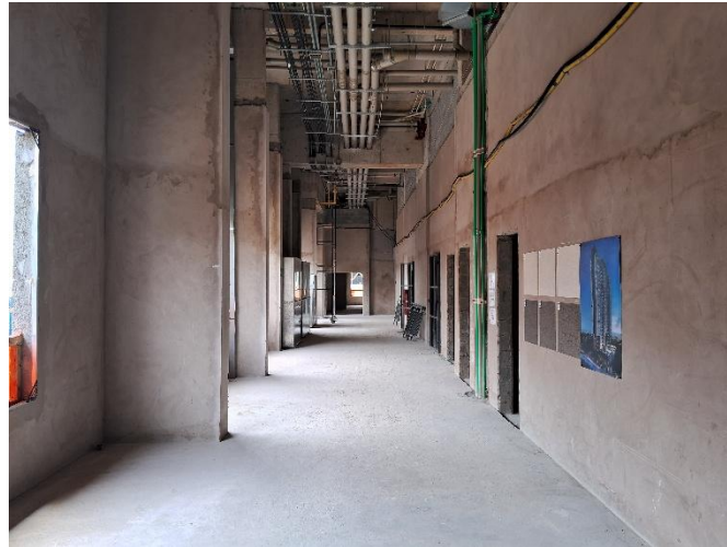
Reboco Interno – Térreo
