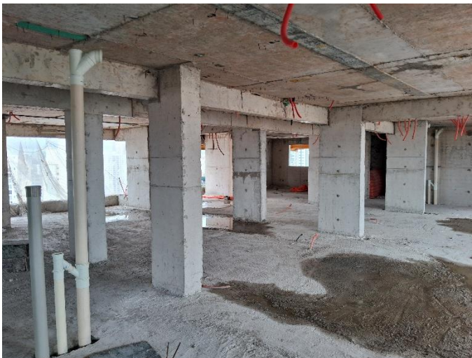
Vista da Estrutura – 24º Pav
