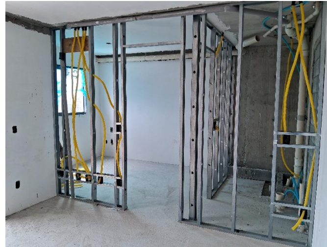
Estrutura Drywall – 18° pav
