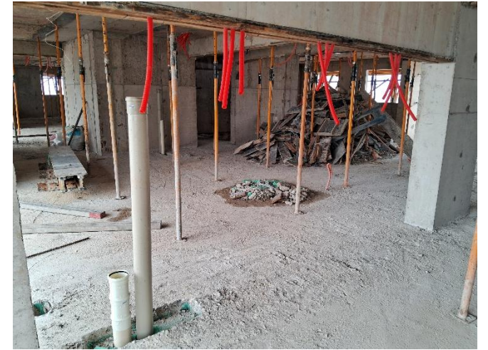
Escoramento – 25º Pav
