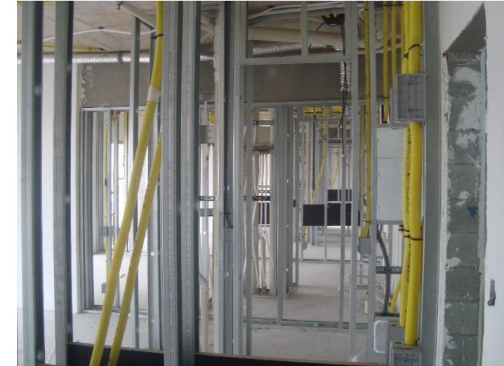
Estrutura Drywall – 19º Pav
