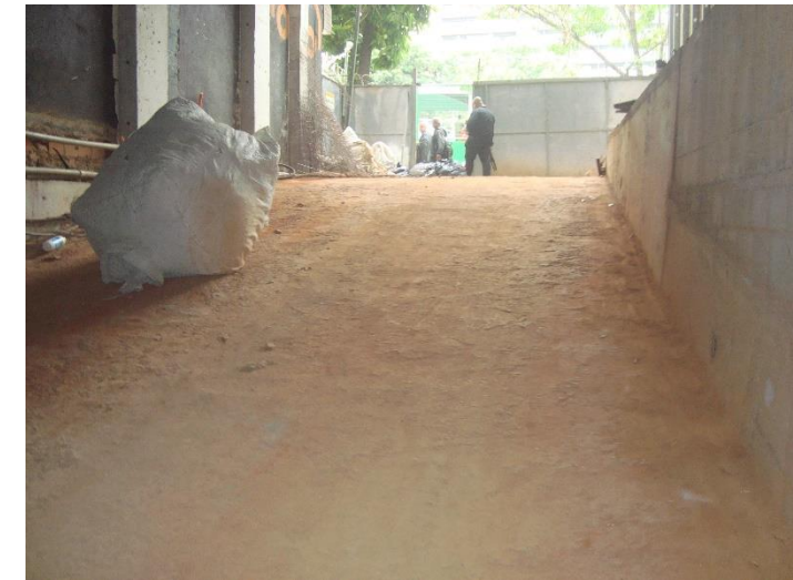
Rampa de Acesso de Veículos – 1ºSS 16
