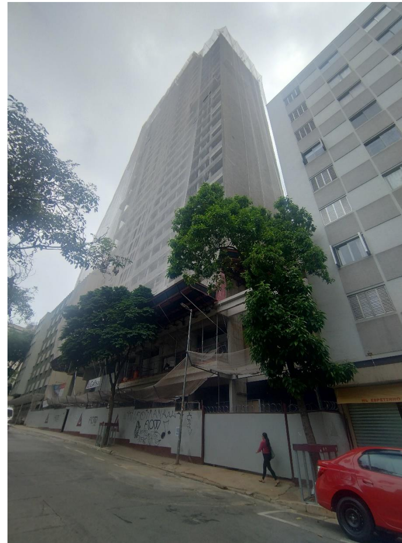
Vista Fachada Lateral
