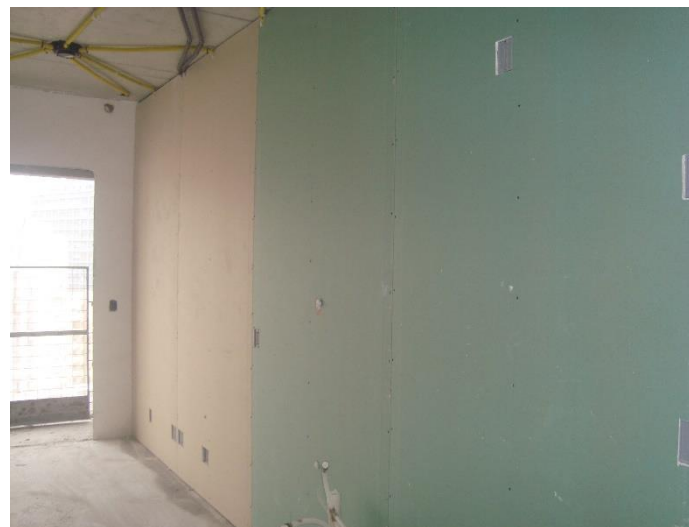
Alvenaria em Drywall – 14º Pav
