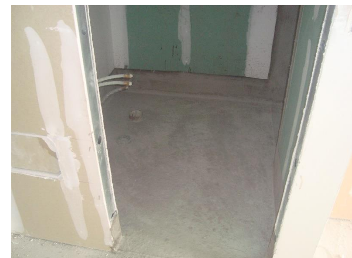
Impermeabilização – 12º Pav
