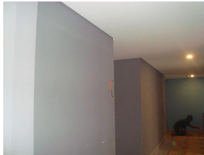
Pintura Interna – 4º Pav
