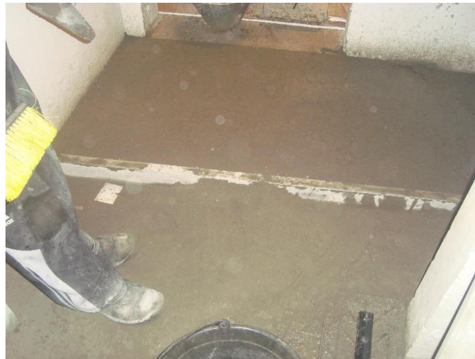
Contrapiso – 5º Pav
