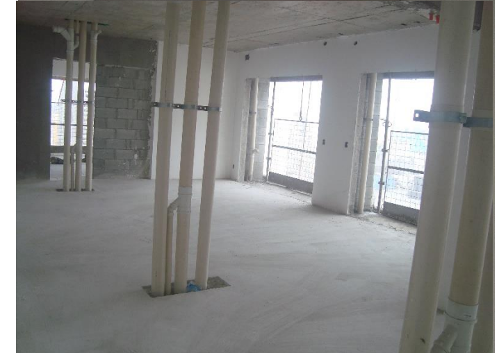
Proteção de Sacadas
