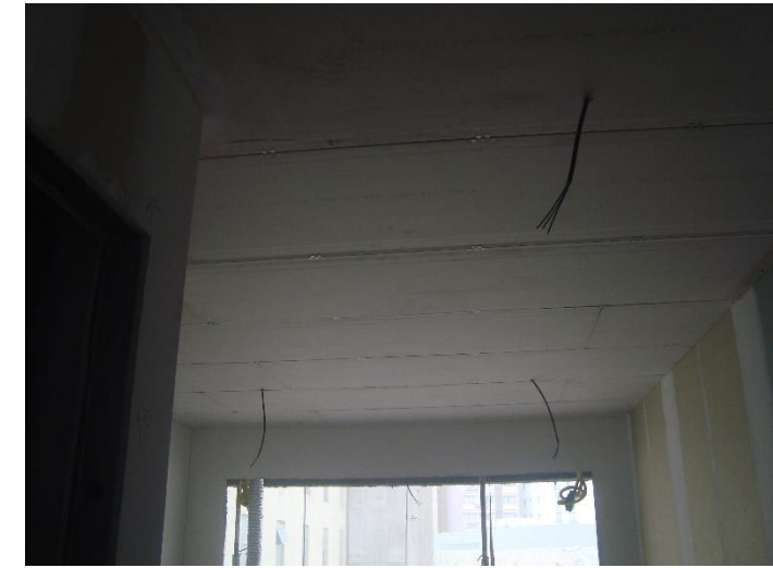
Forro de Gesso – 6º Pav
