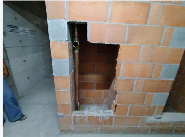
Prumada de Incêndio – 5º Pav.
