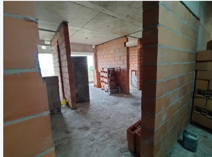
Alvenaria/Vedação – 8º Pav.
