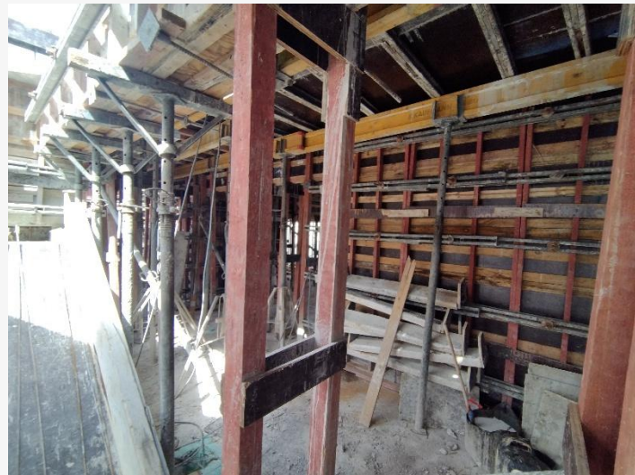
Cimbramento – 18º Pav.
