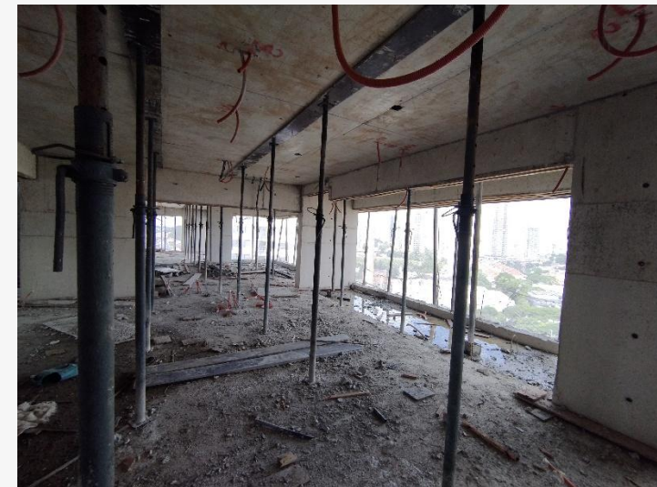
Escoramento – 17º Pav.
