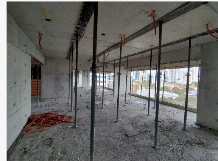
Escoramento – 14º Pav.
