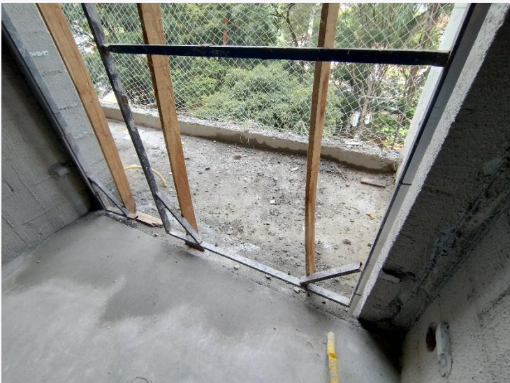
Contramarco de Alumínio – 3º Pav.
