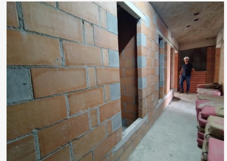
Shaft em Alvenaria – 7º Pav.
