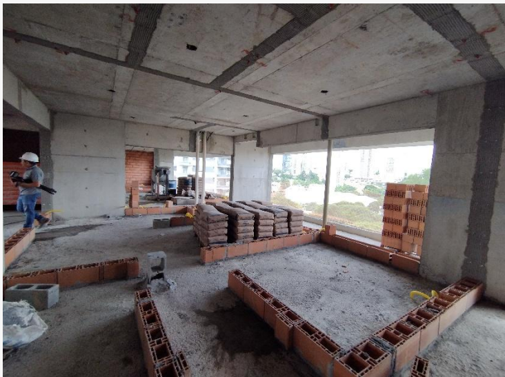
Marcação de Alvenaria – 9º Pav.
