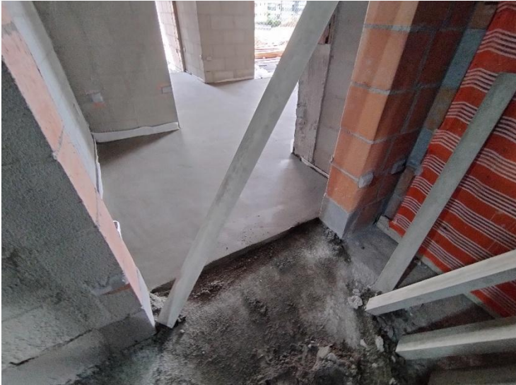
Contrapiso – 6º Pav.
