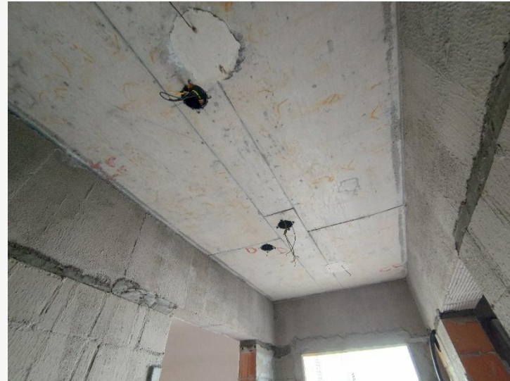
Cabos de Instalação – 2º Pav.
