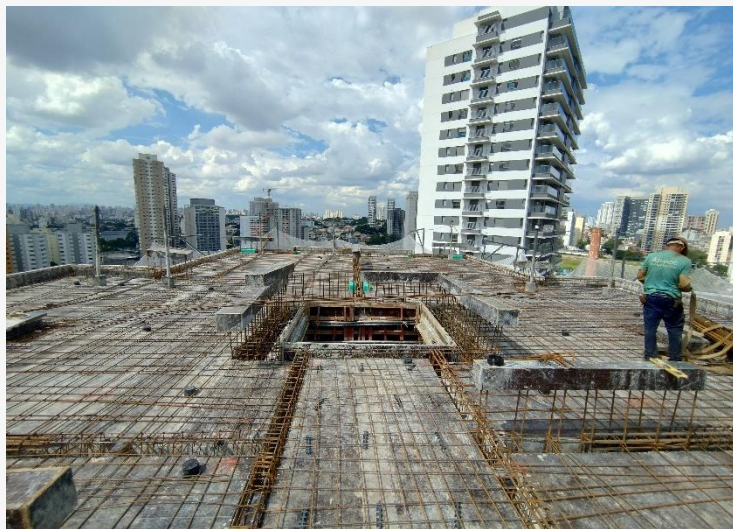
Armação de Laje – 19º Pav.
