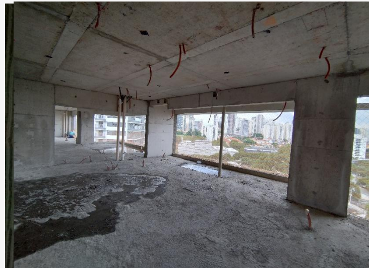
Vista da Estrutura – 12º Pav.
