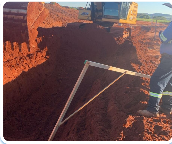
Foto 5 - Rede de esgoto
