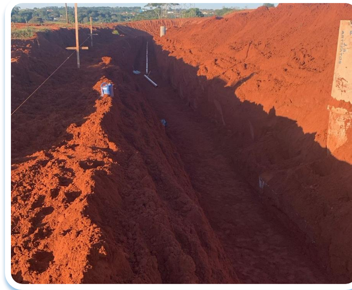
Foto 6 - Rede de esgoto
