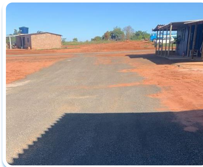
Foto 8 - Melhoria no canteiro de obra
