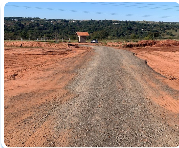
Foto 7 - Melhoria canteiro de obra
