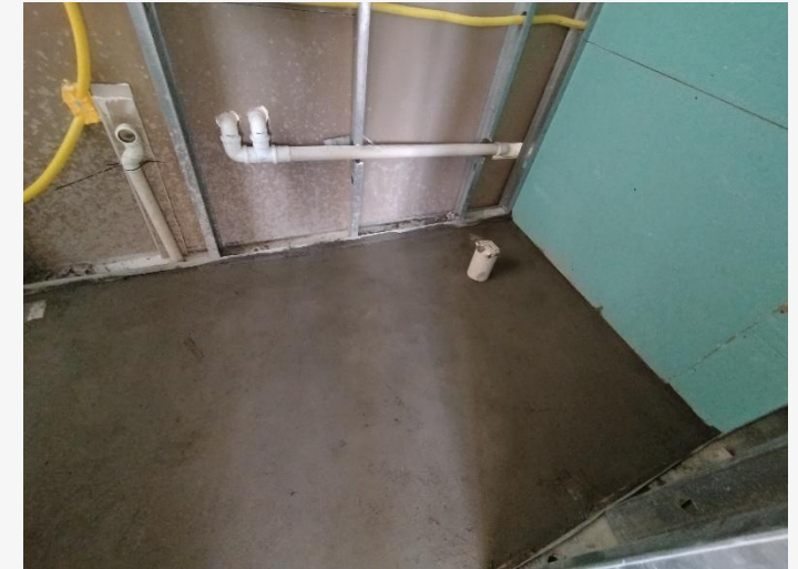
Alvenaria Drywall – 7° Pav
