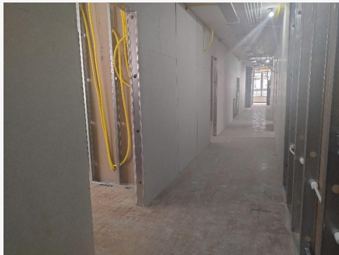
Alvenaria Drywall – 2º Pav
