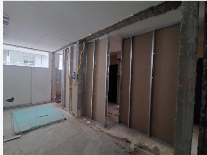
Alvenaria Drywall – 8° Pav
