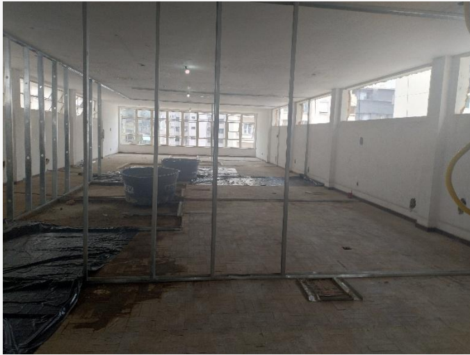
Estrutura Drywall – 9° Pav
