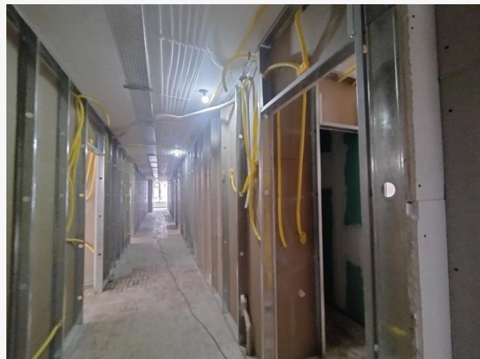
Alvenaria Drywall – 5° Pav
