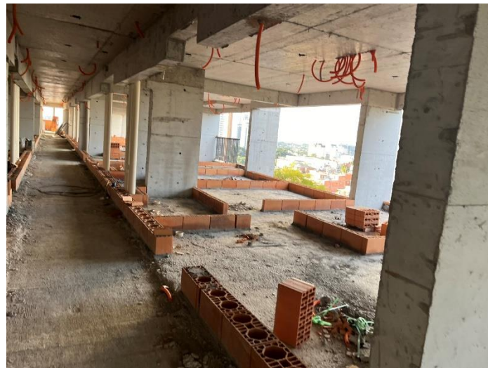
Marcação alvenaria – 2º Pav
