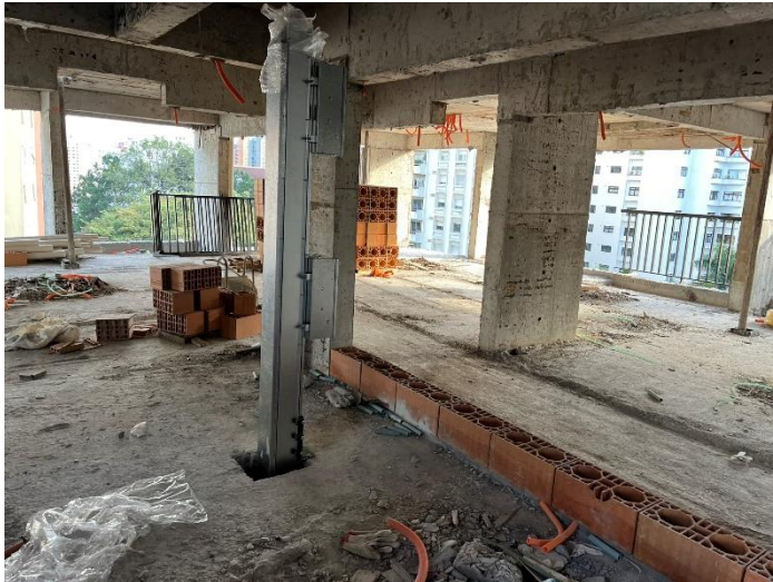
Vista Estrutura – 8º Pav
