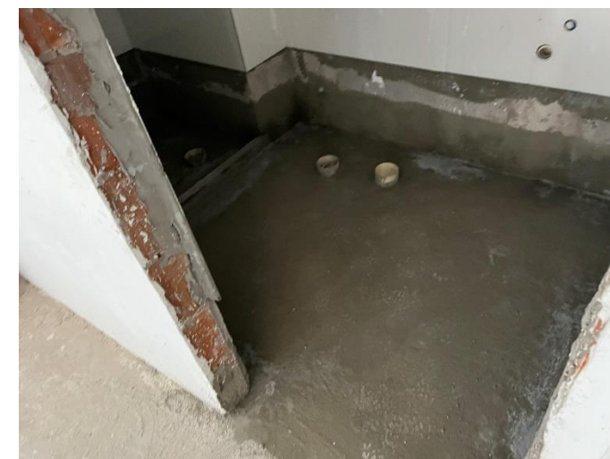
Impermeabilização – 1º Pav
