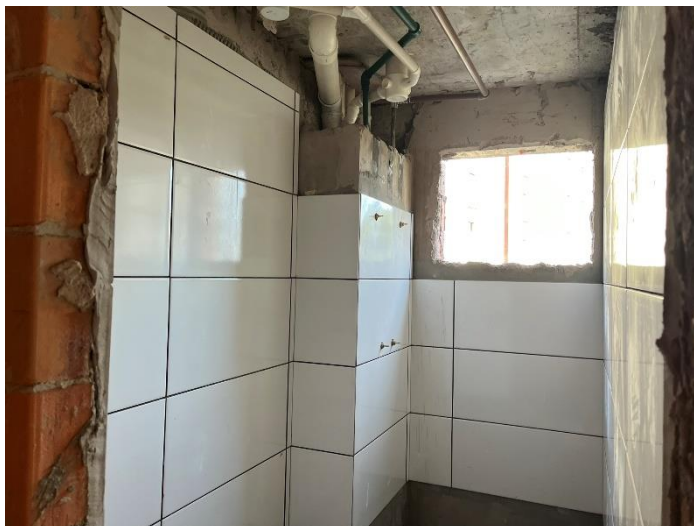
Revestimento Cerâmico – 6º Pav
