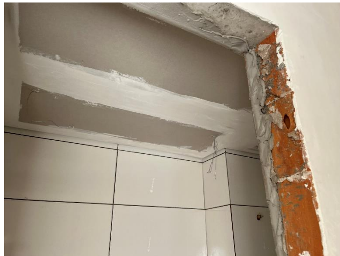
Revestimentos – 3º Pav
