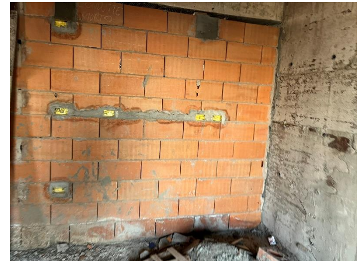
Embutidos em Alvenaria – 7º Pav
