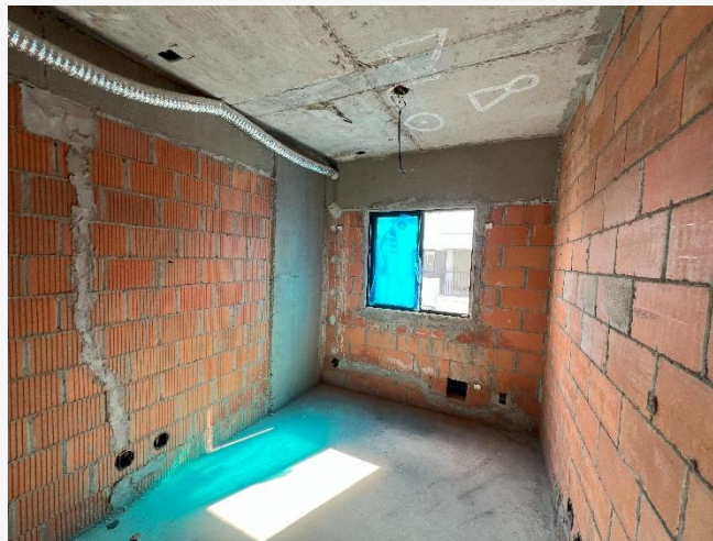
Janela de Alumínio – 17º Pav.
