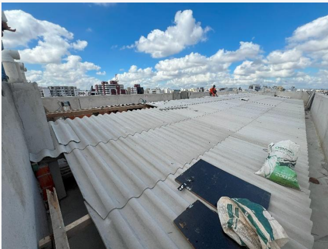
Telha de Fibrocimento – Cobertura
