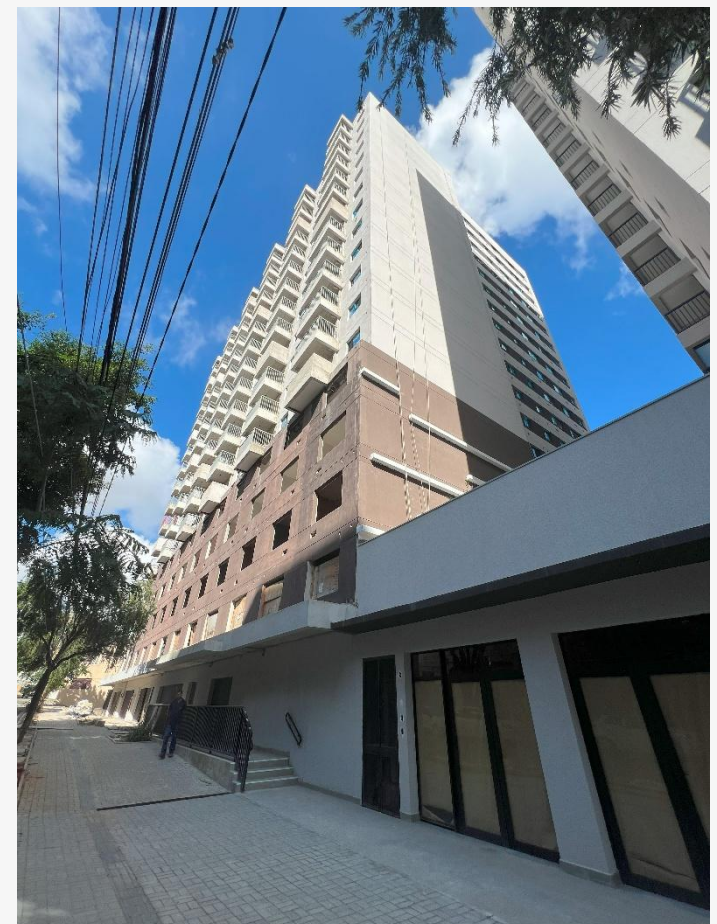
Vista Fachada Lateral
