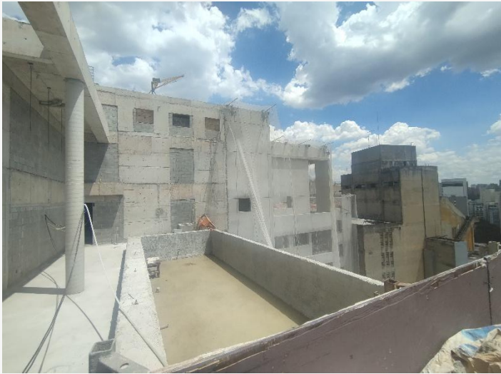
Proteção Mecânica – Piscina
