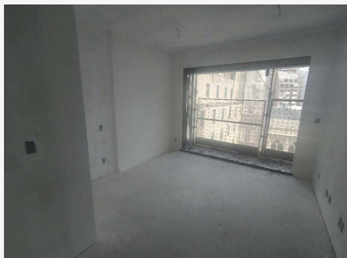
Pintura Interna – 8º Pav
