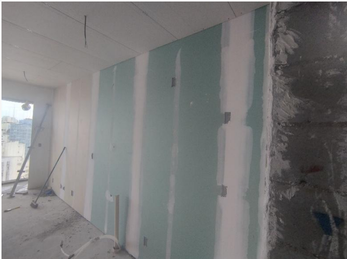
Alvenaria Drywall – 20º Pav
