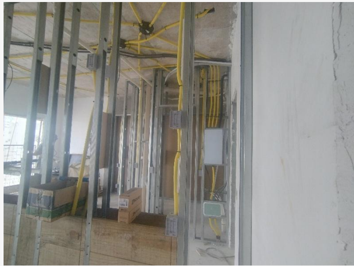
Estrutura Drywall – 23º Pav
