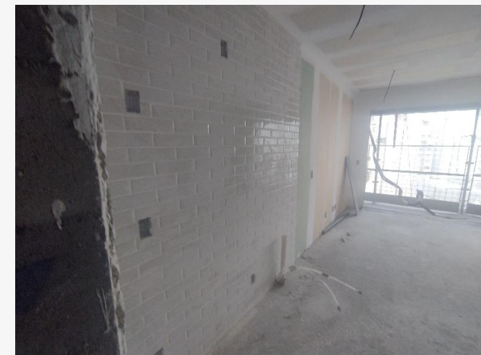
Revestimento Cerâmico – 11º Pav
