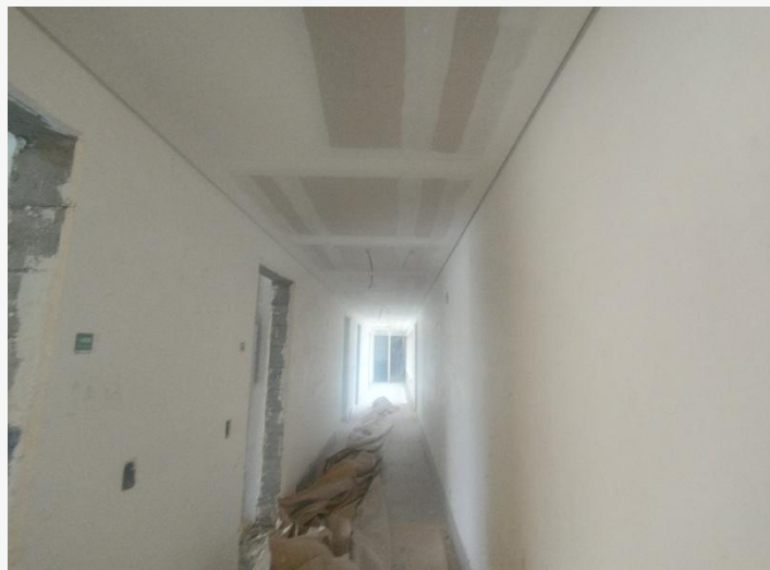
Forro de Gesso – 14º Pav
