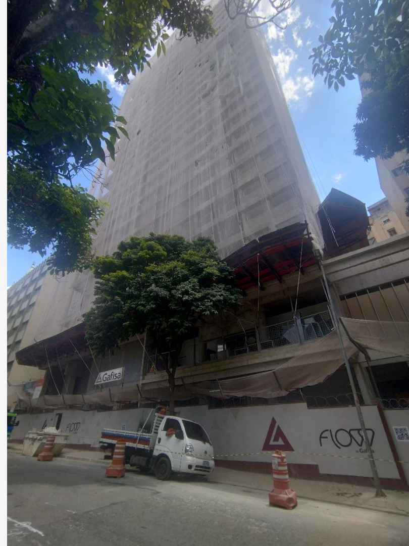
Vista Fachada 25/Fev/25
