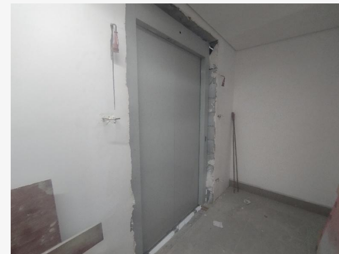
Instalação de Elevadores – 2º Pav
