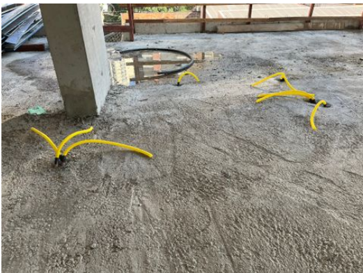
Mangueiras elétricas na laje do 4.º andar
