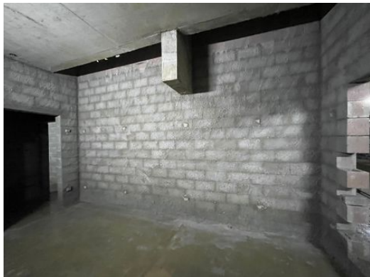
Alvenaria parcialmente executada no 1.º subsolo
