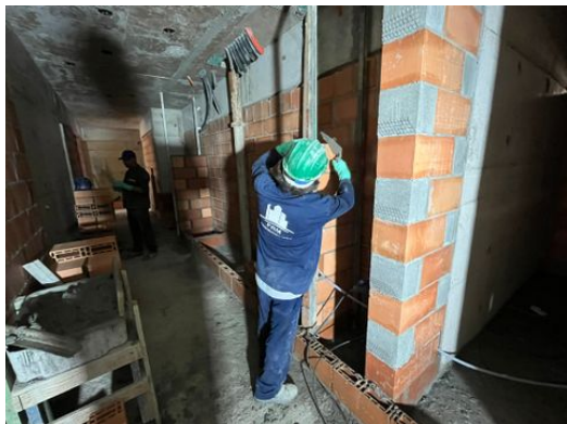
Alvenaria em execução no 2.º andar
