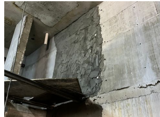
Execução de emboço no Térreo
