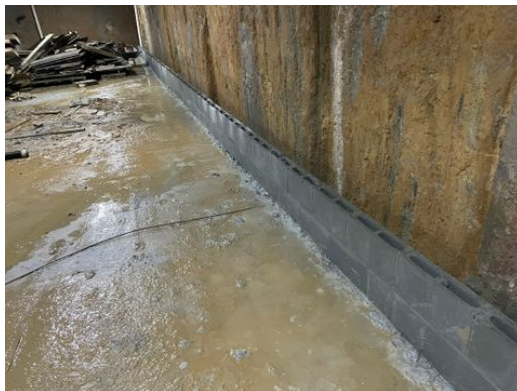
Mureta para fechamento em PVC no 2.º subsolo
