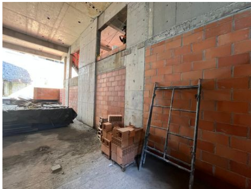
Alvenaria parcialmente executada no Térreo
