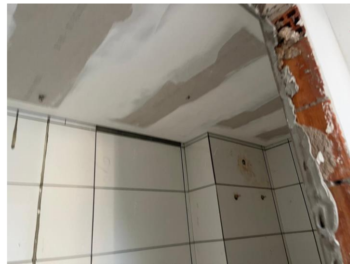
Forro de Gesso – 6º Pav
