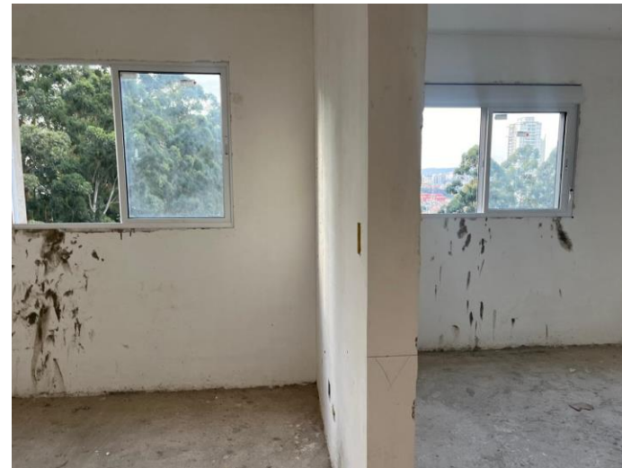
Janela de Alumínio – 3º Pav
