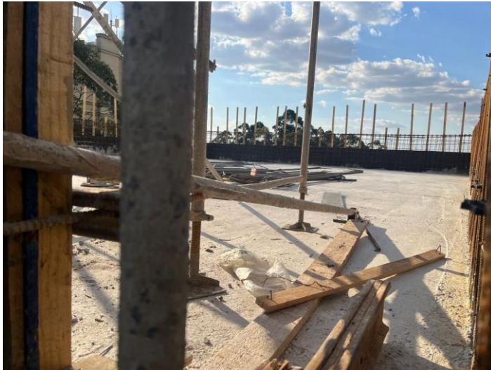
Concretagem da Laje – Cobertura
