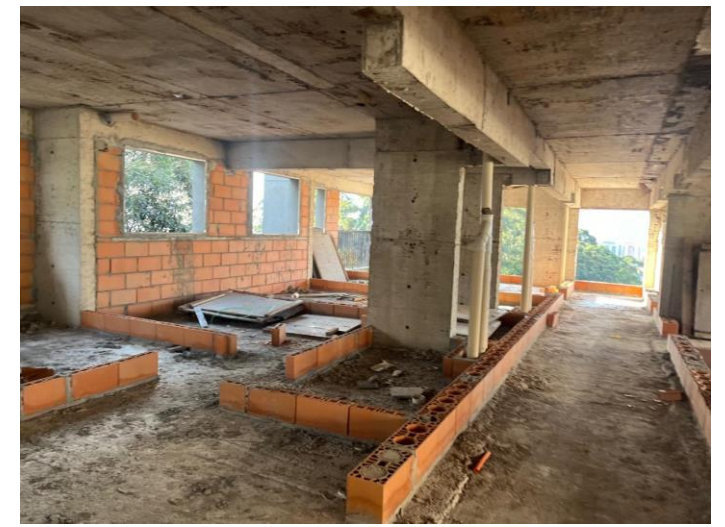
Marcação de Alvenaria – 8º Pav
