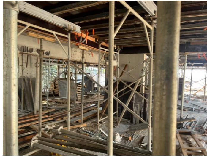
Escoramento – 9º Pav
