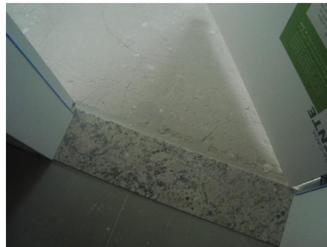
Soleira em Granito – 3º Pav
