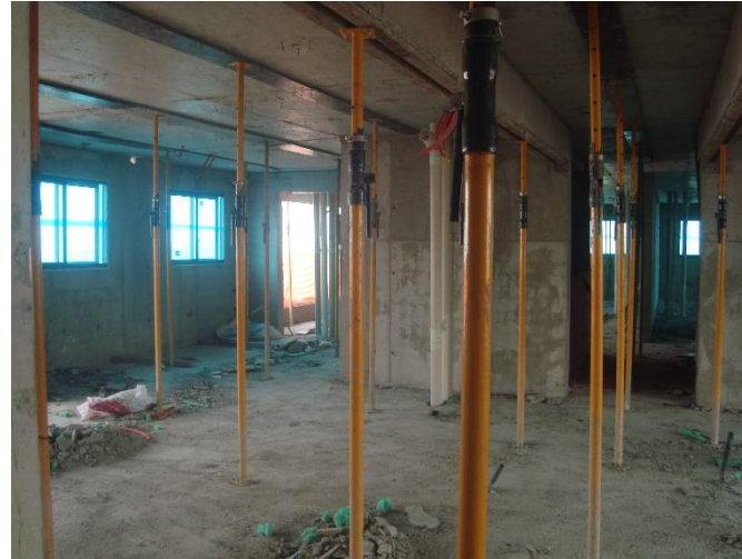
Vista Estrutura – 15° pav
