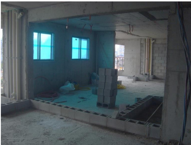
Marcação de Alvenaria – 14° Pav
