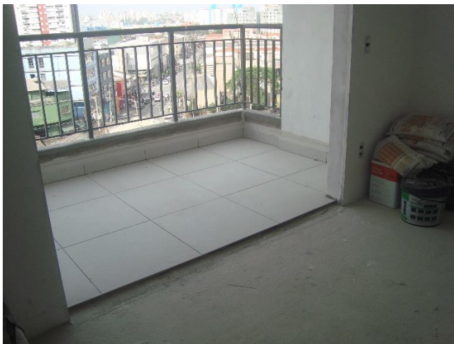
Revestimento Cerâmico – 4º pav
