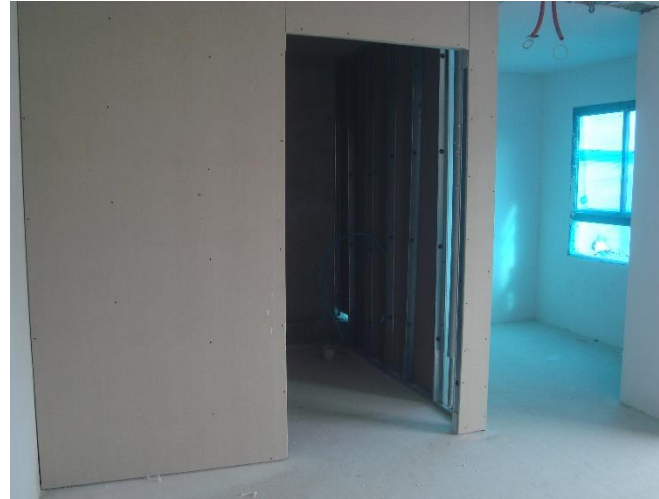
Alvenaria em Drywall – 6º pav
