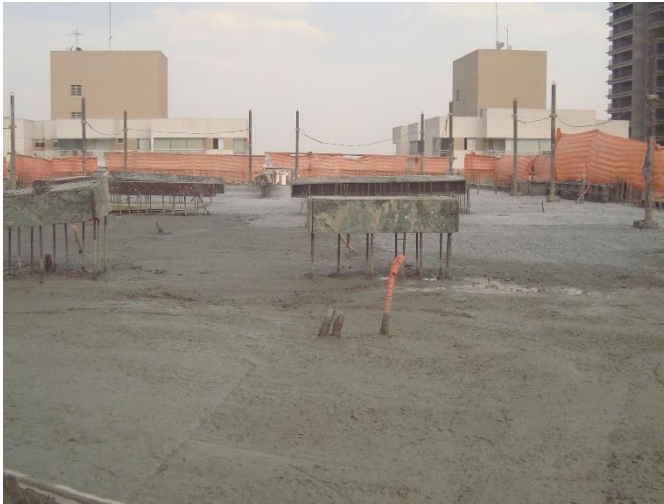
Concretagem de Laje – 20° pav
