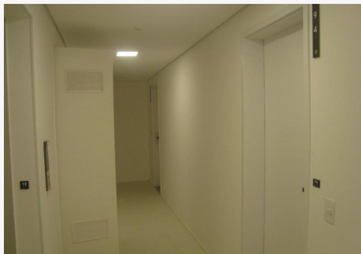
Pintura Interna – 19º Pav
