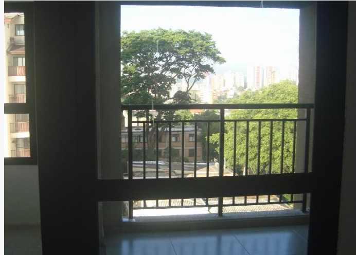
Gradil – 6º Pav
