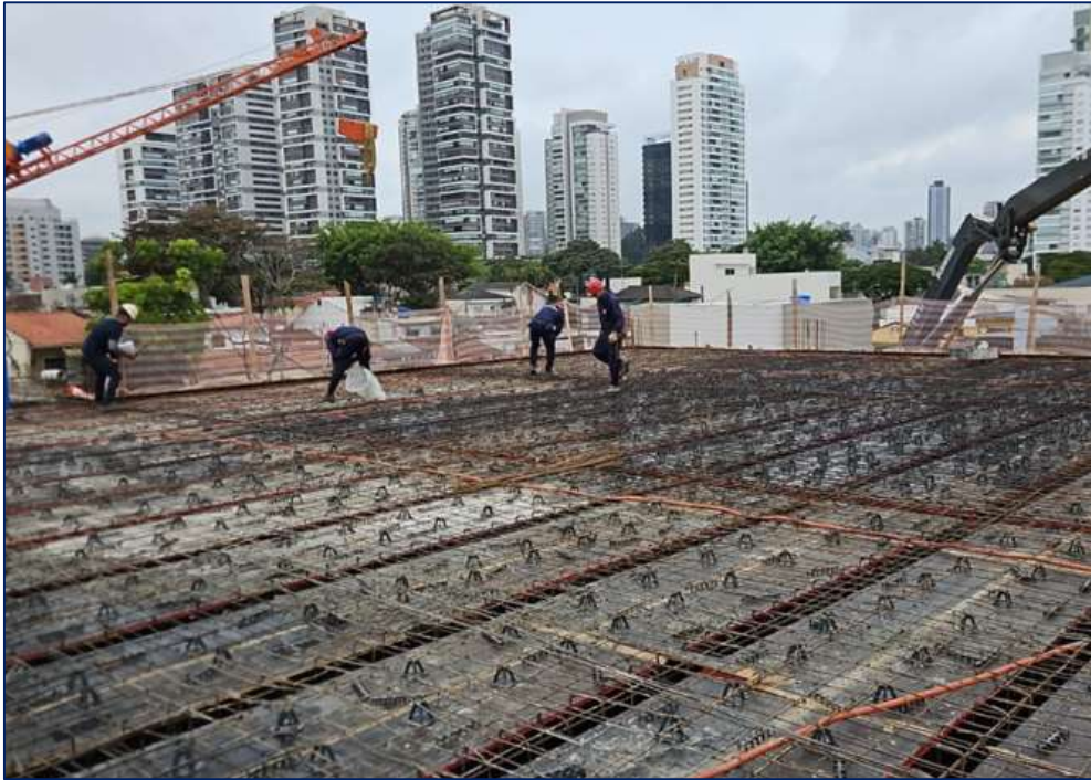
Foto 3 – Armação da laje do 2º pavimento
