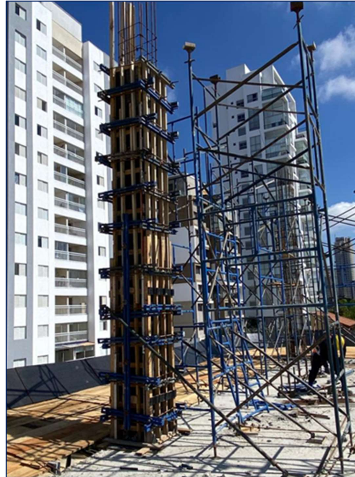
Foto 6 – Montagem de forma de pilares 2º pavimento
