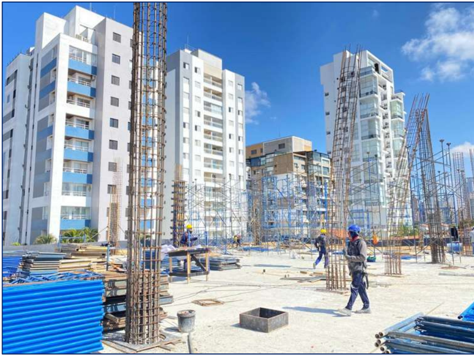
Foto 5 – Escoramento laje técnica entre 2º e 3º pavimento
