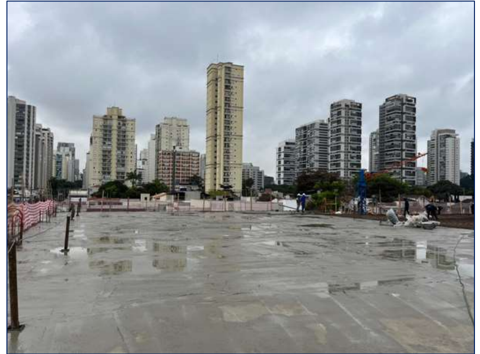
Foto 4 – Concretagem da laje do 2º pavimento
