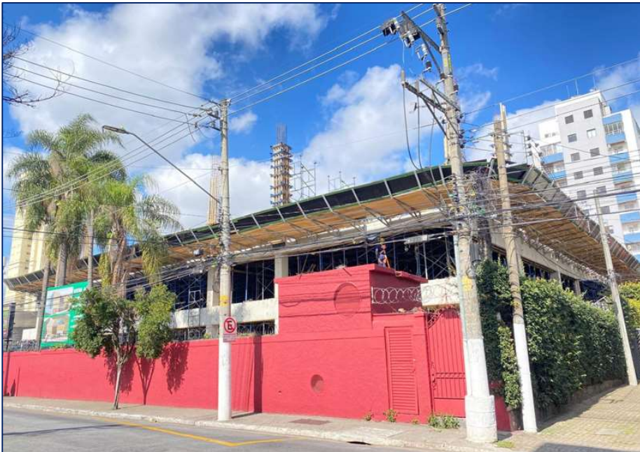
Foto 1 – Visão geral da obra
