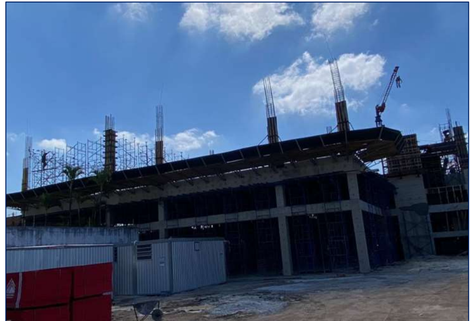
Foto 2 – Laje 1º pavimento concretada e bandeja primária
