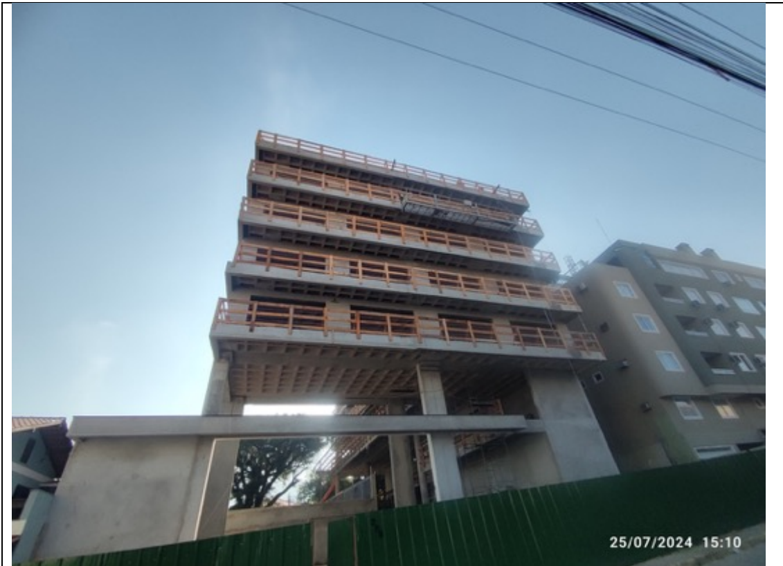
Foto 1 – Execução de reboco externo
