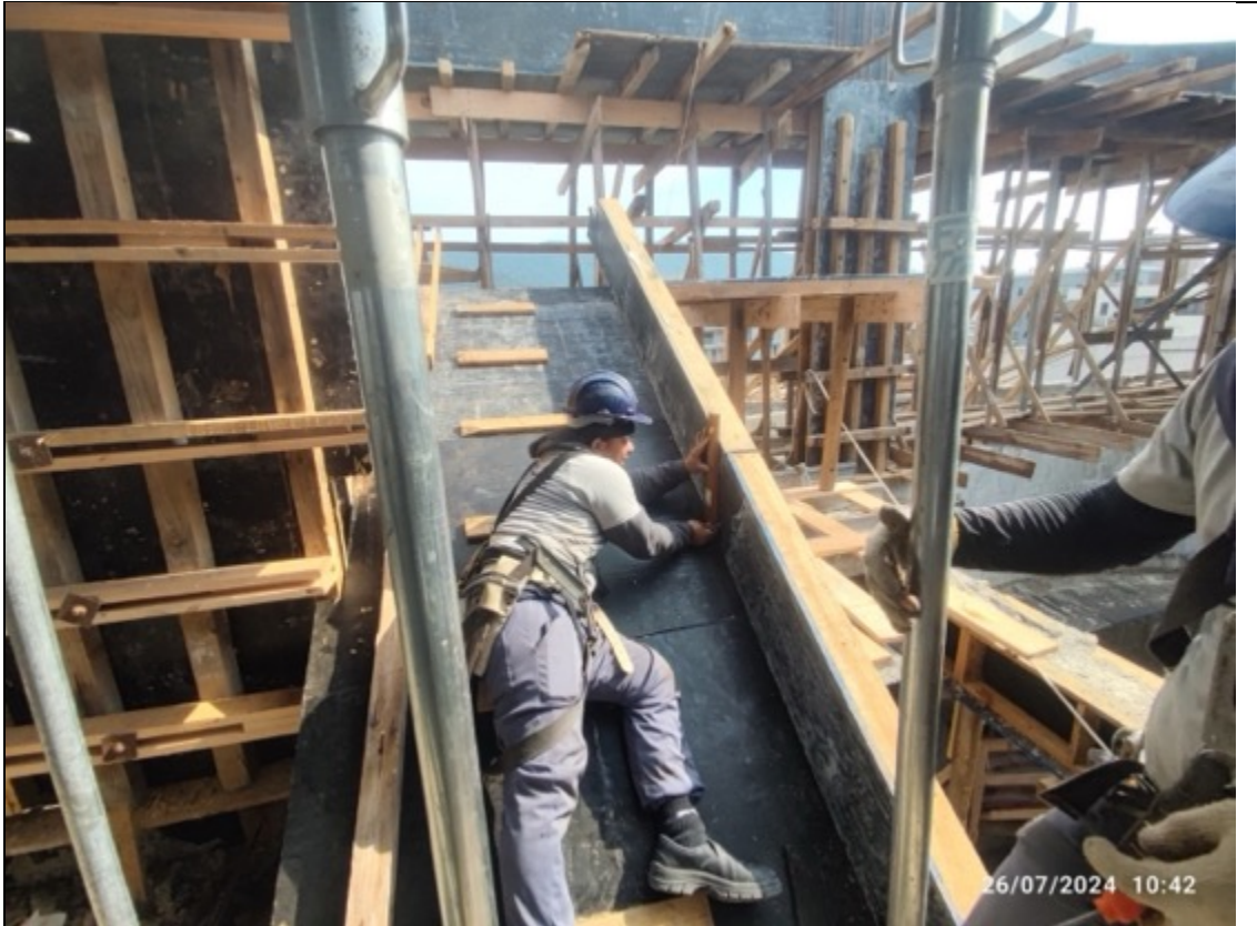
Foto 13 – Execução de escada
