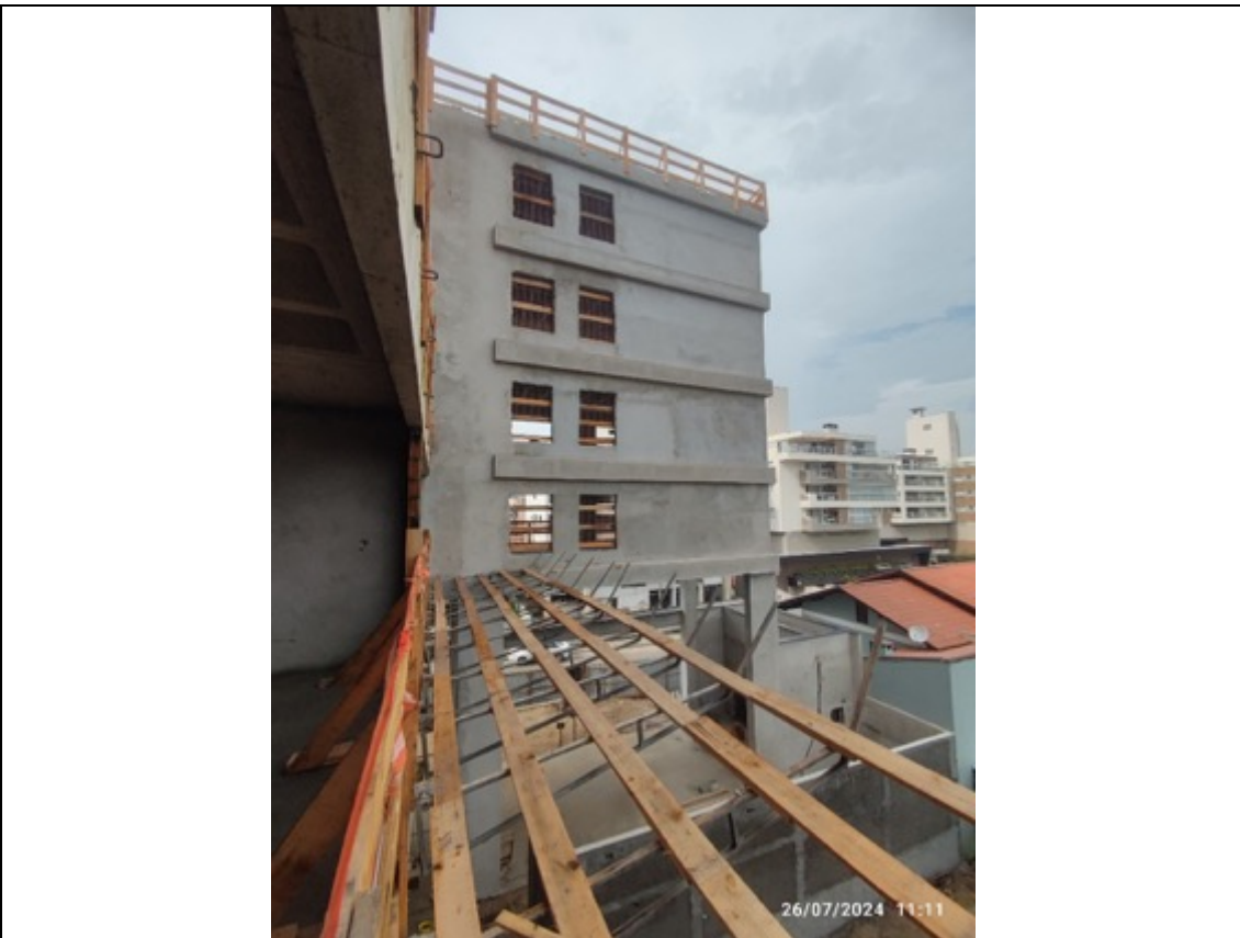
Foto 41 – Execução de proteções periféricas
