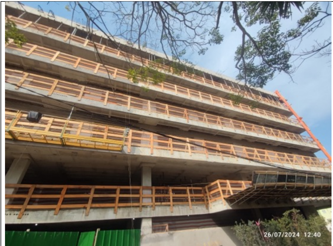
Foto 44 – Execução de proteções periféricas
