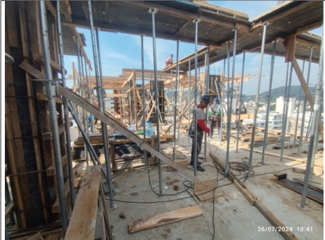
Foto 11 – Execução de forma do teto do restaurante
