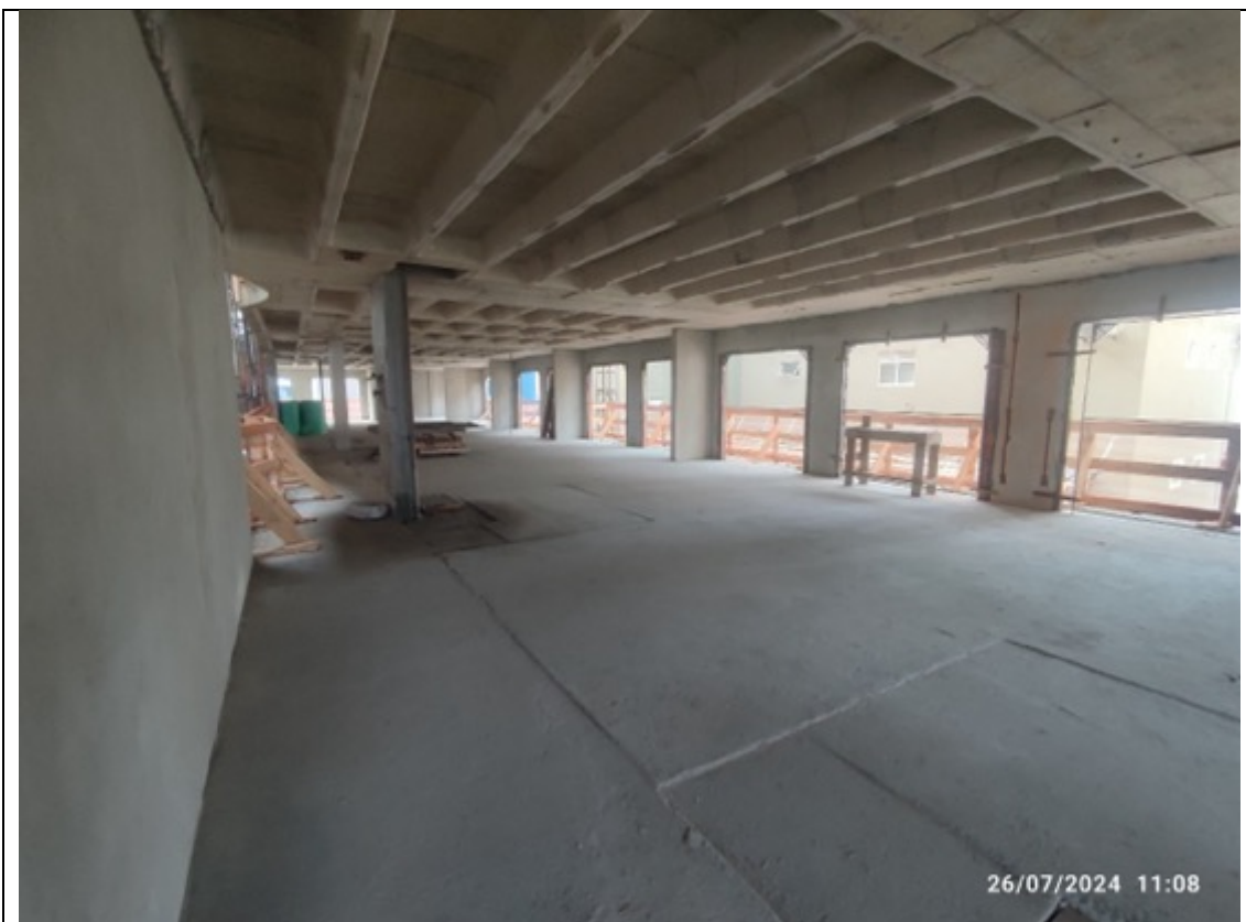
Foto 35 – Execução de chumbamento de contramarcos
