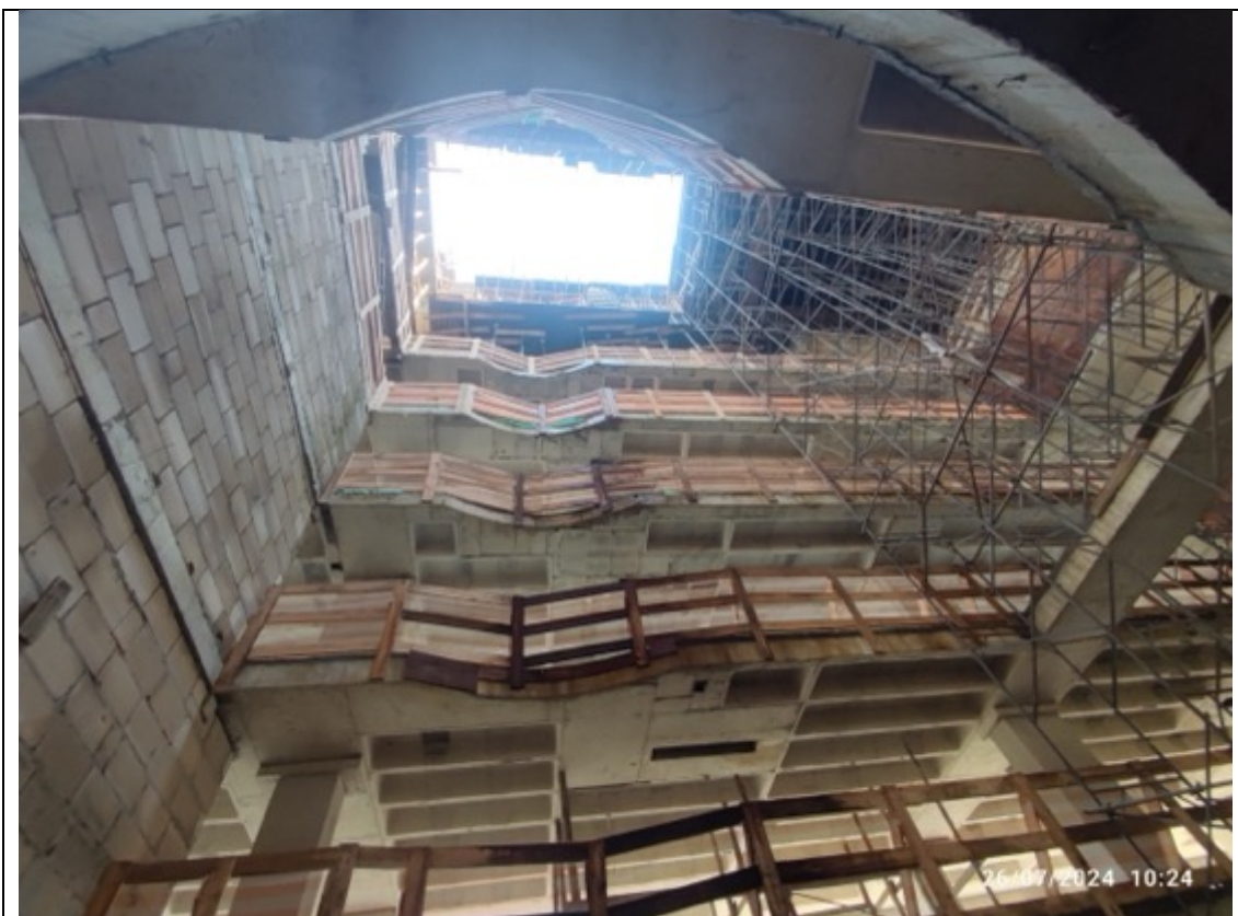
Foto 6 – Execução das proteções periféricas
