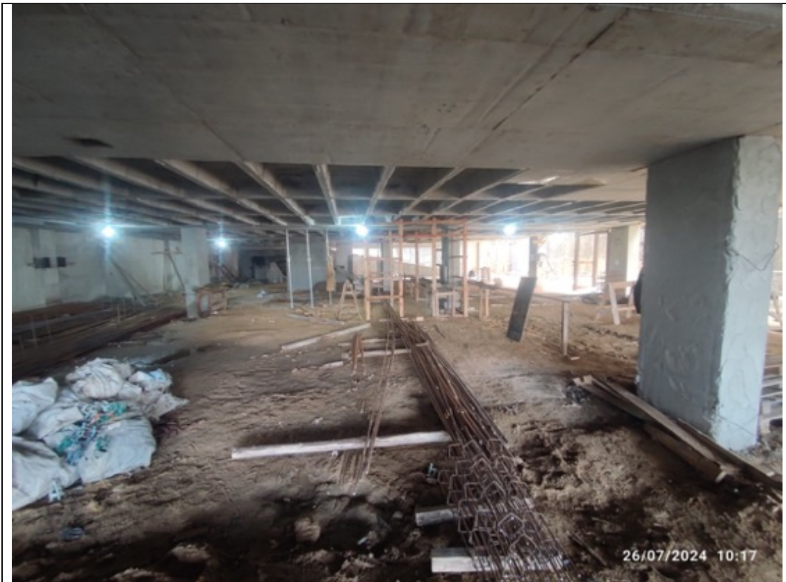
Foto 3 – Estoque de aço
