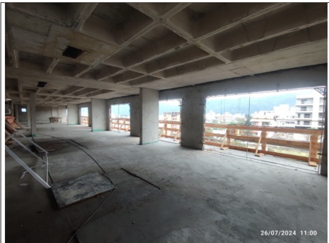
Foto 27 – Execução de chumbamento de contramarcos
