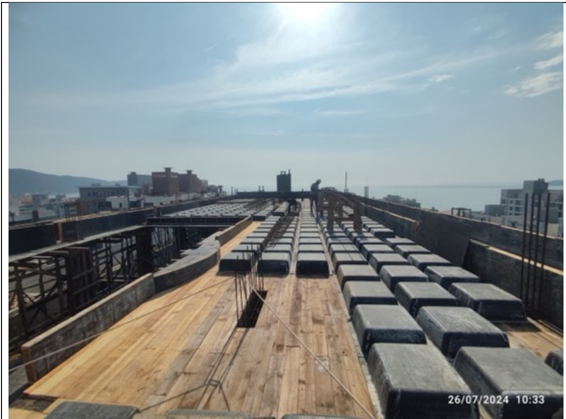
Foto 9 – Execução de forma do teto do restaurante
