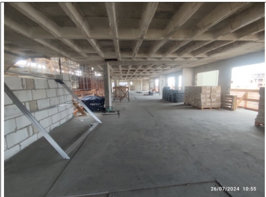
Foto 25 – Execução de alvenaria da escada
