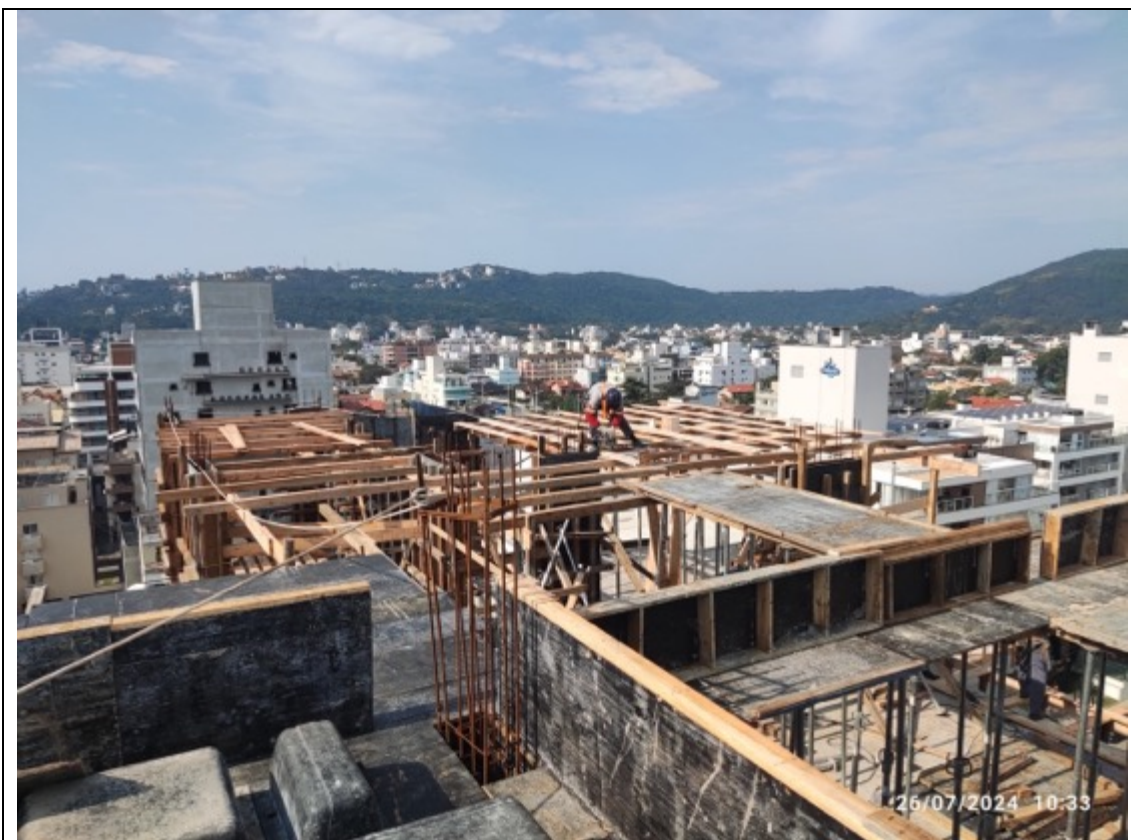
Foto 8 – Execução de forma do teto do restaurante
