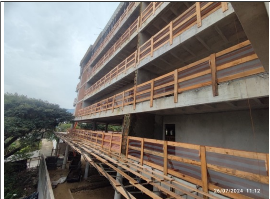
Foto 39 – Execução de proteções periféricas
