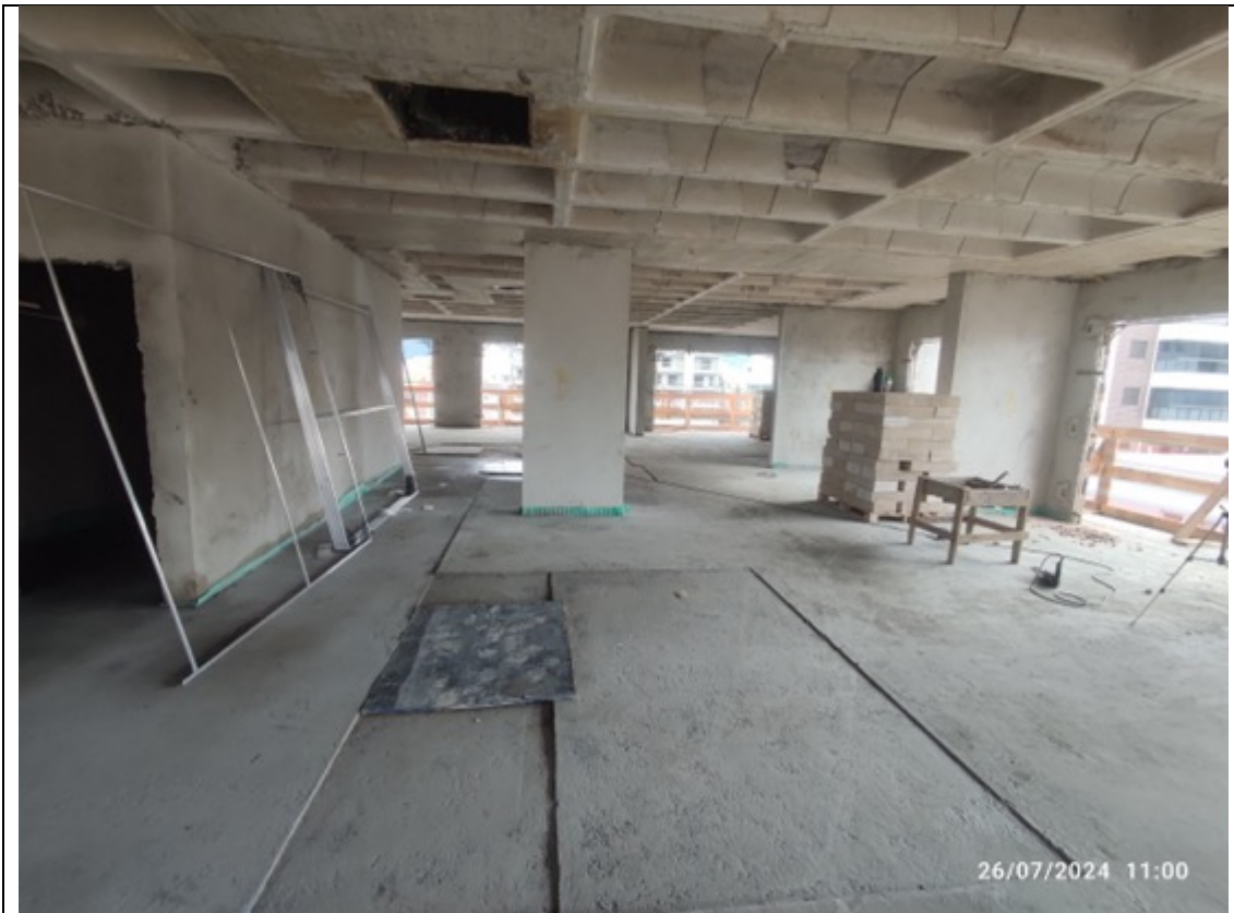
Foto 26 – Execução de chumbamento de contramarcos
