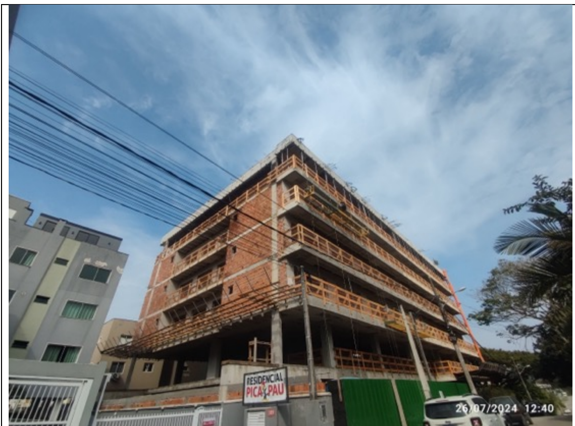
Foto 45 – Execução de proteções periféricas
