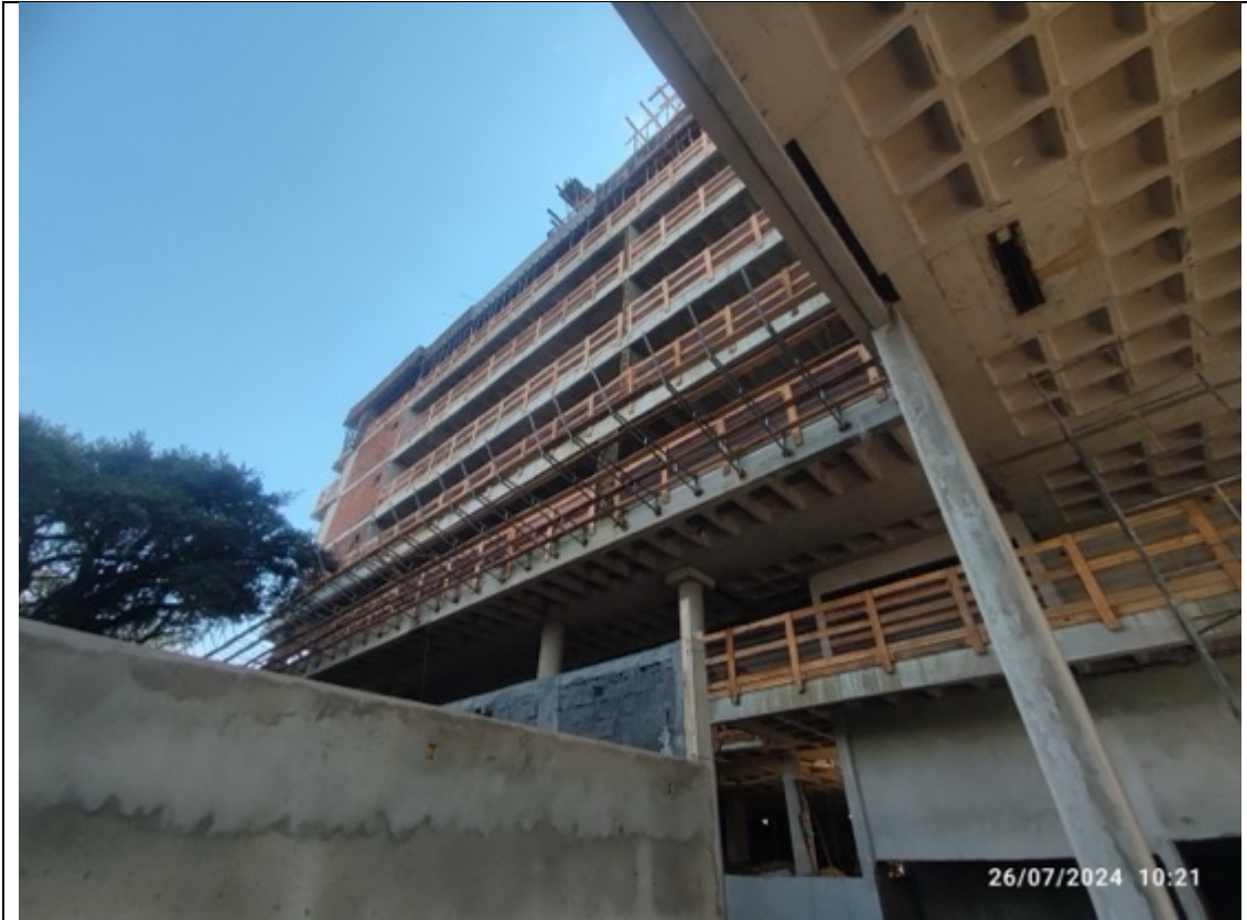
Foto 5 – Execução das proteções periféricas
