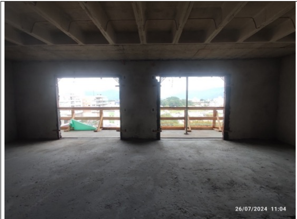
Foto 30 – Execução de chumbamento de contramarcos
