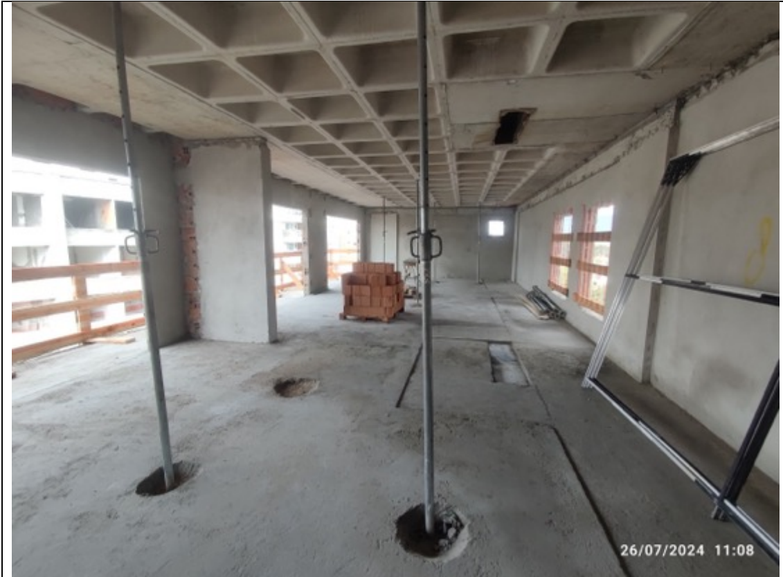
Foto 36 – Execução de chumbamento de contramarcos
