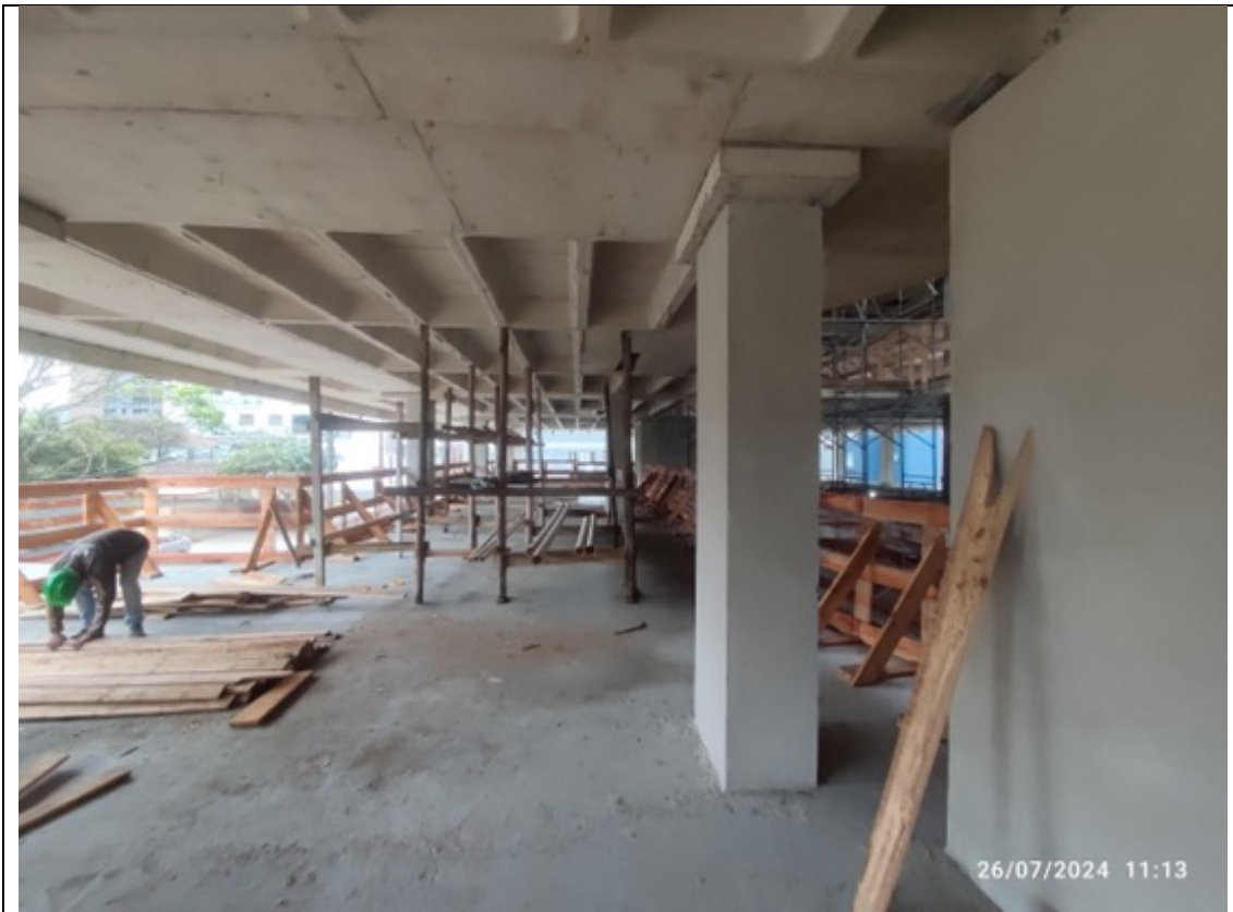
Foto 42 – Execução de proteções periféricas
