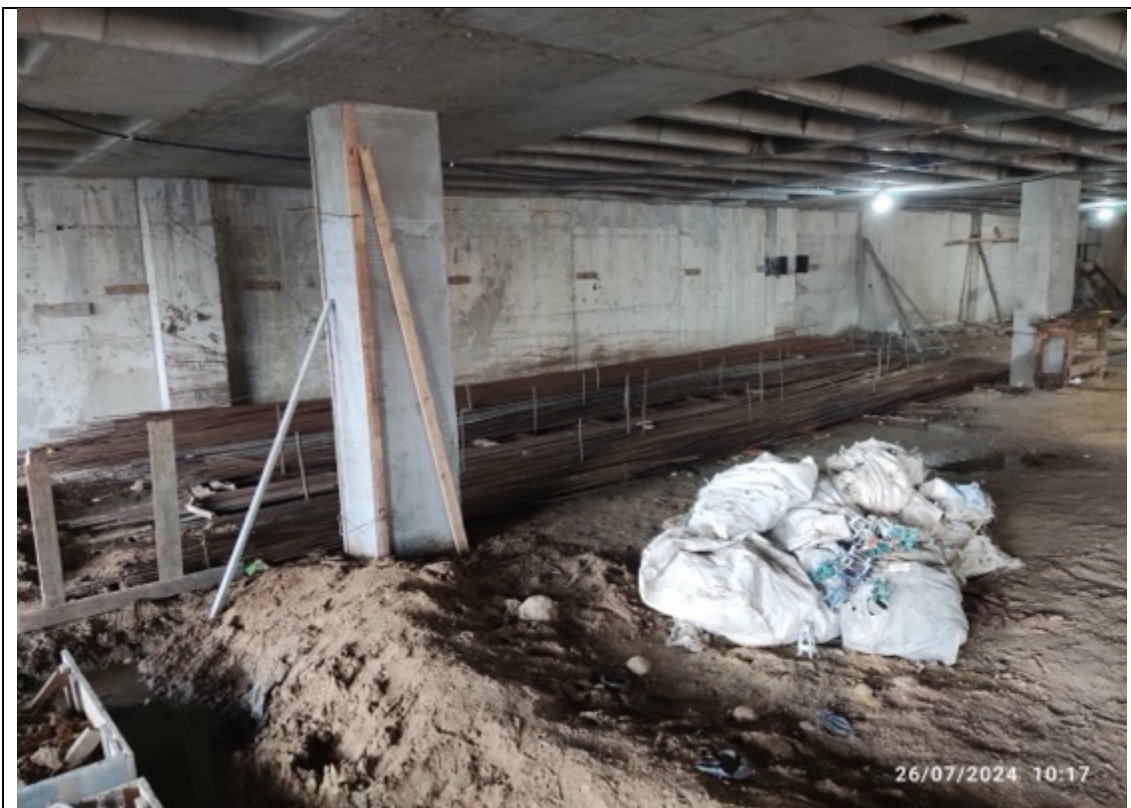
Foto 2 – Estoque de aço
