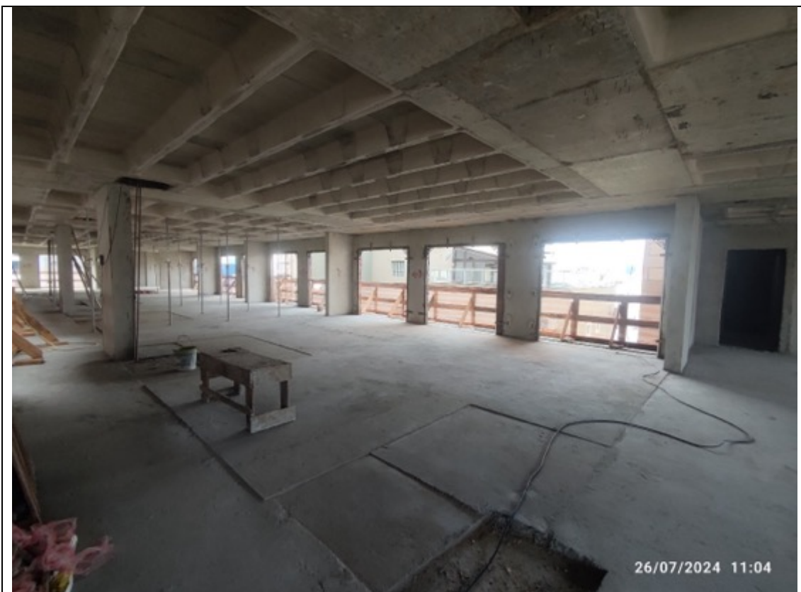
Foto 31 – Execução de chumbamento de contramarcos
