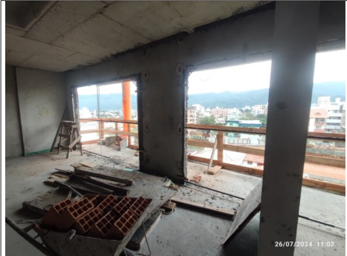
Foto 28 – Execução de chumbamento de contramarcos
