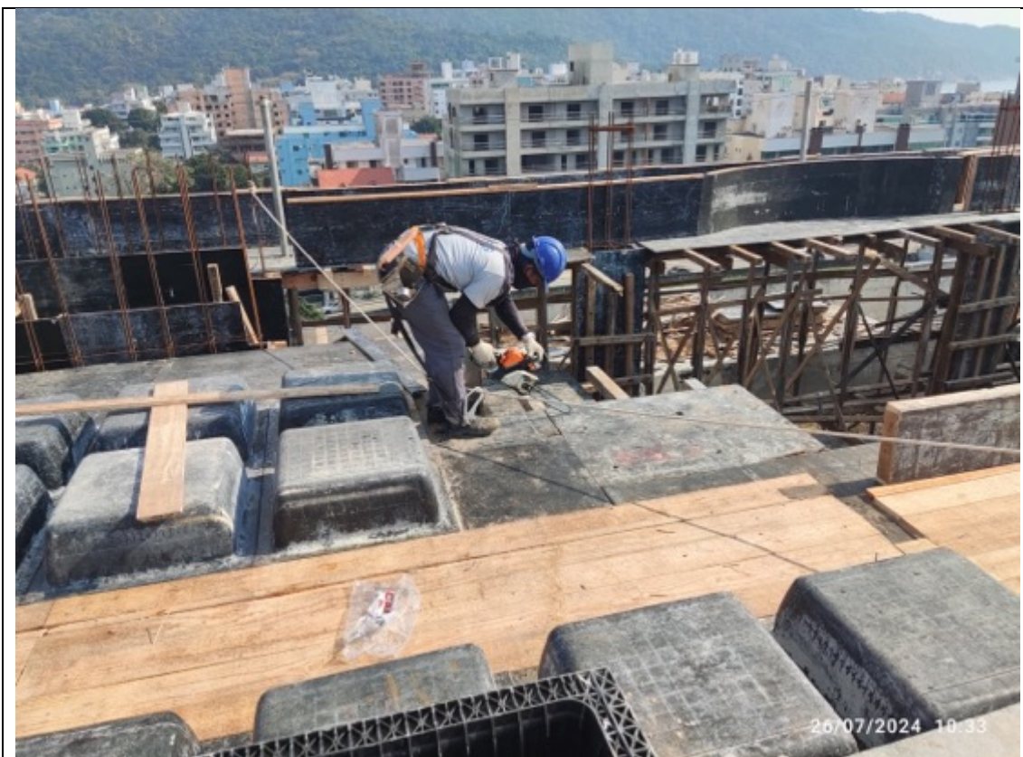
Foto 10 – Execução de forma do teto do restaurante
