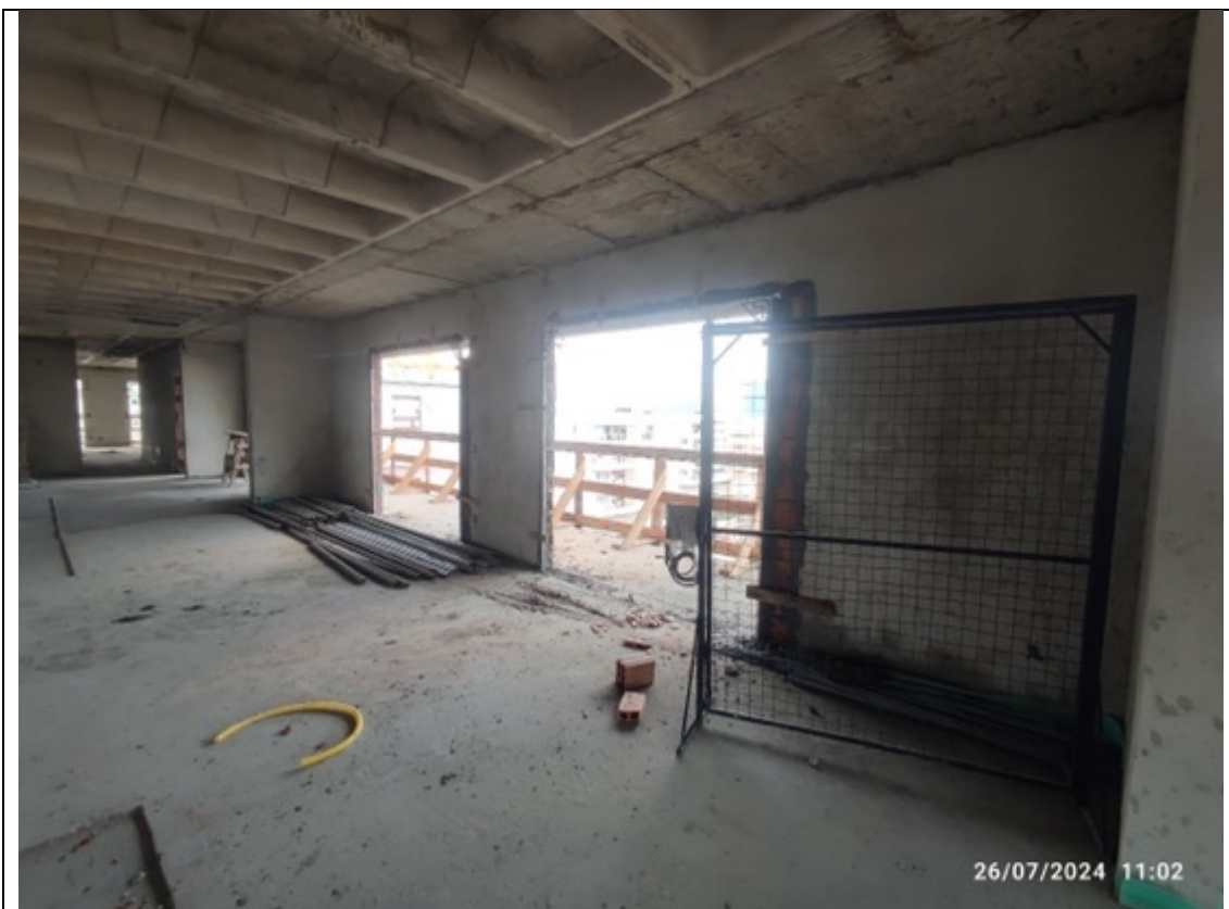
Foto 29 – Execução de chumbamento de contramarcos
