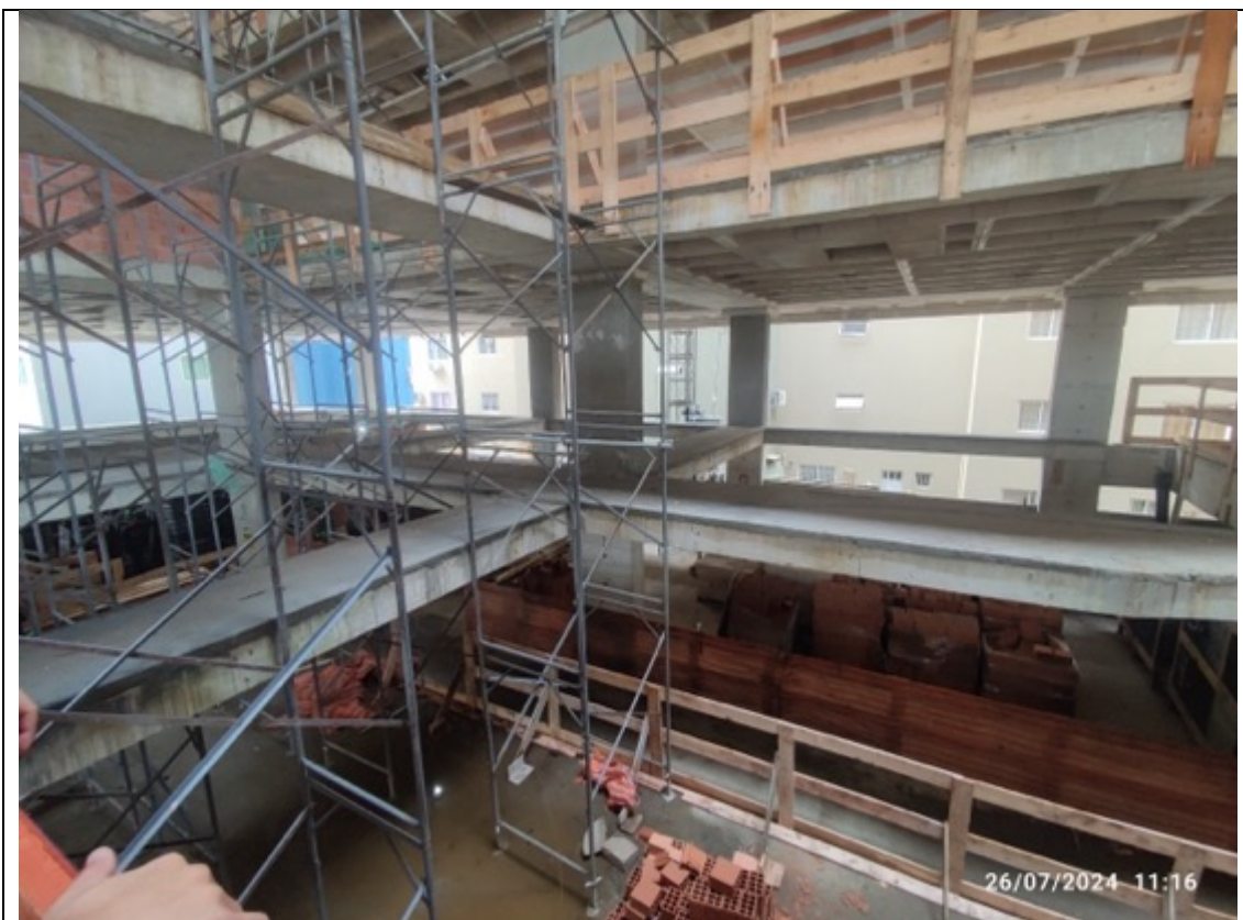
Foto 43 – Execução de proteções periféricas
