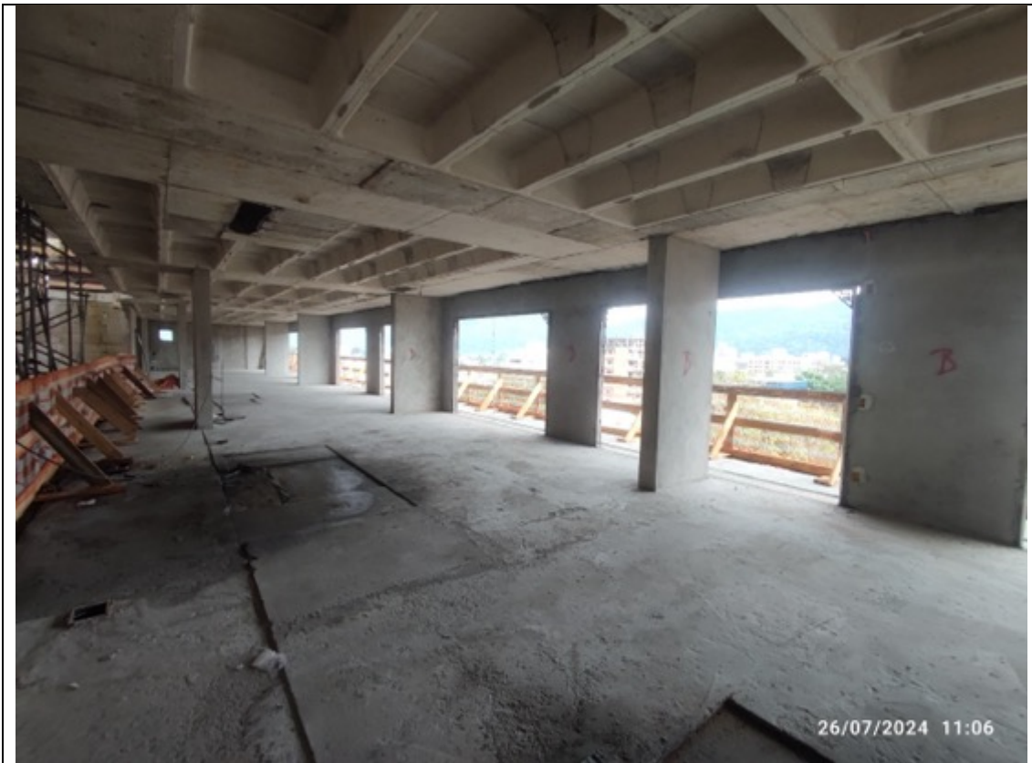
Foto 34 – Execução de chumbamento de contramarcos
