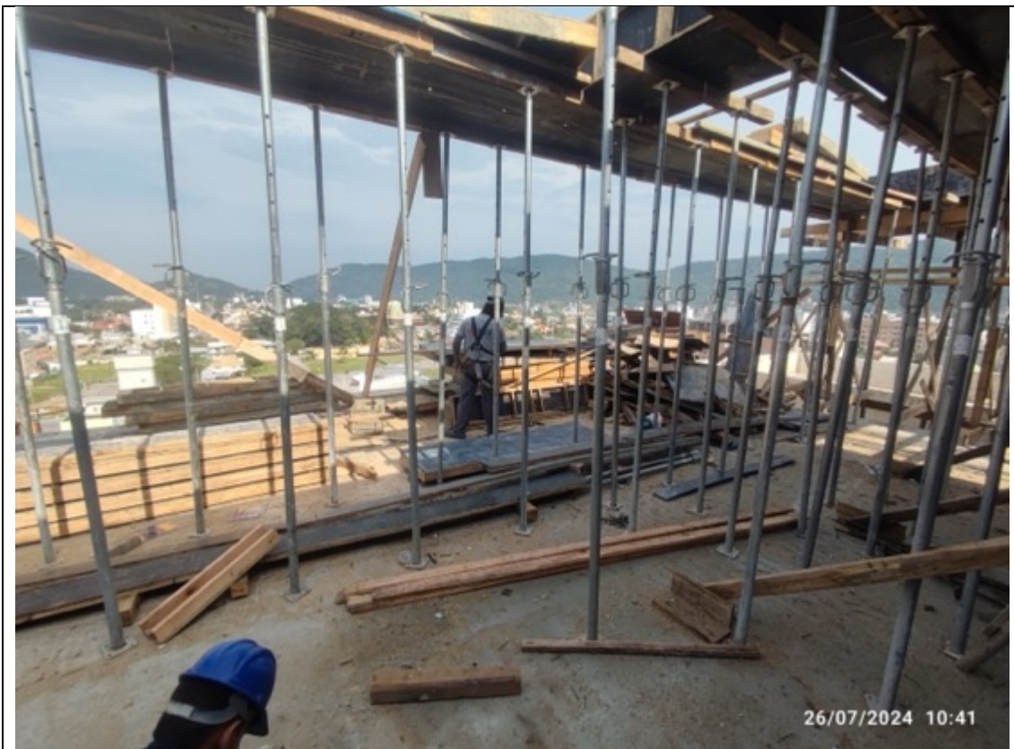
Foto 12 – Execução de forma do teto do restaurante
