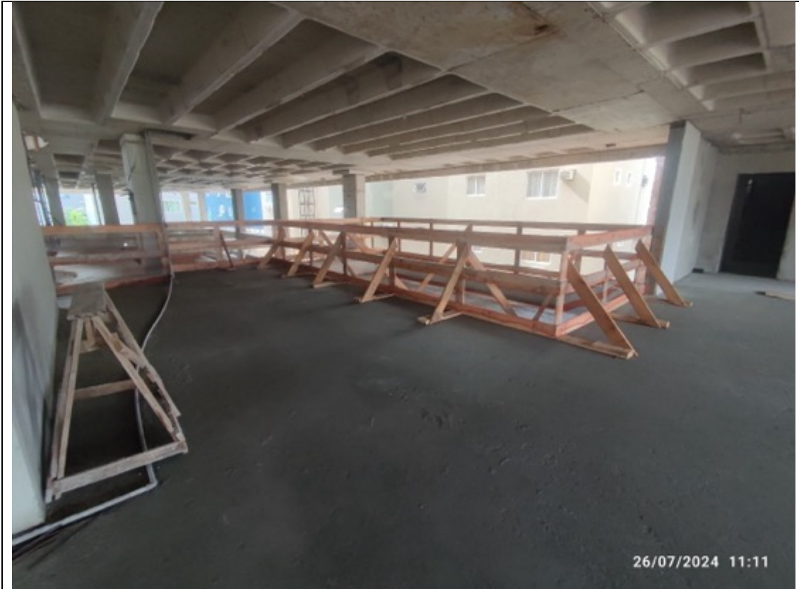
Foto 38 – Execução de proteções periféricas
