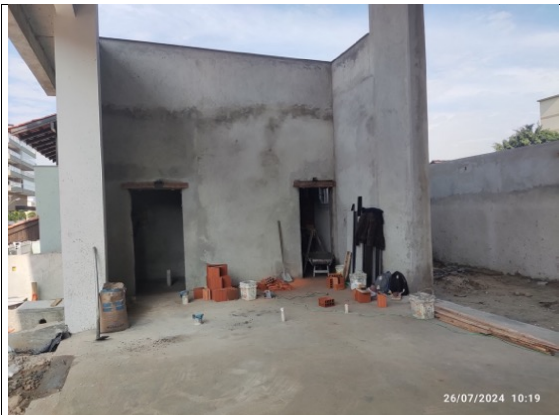
Foto 4 – Execução de reboco interno nos banheiros do hall
