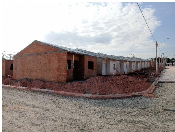
Pavimentação em execução
