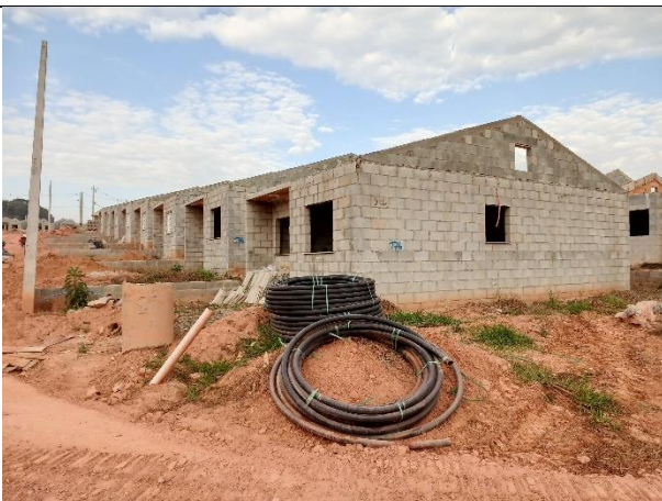
Postes e Casas em blocos
