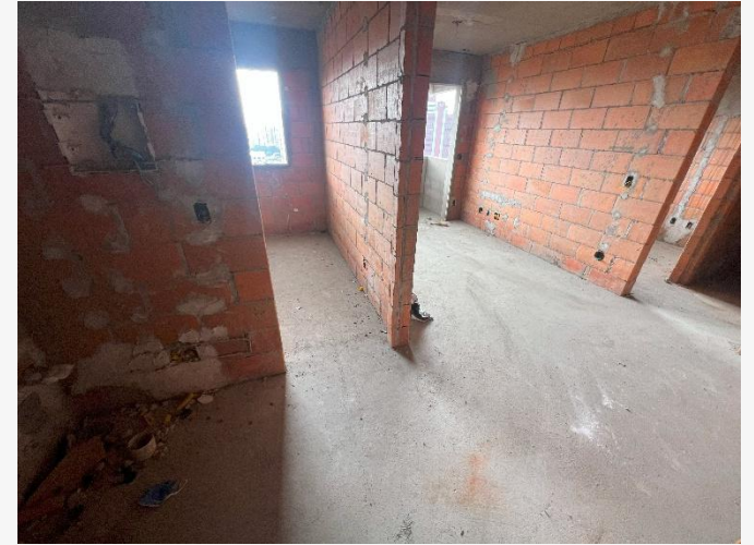
Contrapiso – 15º Pav
