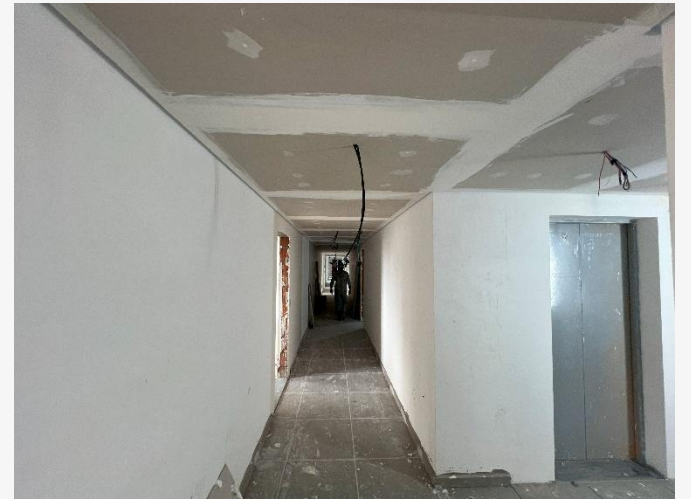
Forro de Gesso – 10º Pav
