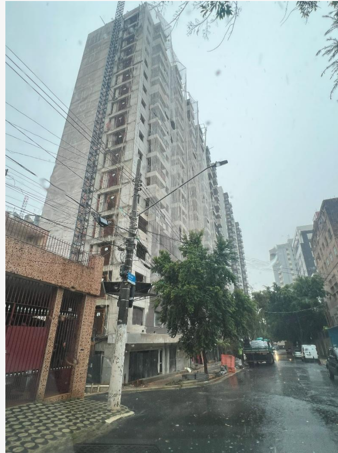
Vista Fachada Lateral
