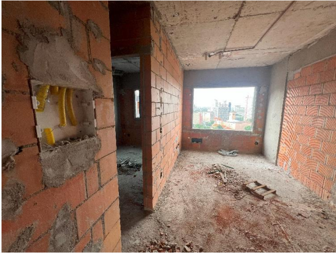
Embutidos em Alvenaria – 17º Pav
