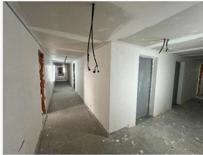
Forro de Gesso – 8º Pav
