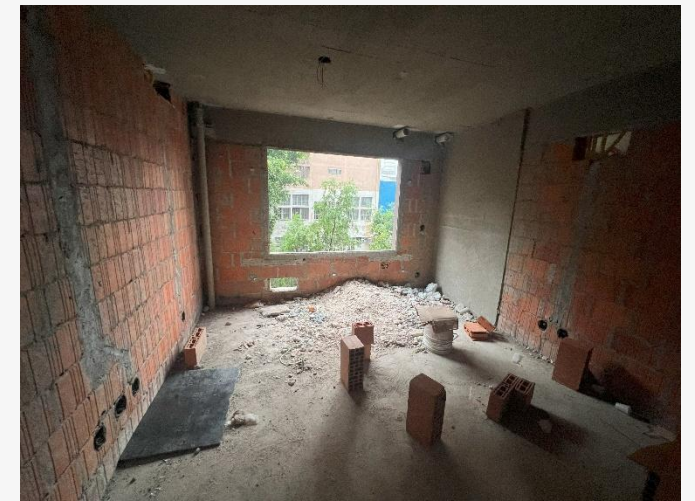
Alvenaria/ Vedação – 2º Pav
