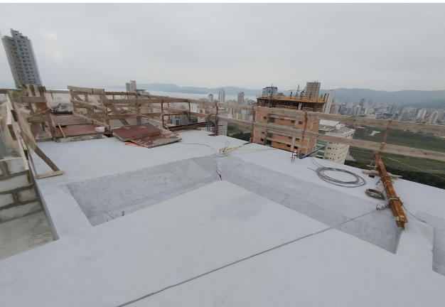
Foto 7 - Última laje, heliponto
