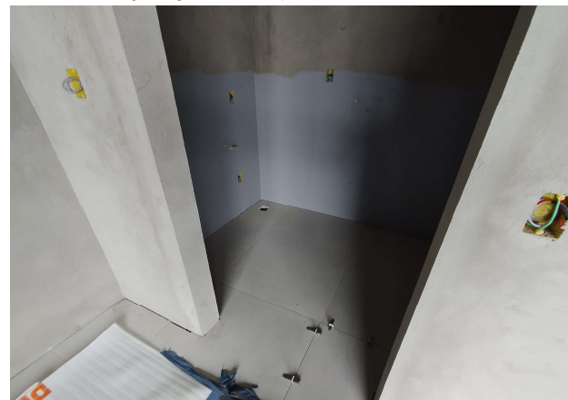
Foto 12 - 20º tipo impermeabilização finalizada
