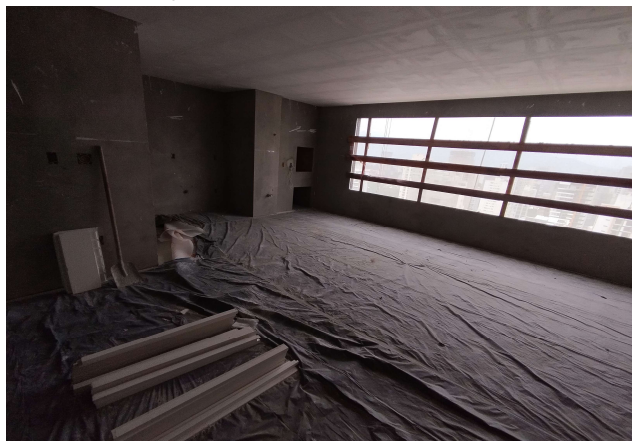
Foto 13 - 18º enfição do hall finalizado
