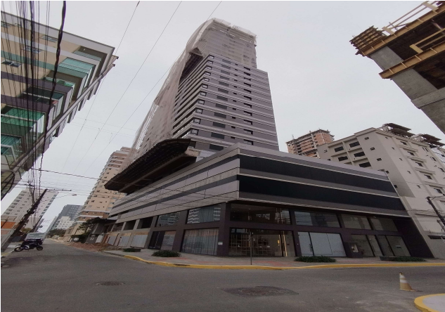
Foto 1 - Fachada La Joie
