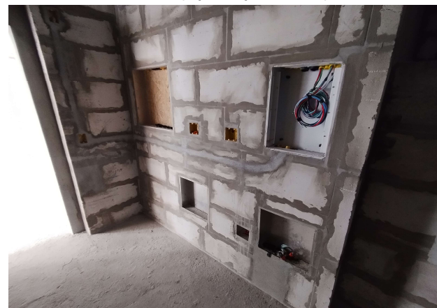
Foto 14 - Desbaste de emboço para impermeabilização
