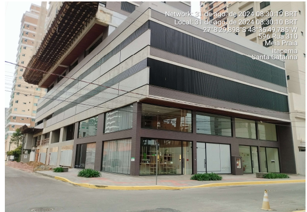
Foto 4 - Térreo, área comercial finalizada
