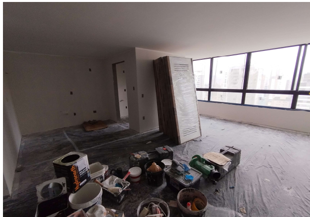
Foto 18 - 12º Pav tipo execução de pintura
