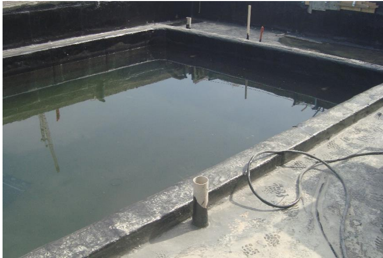
Impermeabilização da Piscina – 20º Pav
