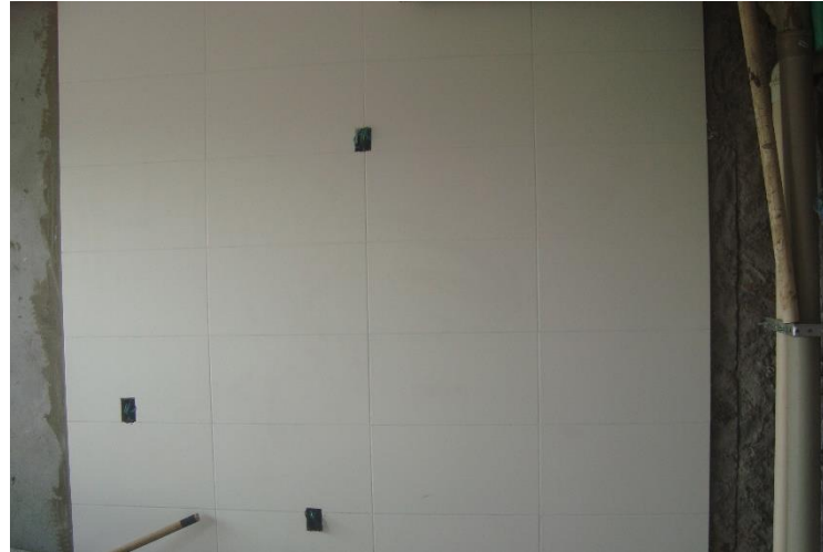
Revestimento Cerâmico – 19º Pav
