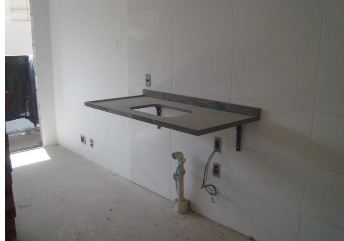
Revestimento Cerâmico – 6° Pav
