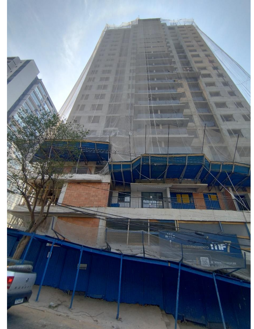
Vista da Fachada Frontal
