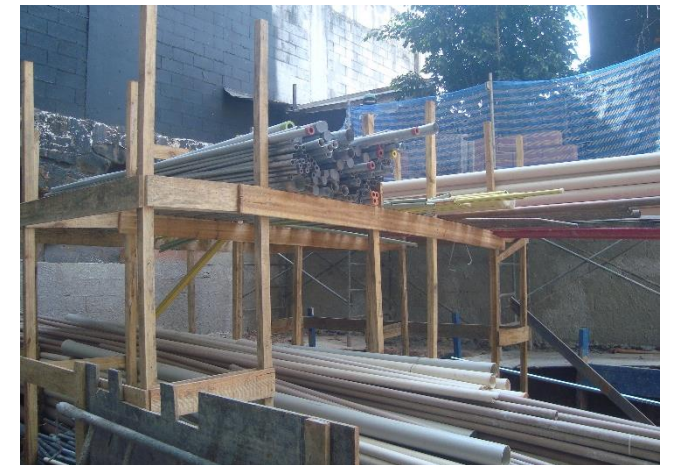
Estoque de Obra (Tubos)
