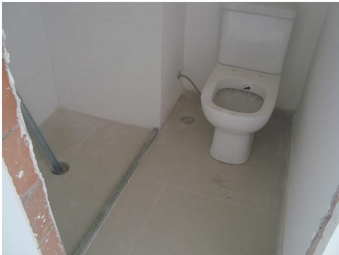
Piso Cerâmico – 5° Pav
