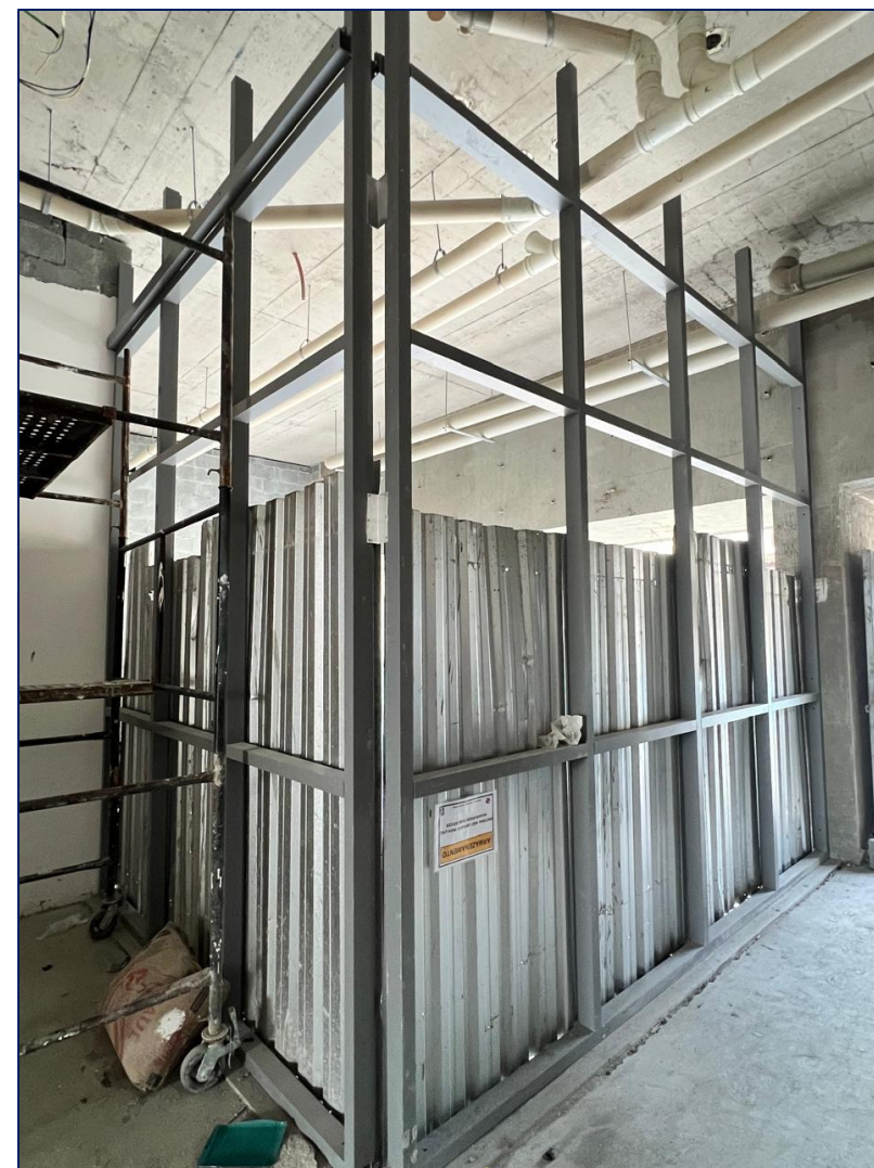
Foto 20 – Instalação de caixilho de área comum
