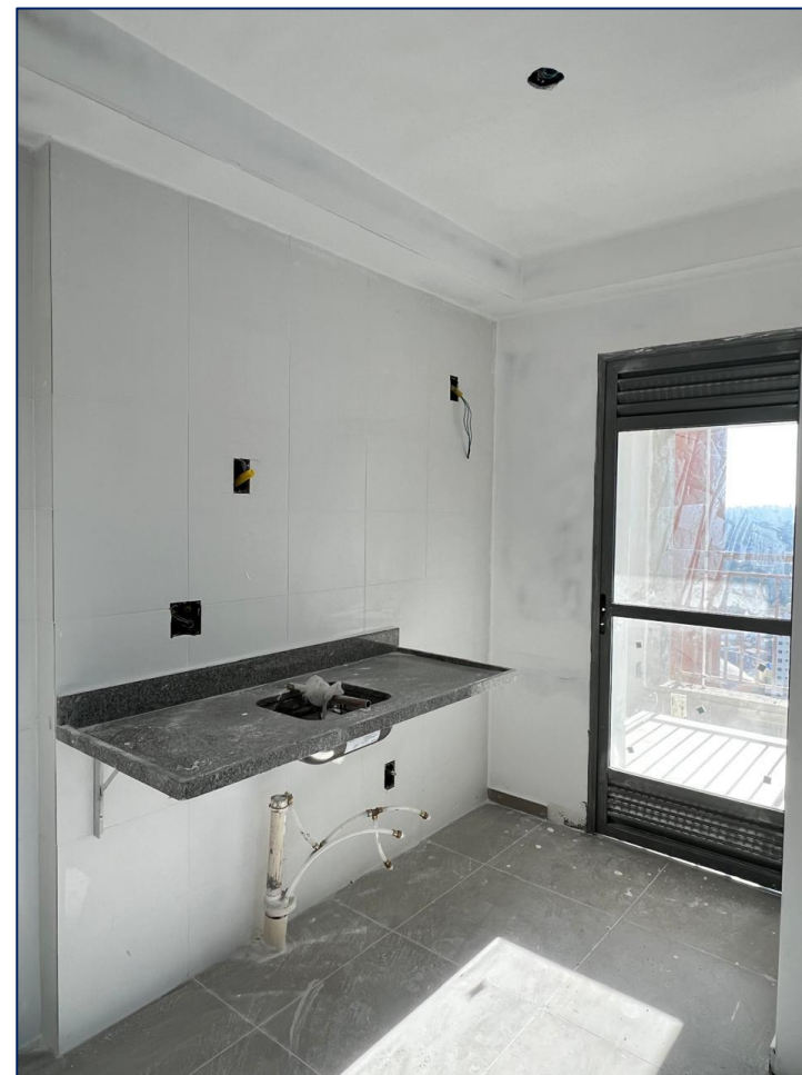
Foto 8 – Bancada e caixilho - 20º pavimento
