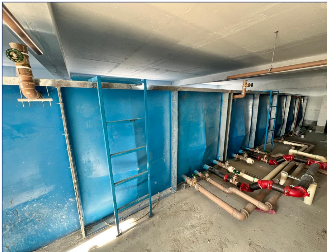
Foto 3 - Visão geral do barrilete e reservatórios montados
