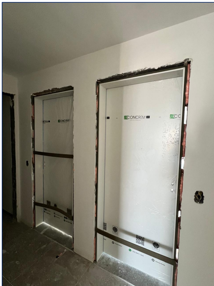
Foto 9 – Instalação de portas de entrada - 20º pavimento
