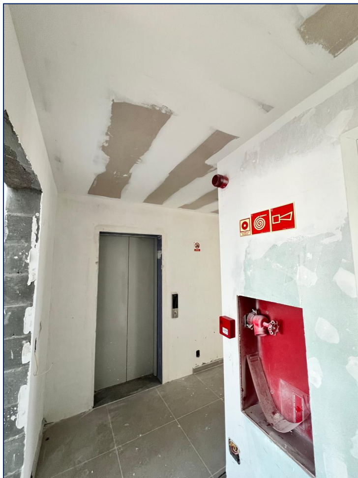
Foto 7 – Forro hall – 20º pavimento
