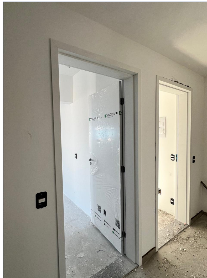
Foto 14 – Instalação de portas – 15º pavimento
