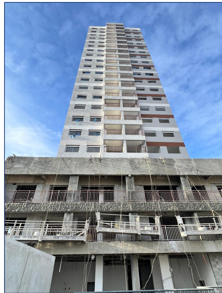
Foto 2 - Visão geral torre, início da textura
