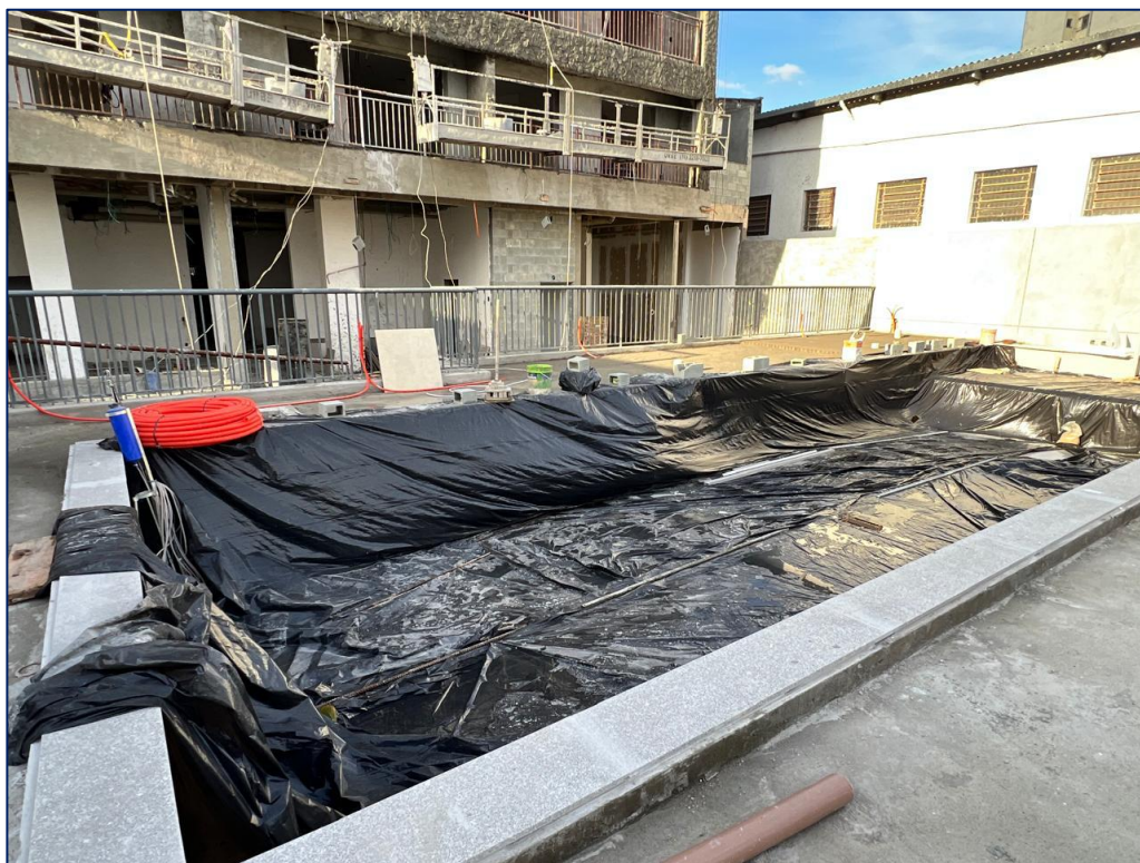
Foto 19 – Em finalização emboço da piscina
