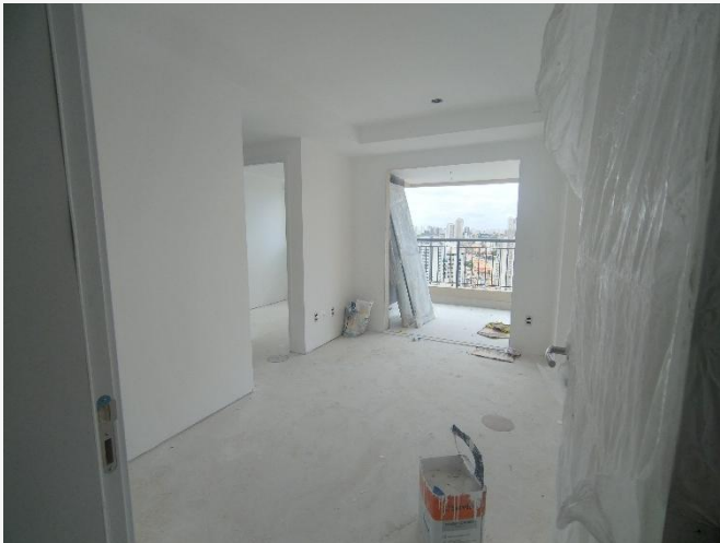
Pintura Interna – 5° Pav.
