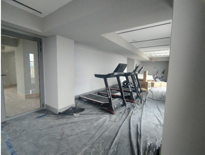
Pintura Interna – 26° Pav.
