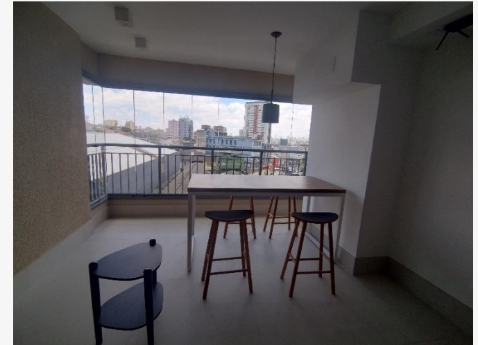
Pintura em Textura – 2º Pav.
