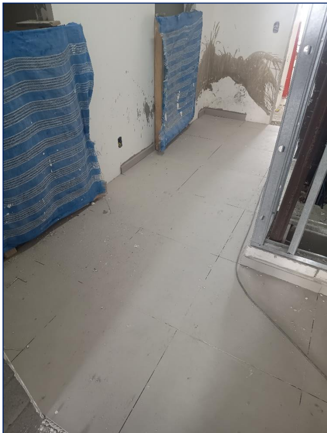
Foto 13 - Cerâmica hall residencial - 3º pav
