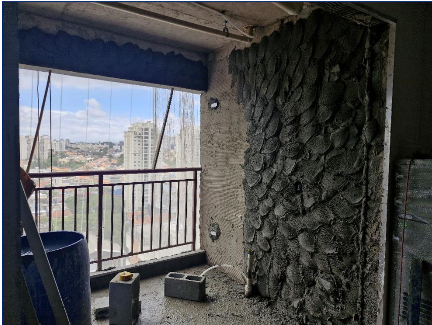
Foto 9 - Aplicação massa externa - 9º pav
