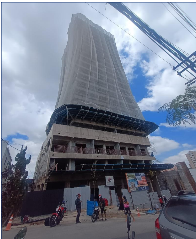
Foto 1 - Visão geral frente obra
