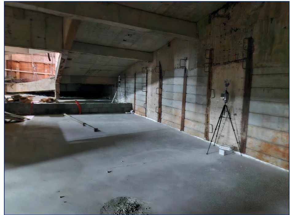
Foto 16 - Contrapiso 2º subsolo
