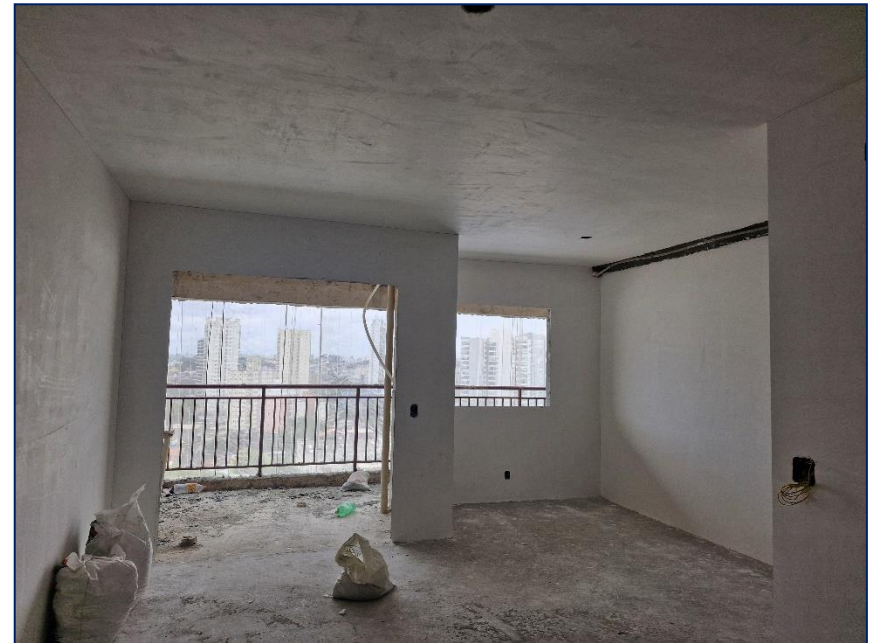
Foto 6 - Visão geral unidade com gesso - 15º pav
