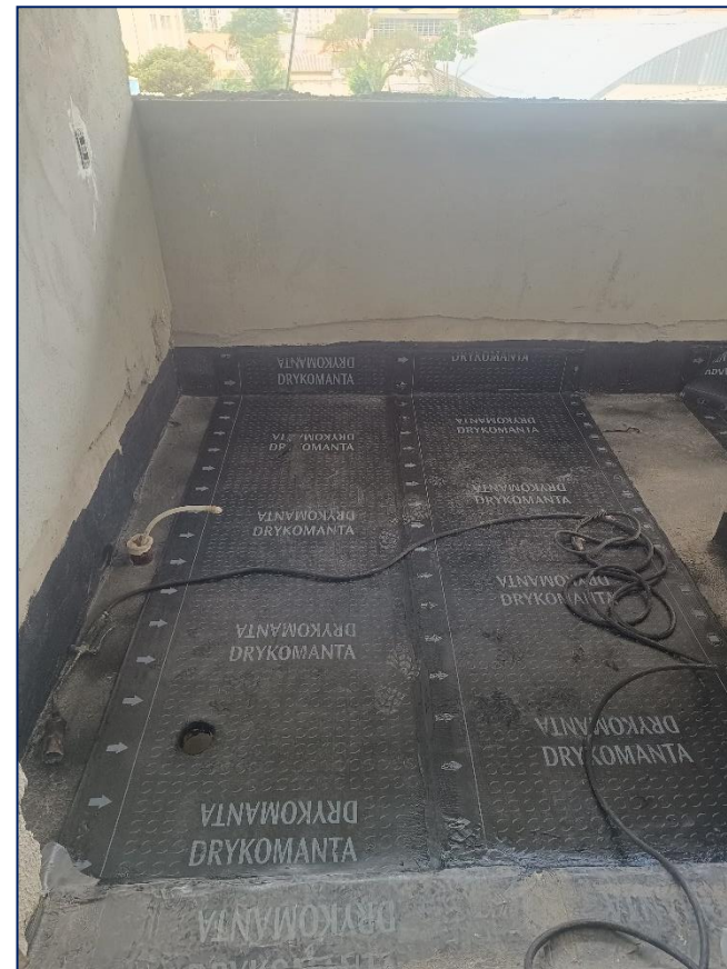
Foto 14 - Instalação manta terraço - 3º pav
