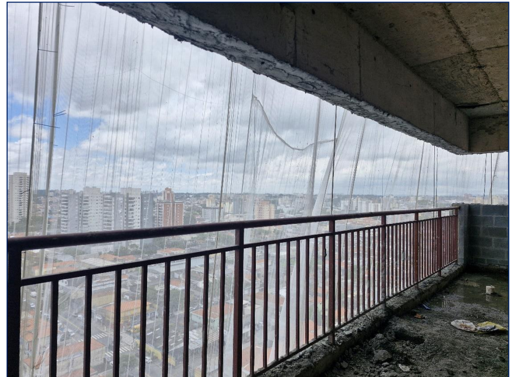
Foto 4 - Gradil terraço - 21º pav
