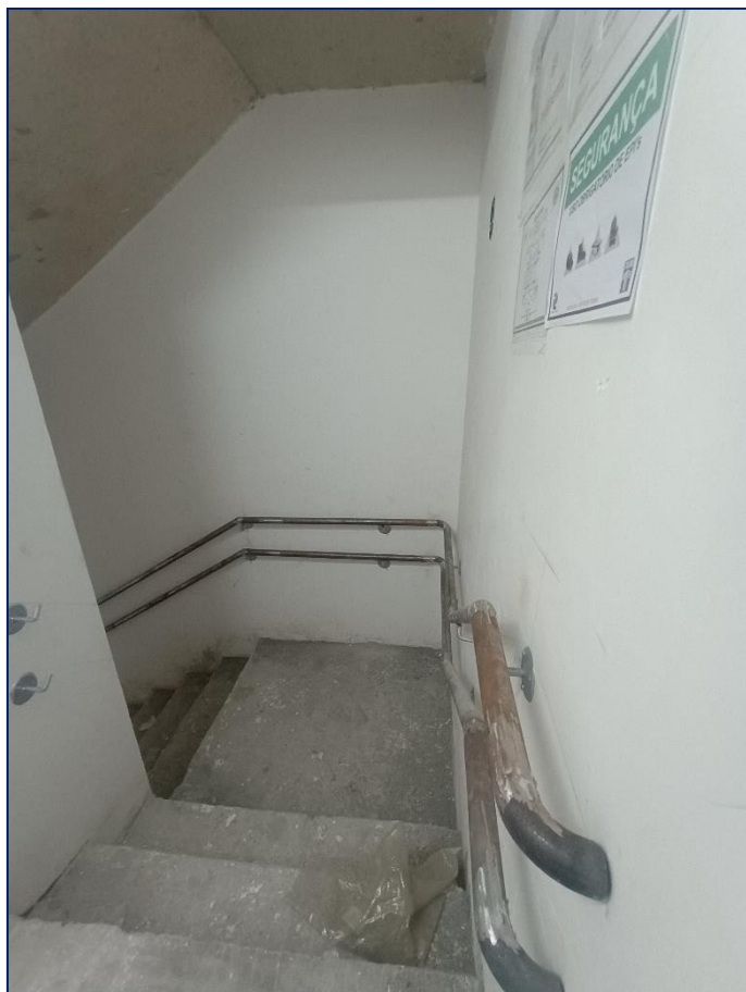
Foto 11 - Corrimão escadaria - 6º pav
