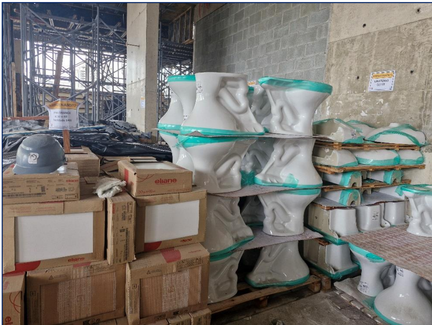
Foto 17 - Louças e cerâmicas entregues na obra
