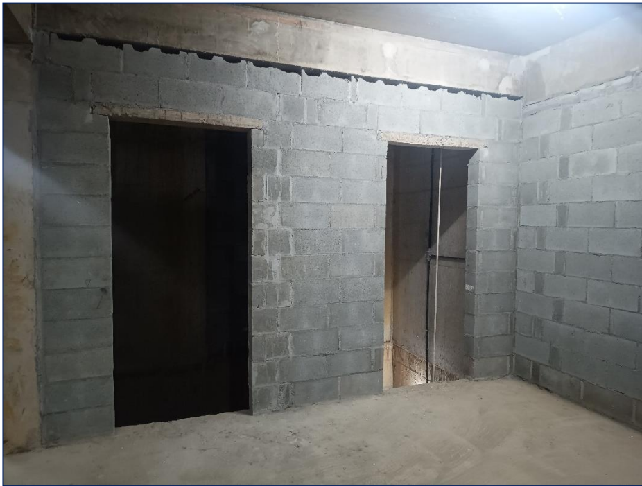
Foto 15 - Poço elevadores - 2º subsolo
