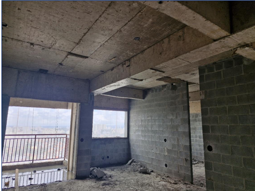
Foto 3 - Elevação alvenaria - 21º pav
