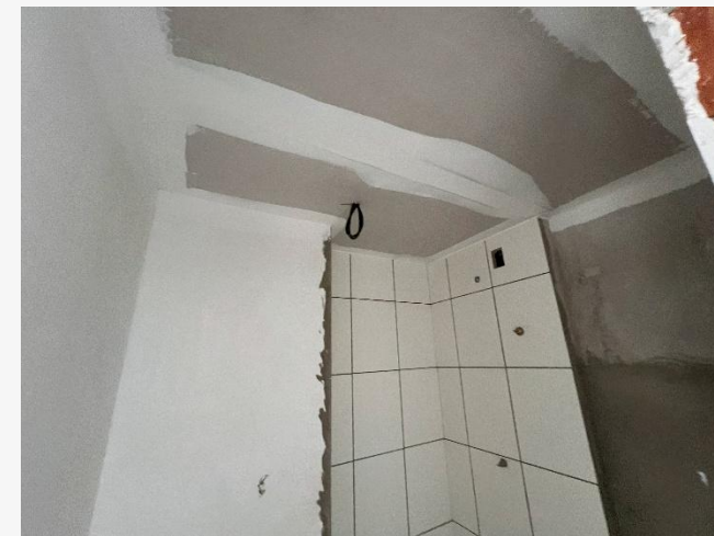
Revestimento Cerâmico – 15º Pav.
