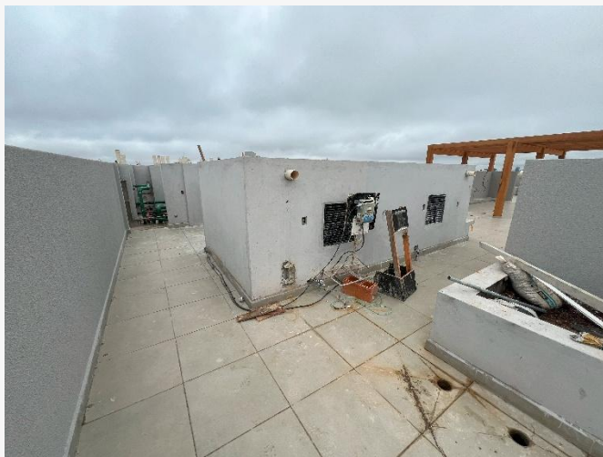
Vista Geral – Cobertura
