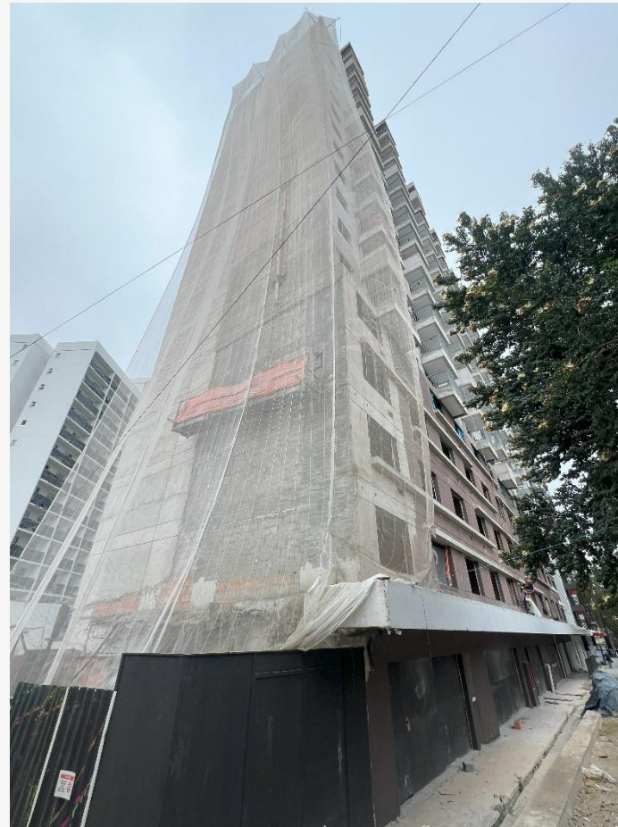
Vista Fachada Lateral
