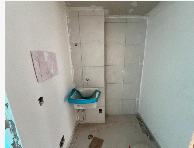
Lavatório – 9º Pav.
