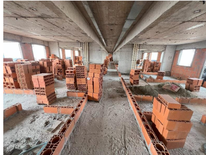
Marcação de Alvenaria – 16º Pav
