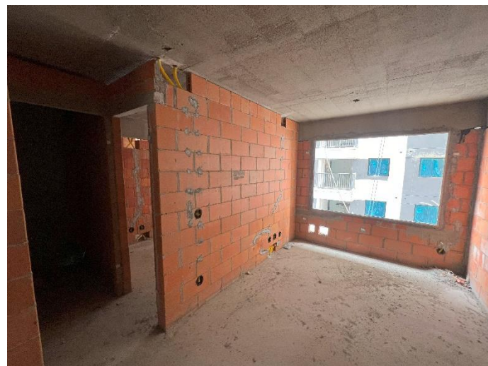
Alvenaria/ Vedação – 4º Pav
