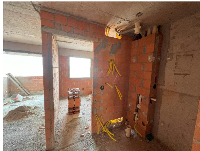
Embutidos em Alvenaria – 11º Pav
