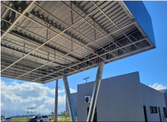
03 Execução de Revestimento - Forro e Platibanda do Pórtico.
