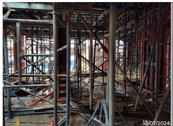
06 Térreo - Escoramento de trabalho.
