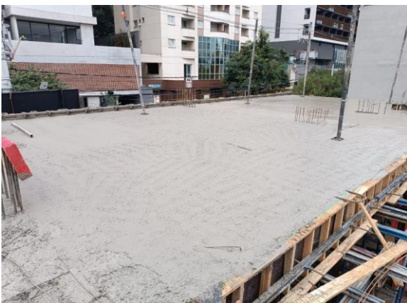
05 Laje do 1ºandar sendo concretada.
