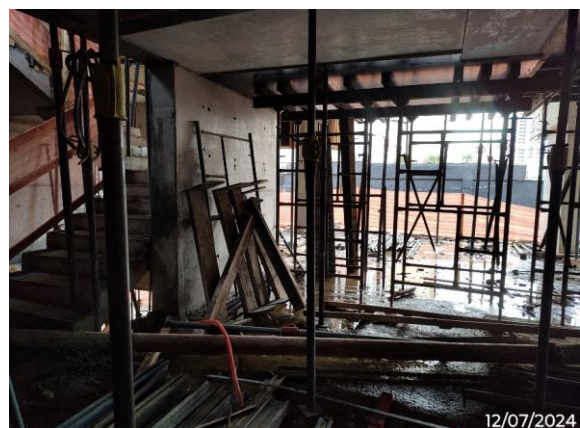
12 2ºSubsolo - Em reescoramento.
