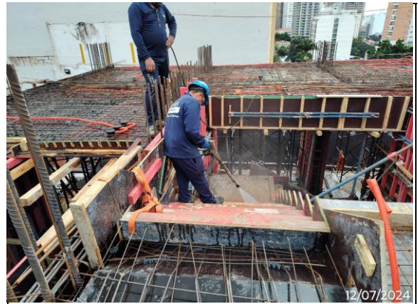
04 Formas de laje para concretagem do 1ºandar.
