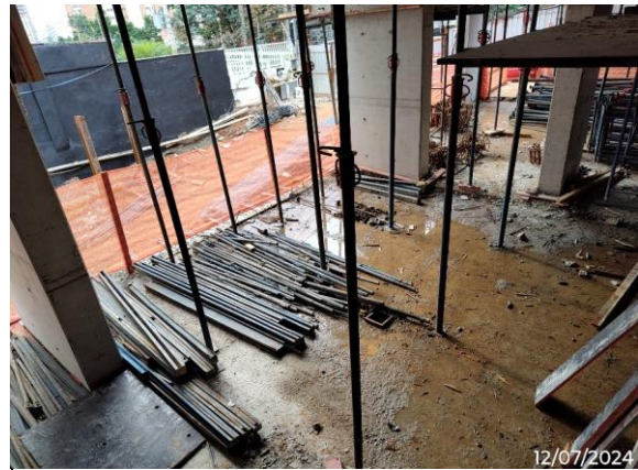
08 1ºSubsolo - Em reescoramento.
