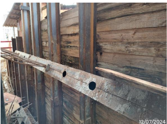
11 Cortina com pranchamento, longarina provisória de travamento dos tirantes.
