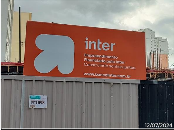
01 Placa do Banco Inter no tapume de obras.
