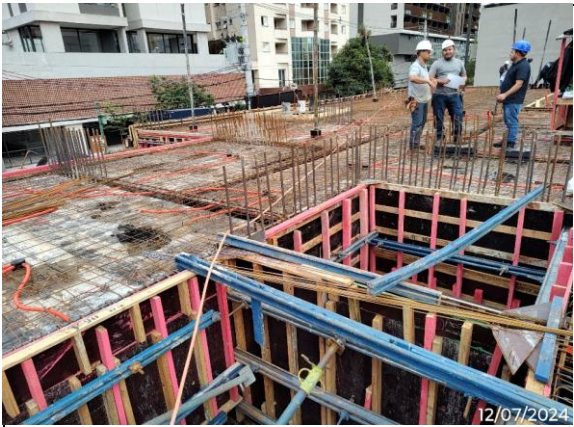
03 Formas de laje para concretagem do 1ºandar.
