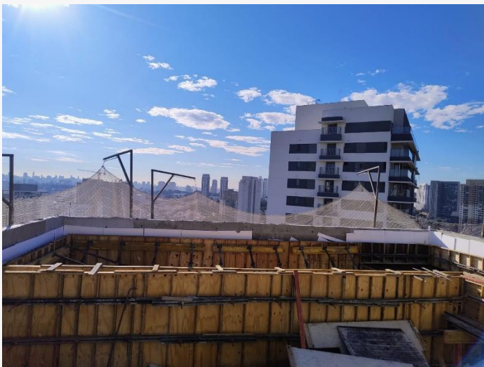
Forma da Piscina – Cobertura.
