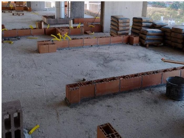
Marcação de Alvenaria – 20º Pav.
