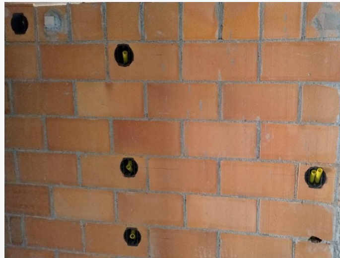
Embutidos em Alvenaria – 12º Pav.
