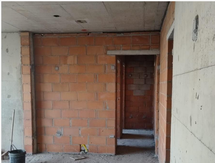
Alvenaria/Vedação – 15º Pav.
