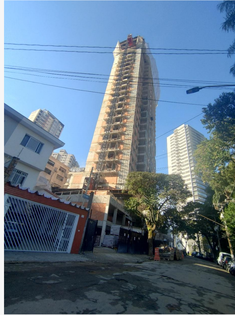
Vista da Fachada Lateral
