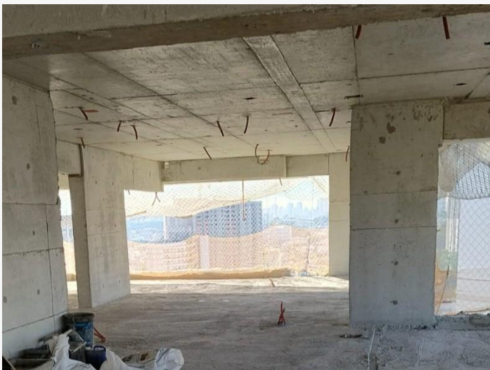
Vista Estrutura – 23º Pav.
