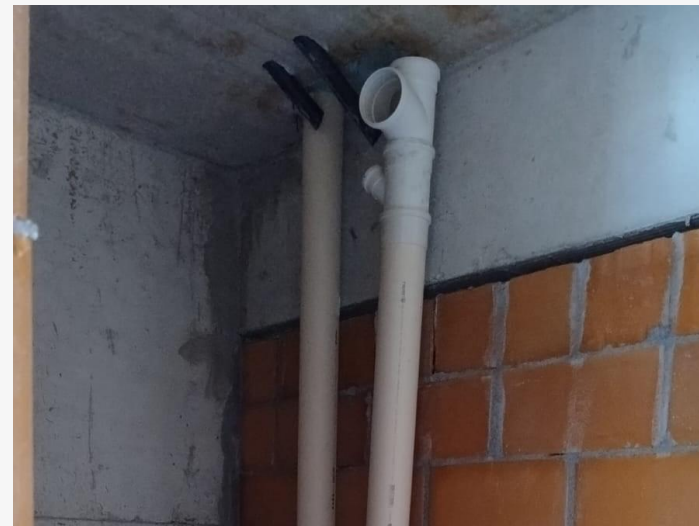
Prumada Hidráulica – 19º Pav.
