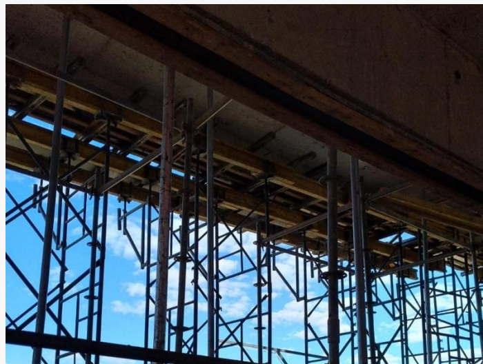
Cimbramento – 25º Pav.
