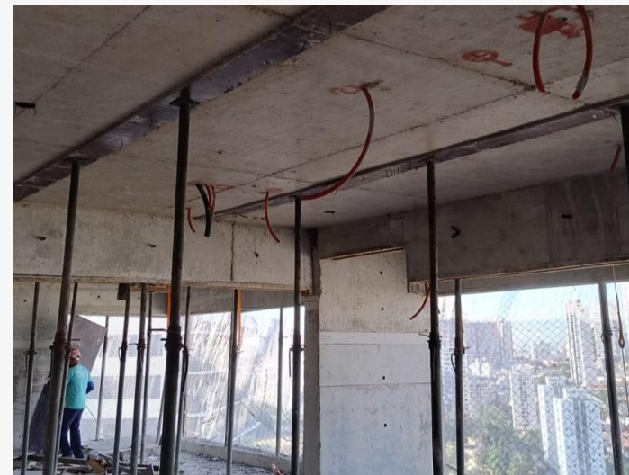
Escoramento – 24º Pav.
