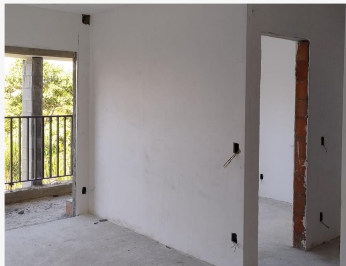
Pintura Interna – 05º Pav.
