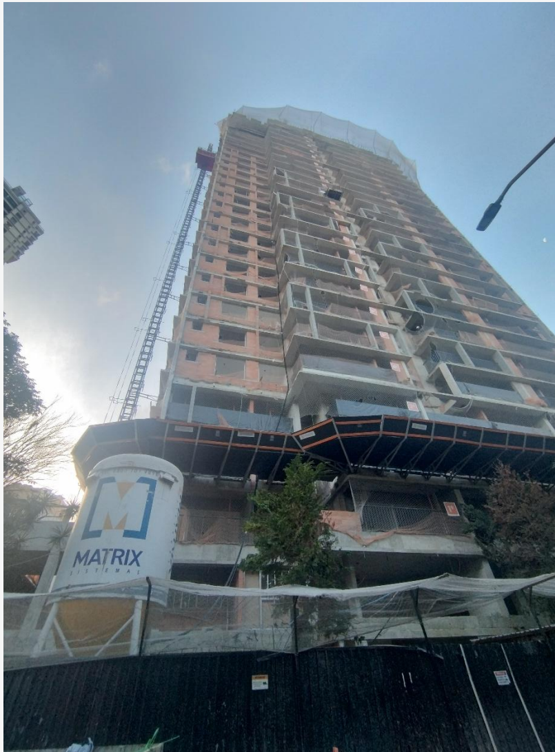
Vista da Fachada Frontal
